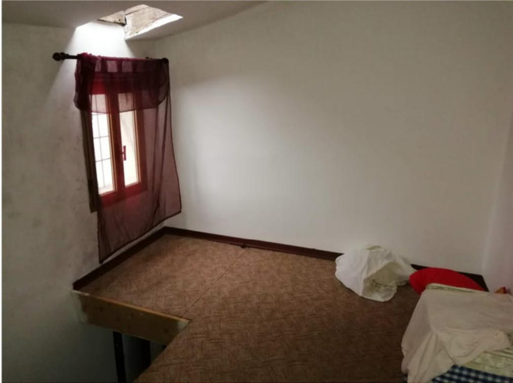
DISIMPEGNO AL SECONDO PIANO (SI NOTI L'ASSENZA DEL PARAPETTO)
