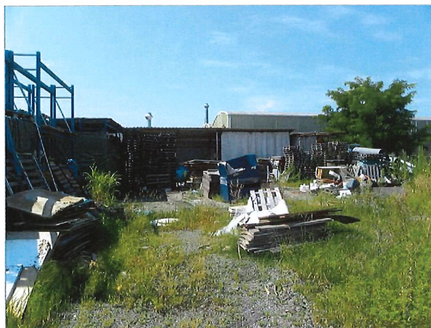
terreno edificabile, via Gallopat (figl 12 - mapp n°83) tettoia deposito, scaffali e varie insistenti sul lotto
