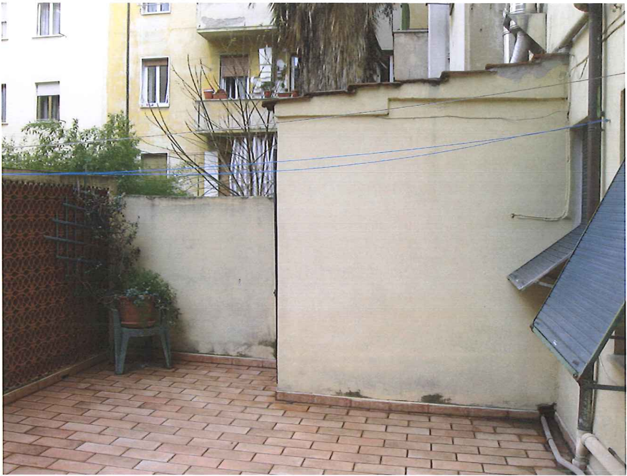
Figura 15 Terrazzo Scoperto Piano Primo
