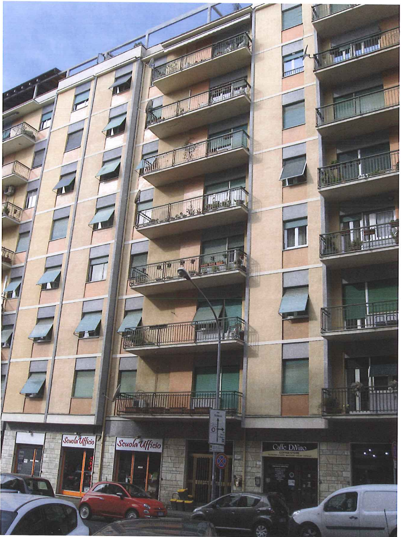
Figura 24 Facciata Prospetto Sud
