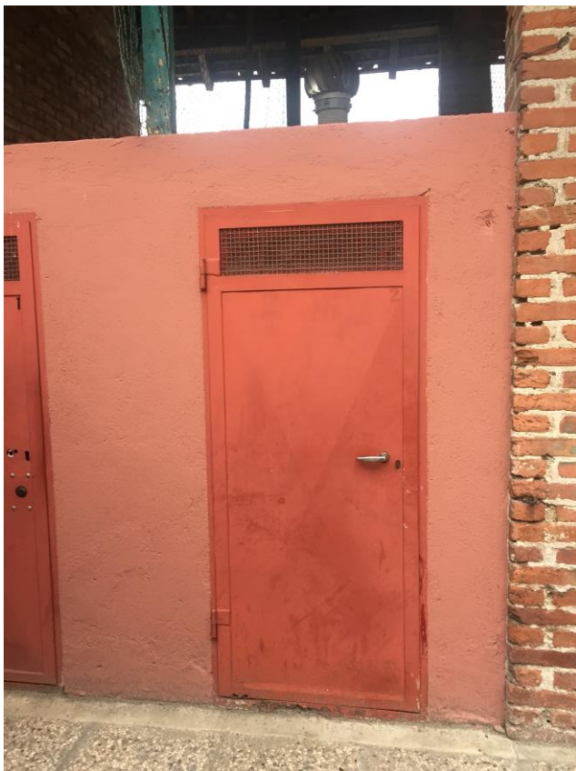
Vista porta ripostiglio mapp.193, sub 2
