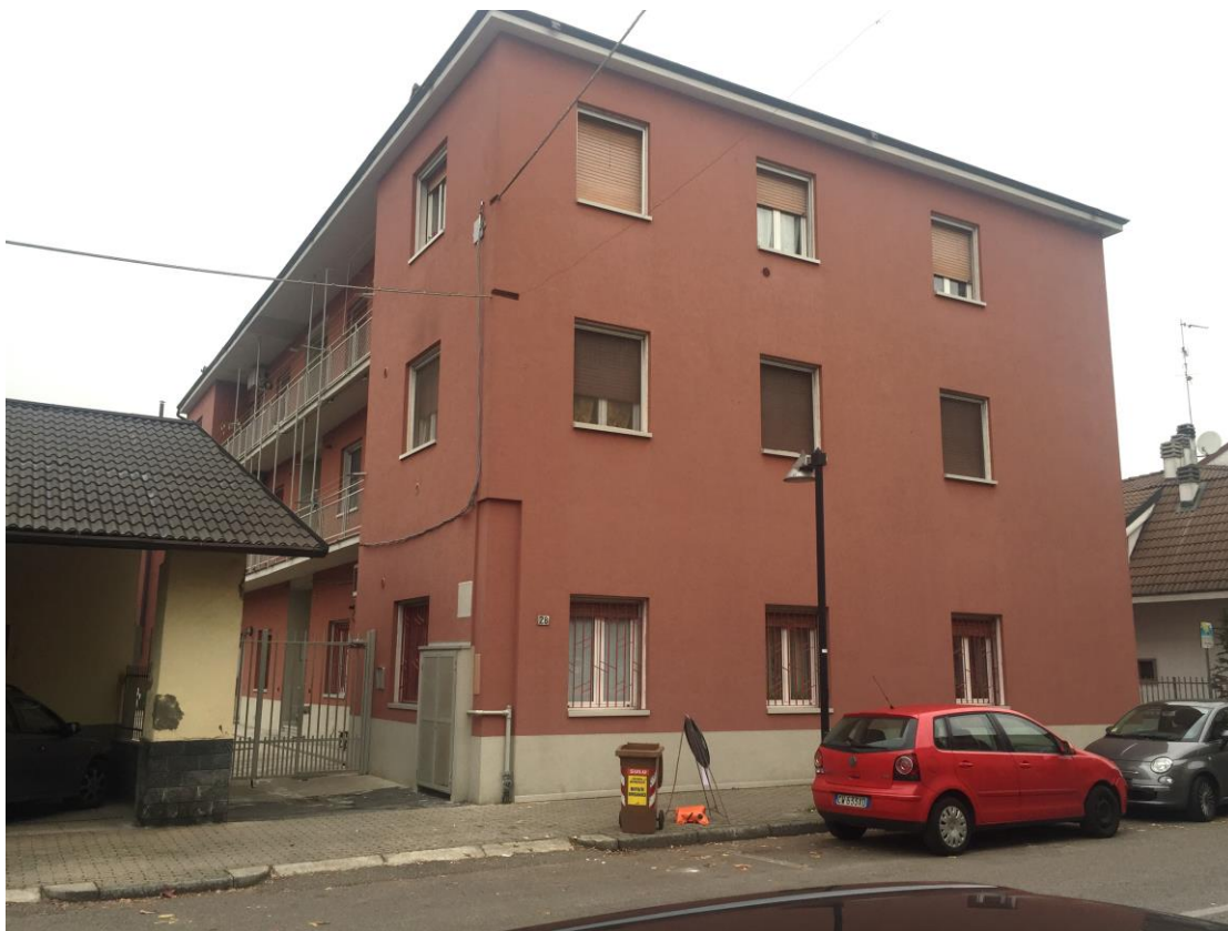
Vista del fabbricato da Via Luigi Cadorna 28
