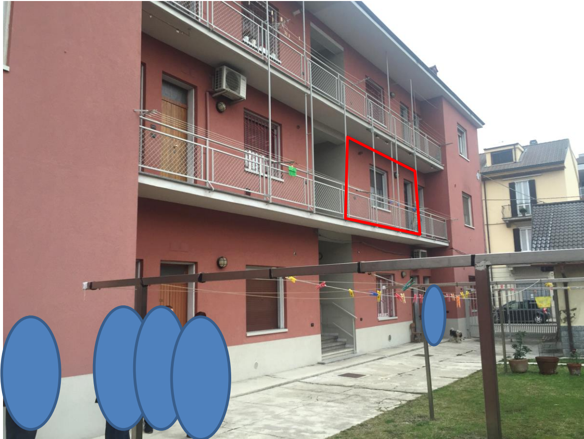
Vista al fabbricato dal cortile interno
