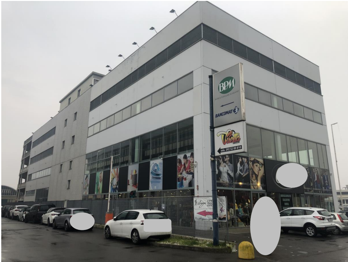
Viste del fabbricato da Via Leonardo da Vinci
