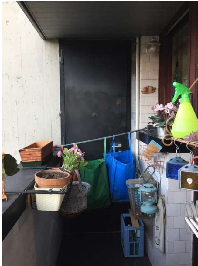
Foto 28 - Balcone lato cortile
