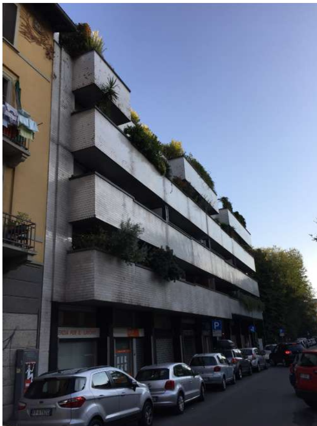
Foto 03 - Il fabbricato su via Rosellini
