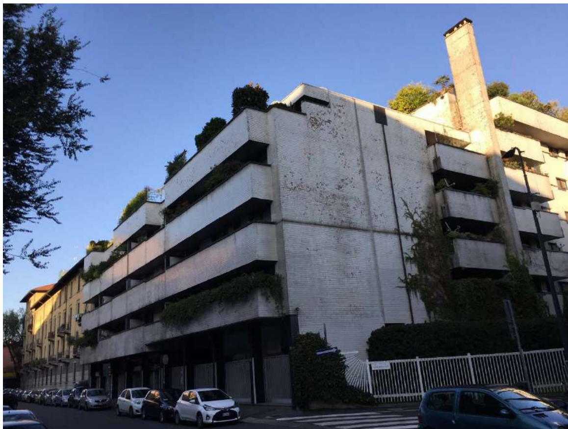
Foto 01 - Il fabbricato su via Rosellini angolo via Abbadesse
