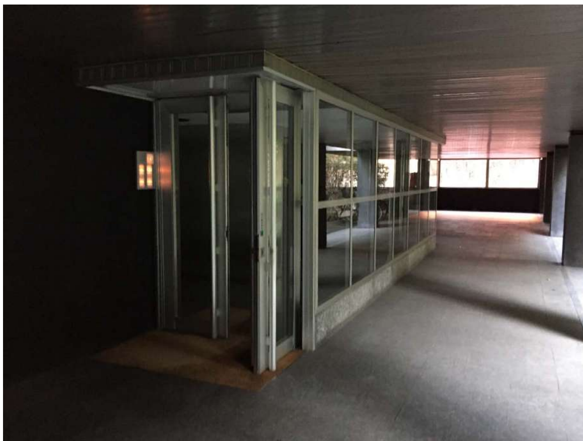
Foto 06 - Accesso comune alla scala D del piano terra
