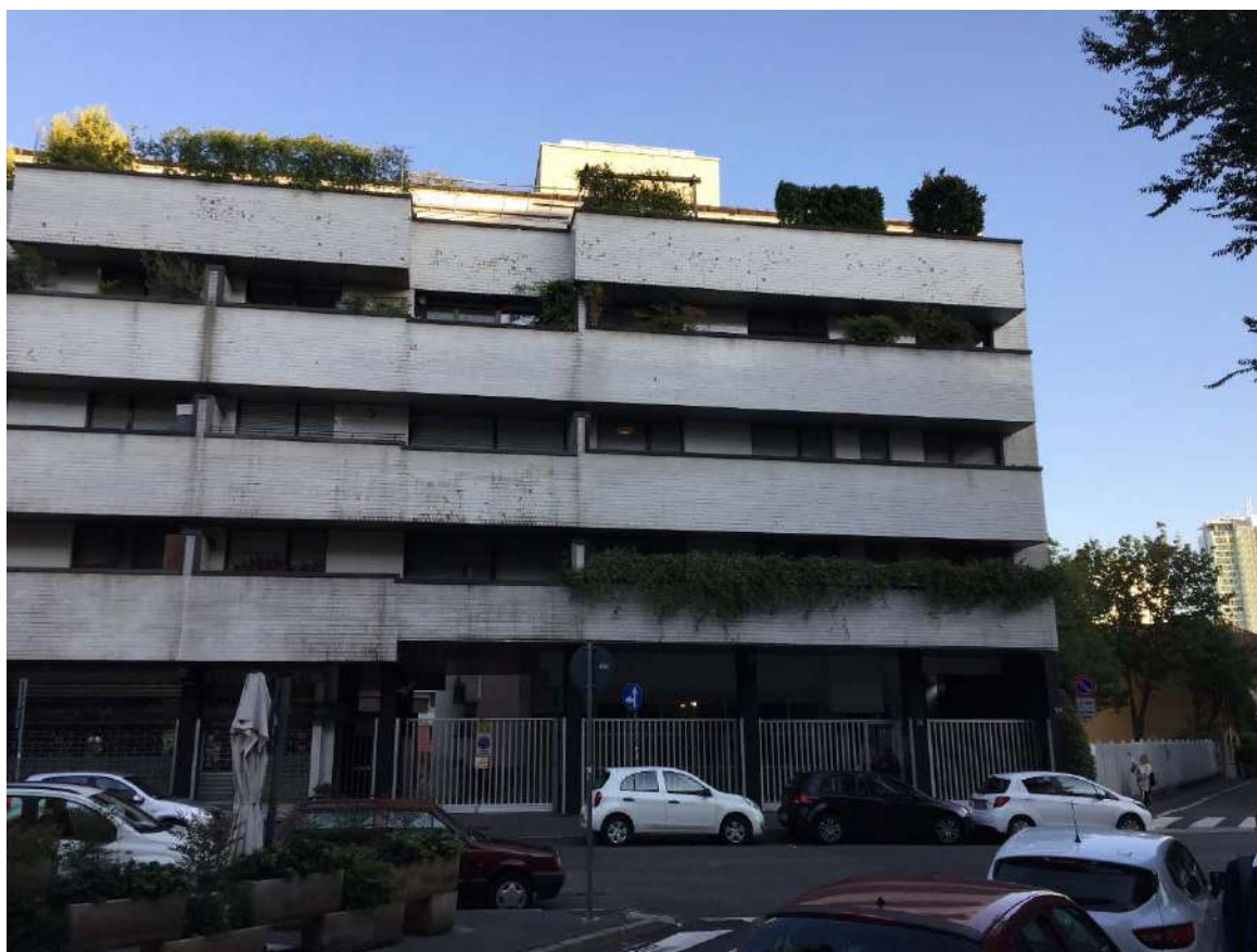
Foto 02 - Il fabbricato su via Rosellini
