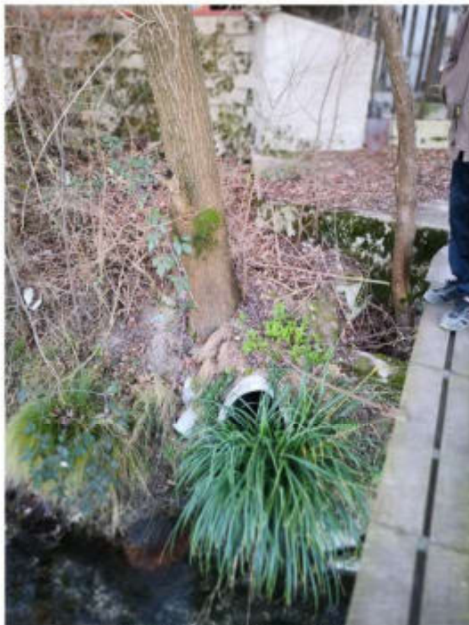
1.23 scarico acque reflue
