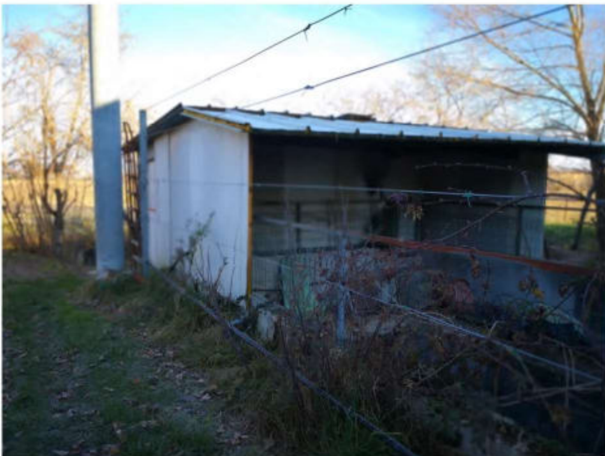
1.18 tettoia su vasca itticoltura
