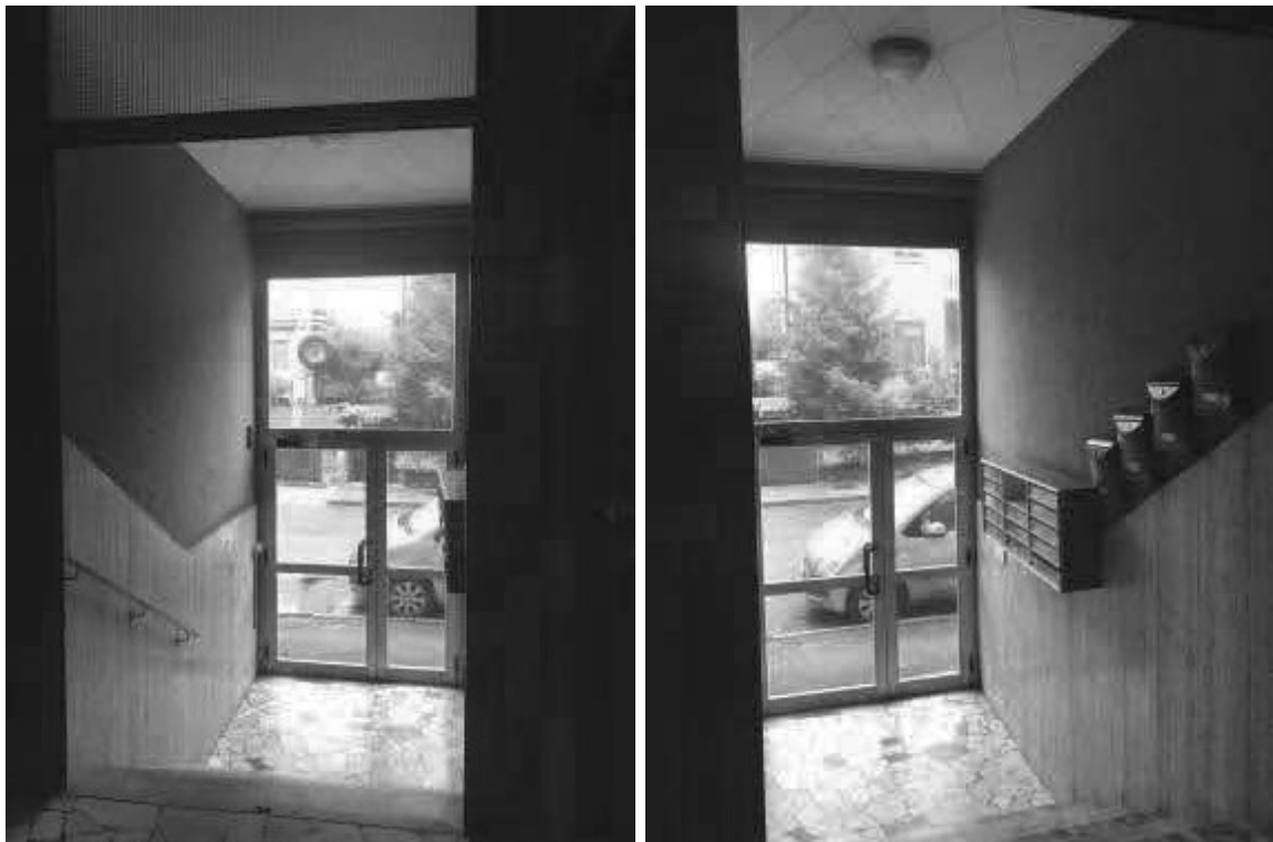
Immagine 4 e 5. Androne di ingresso; sulla destra collocazione delle caselle della posta.
