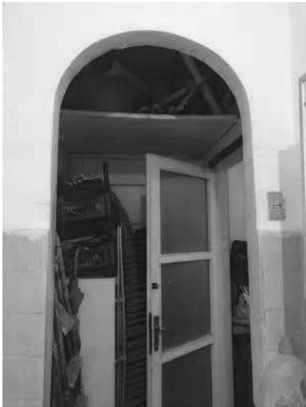
Immagine 18. Dettaglio dell'antibagno.
