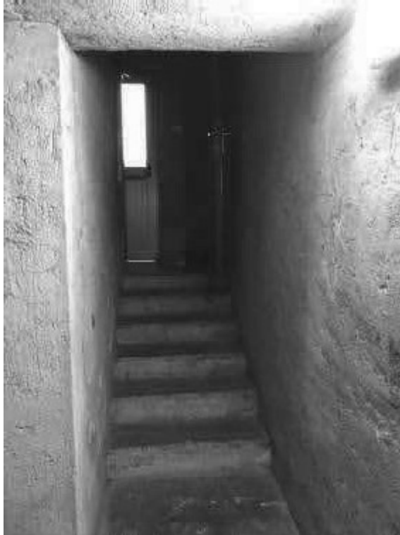
Immagine 22. La scala che consente l'accesso al piano seminterrato.
