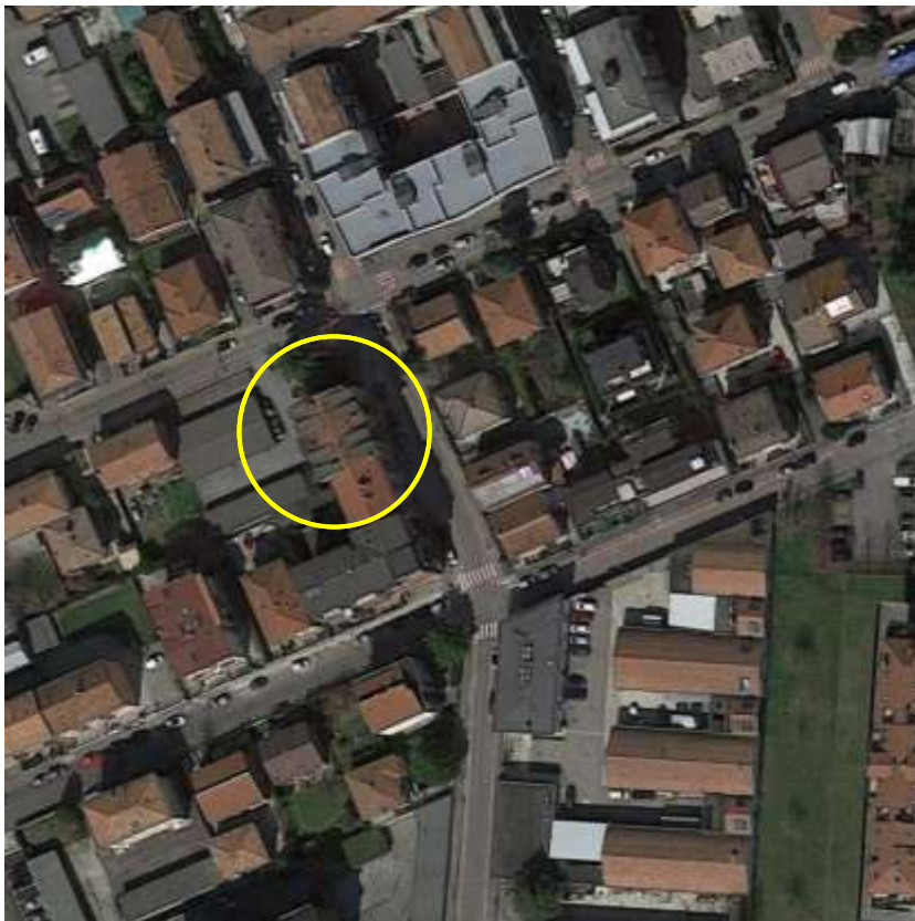
Immagini 1 e 2. Viste aeree del quartiere con in evidenza le posizioni dell'unità oggetto di valutazione.
