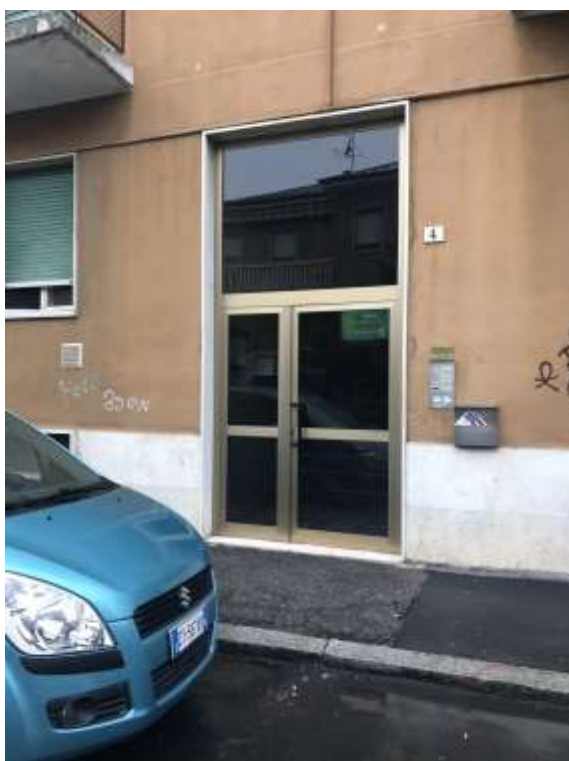
Immagine 3. Dettaglio del portoncino di accesso al fabbricato.
