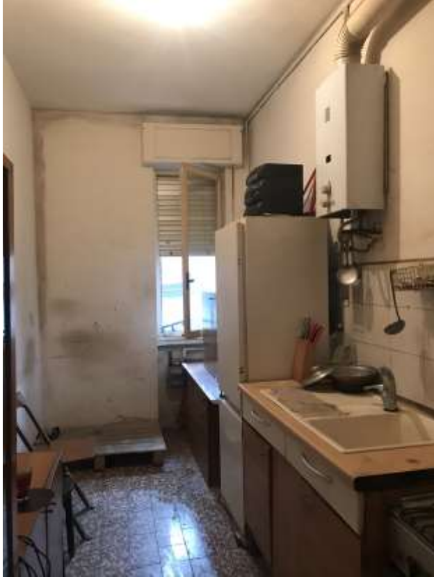
Immagine 11. La cucina. Sulla parete di fondo si nota la presenza di umidità.
