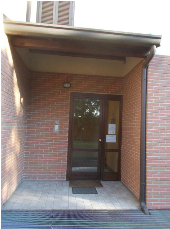
7. Ingresso all'edificio C
