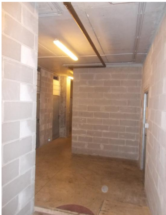
49. Corridoio comune delle cantine
