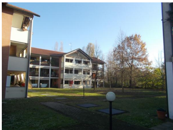
53. Giardino centrale comune
