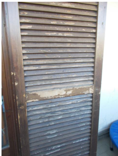
34. Serramento esterno del balcone
