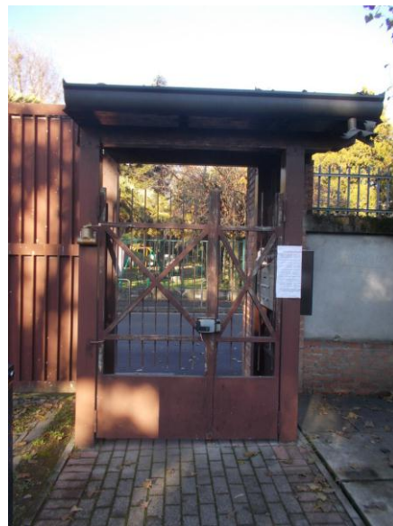
2. Cancelli di ingresso (dall'interno)
