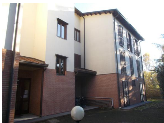
5. Edificio C: zona di ingresso
