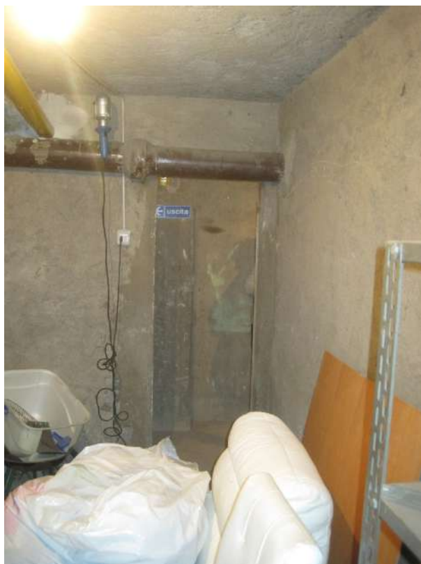
Cantina dell'unità immobiliare
