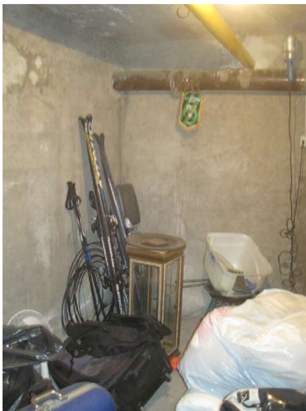
Cantina dell'unità immobiliare
