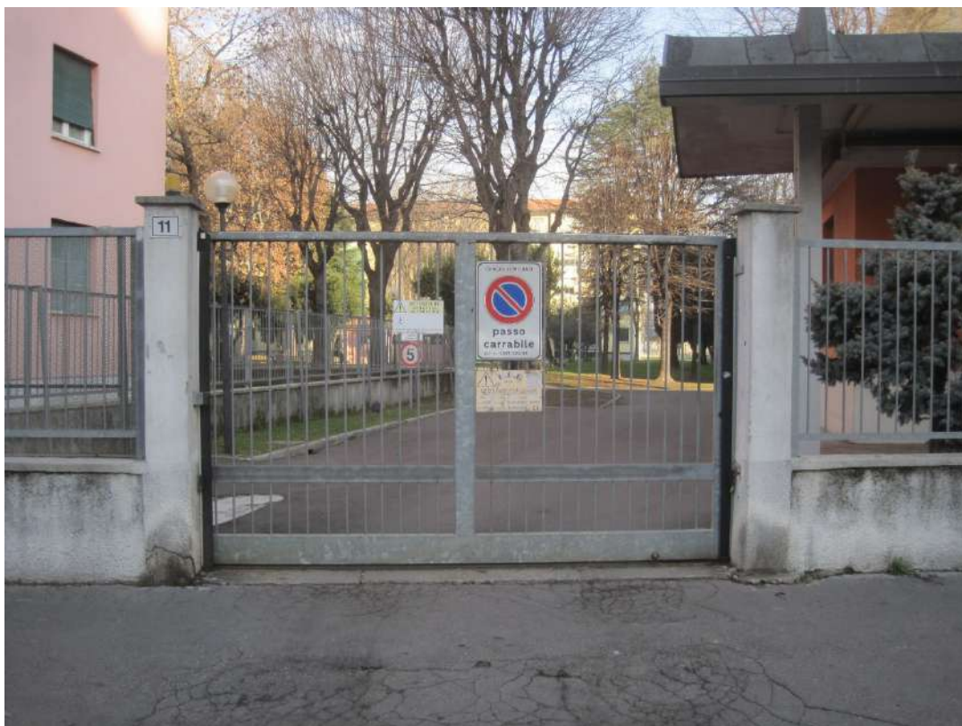
Cancello carraio degli edifici siti in Viale Ungheria n. 11
