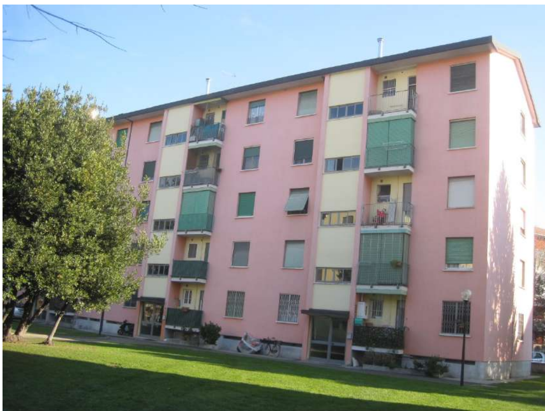
Fronti dell'Edificio "I" prospicienti il cortile condominiale
