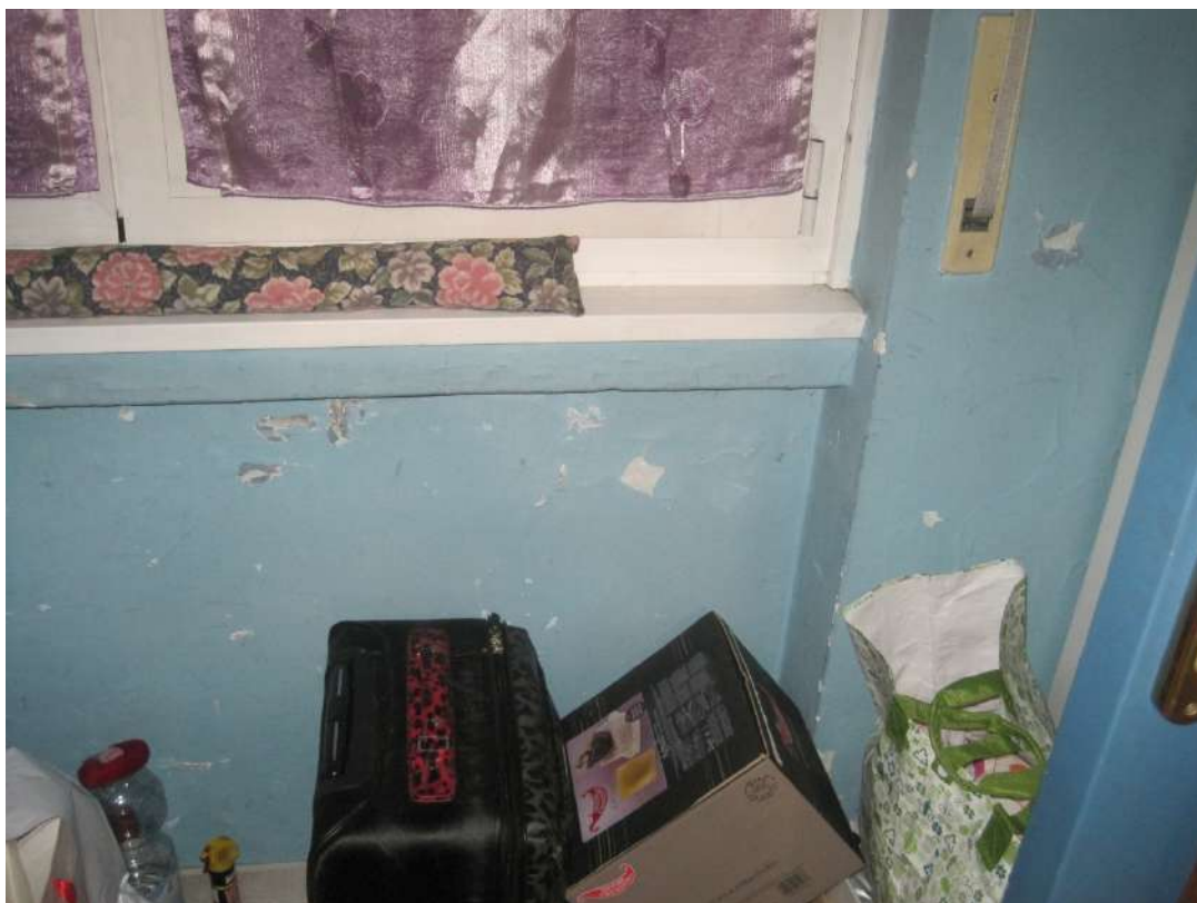
Dettagli – Intonaco della camera da letto Ovest
