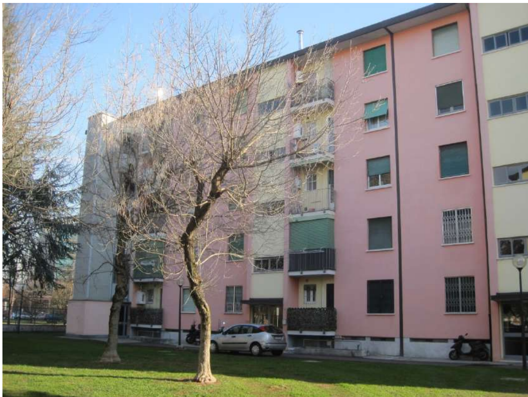
Fronti dell'Edificio "I" prospicienti il cortile condominiale
