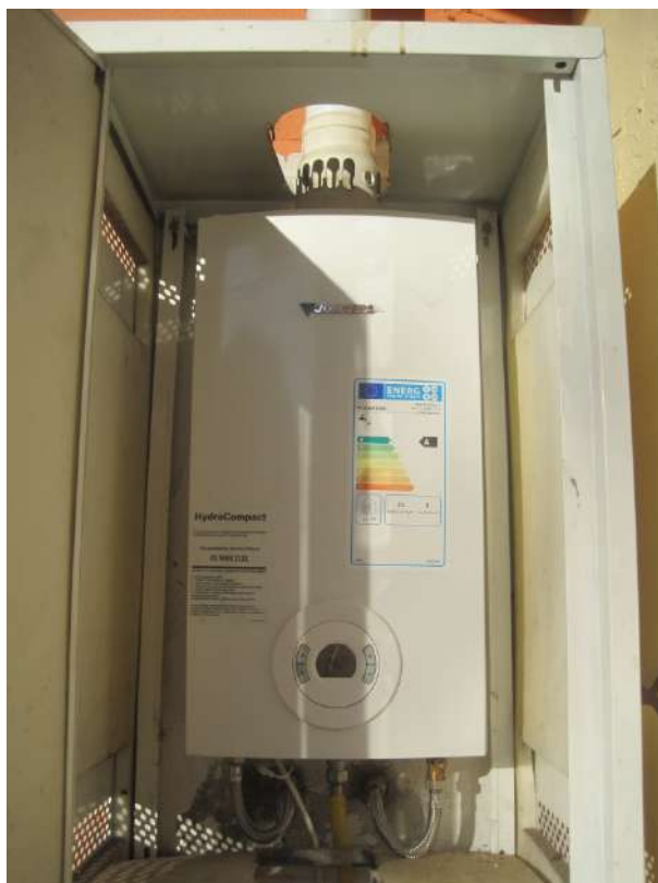
Dettagli – Caldaia murale per produzione acqua calda sanitaria
