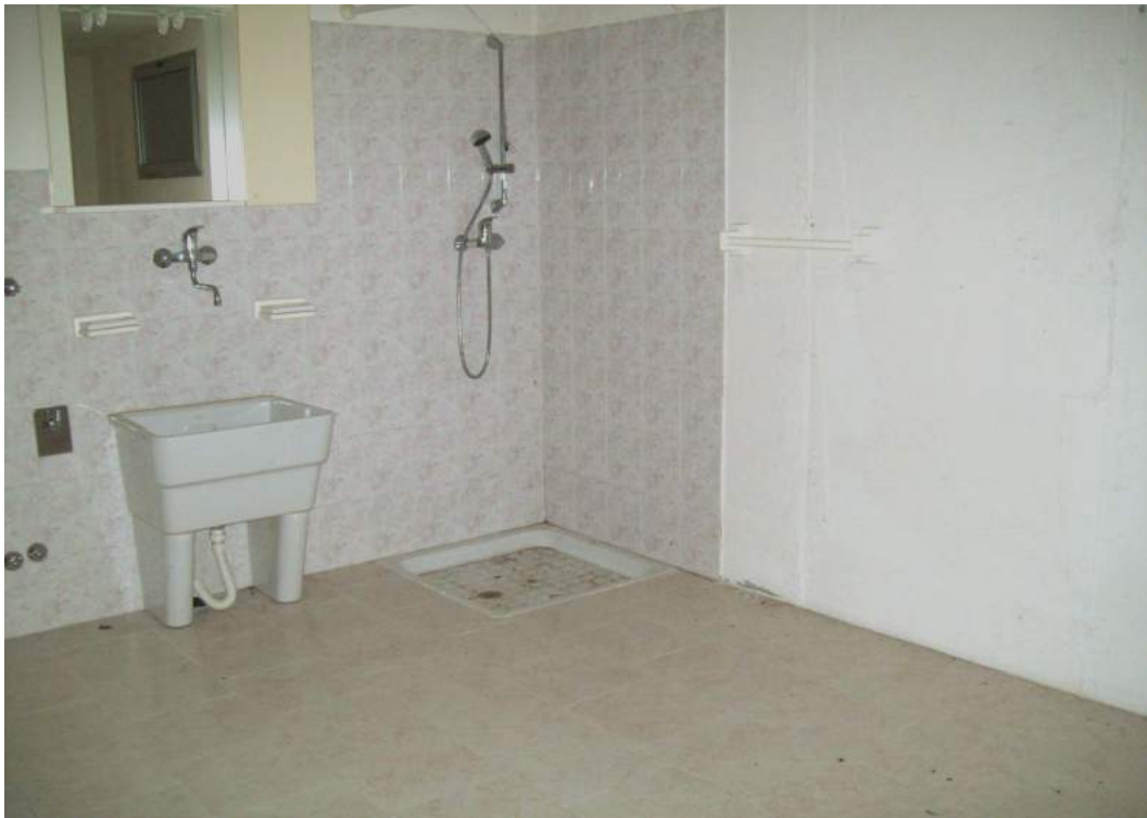
Foto 47d.8: interno lavanderia piano interrato
