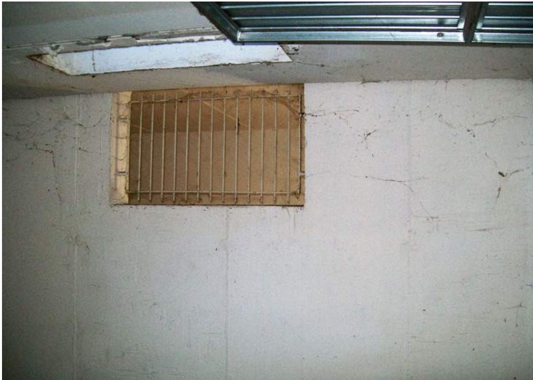
Foto 47d.10: apertura soffitto garage
