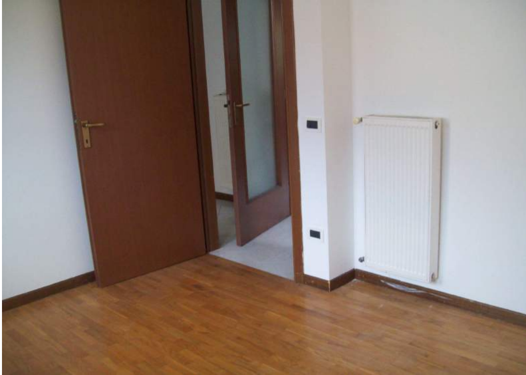
Foto 47d.7: ingresso camera lato Ovest
