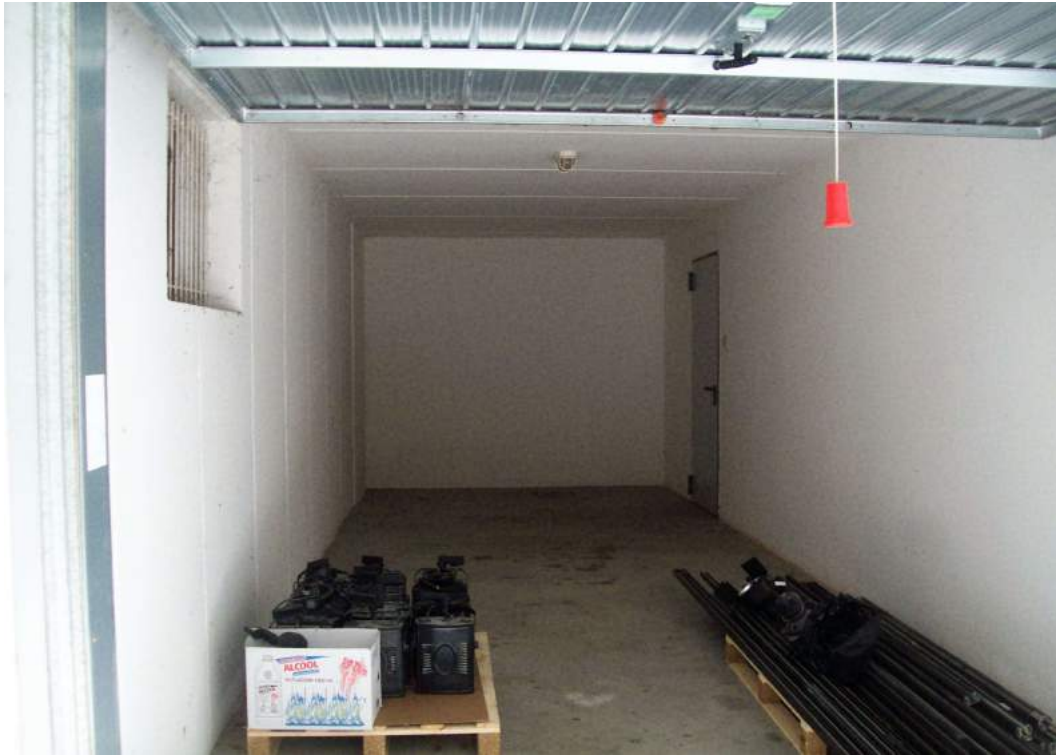
Foto 47b.9: interno garage piano interrato
