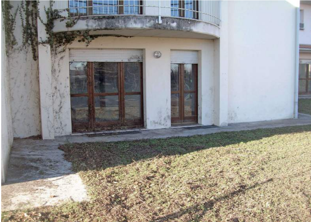
Foto 47b.7: facciata Est e corte esclusiva
