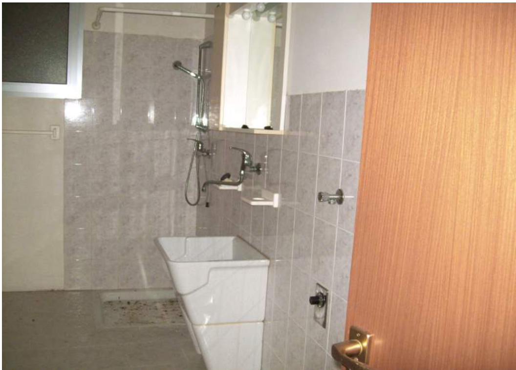
Foto 47b.8: ingresso lavanderia piano interrato
