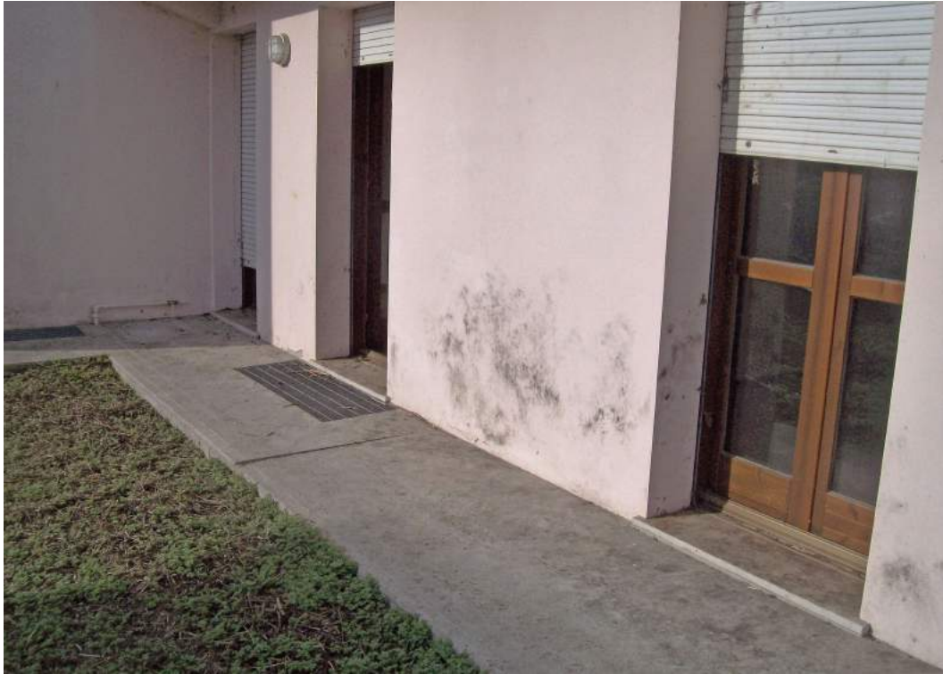
Foto 43b.7: parete esterna lato Est
