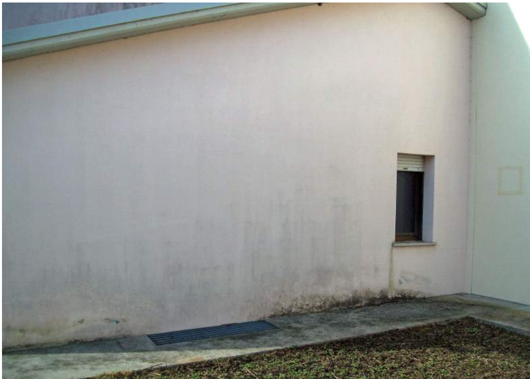
Foto 43b.6: parete esterna a Nord
