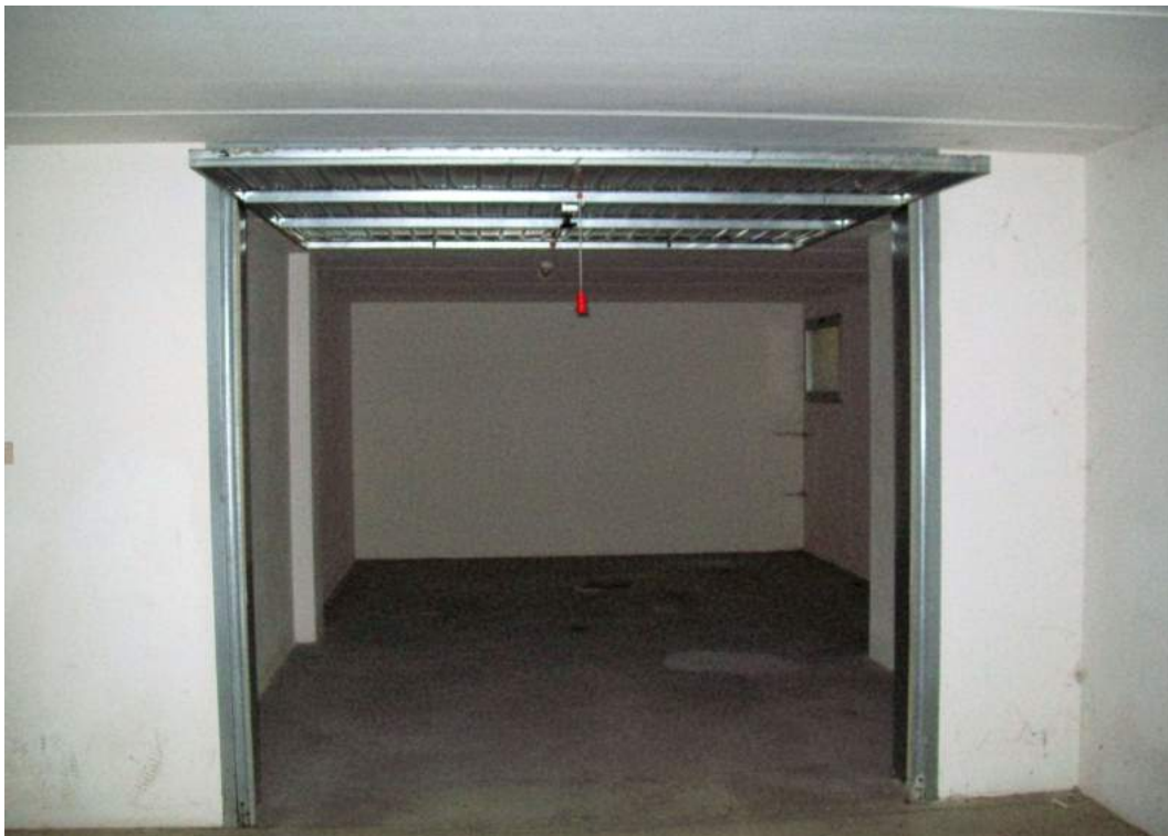
Foto 43b.10: garage piano interrato
