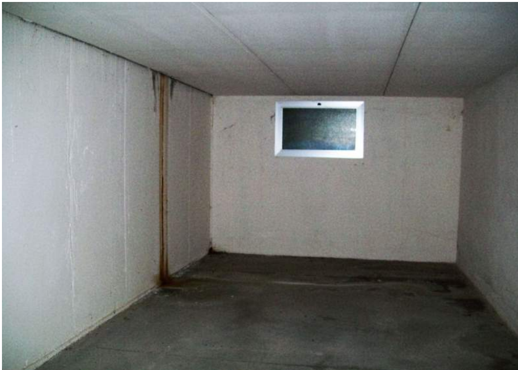
Foto 49d.8: interno garage piano interrato
