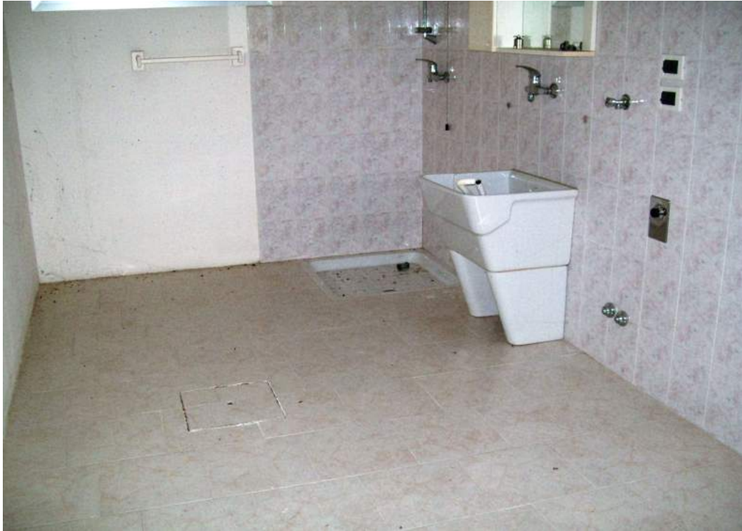
Foto 49d.7: interno lavanderia piano interrato
