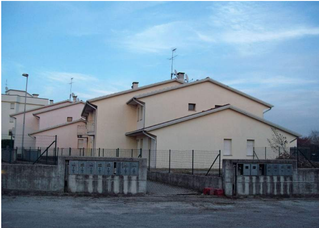
Foto 47.1: prospetto Sud con viale di accesso e contatori metano
