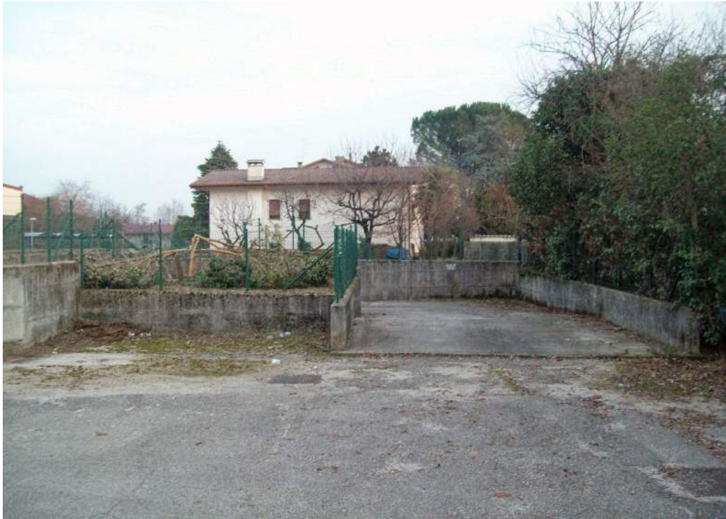
Foto 43.7: accesso carrabile piano interrato
