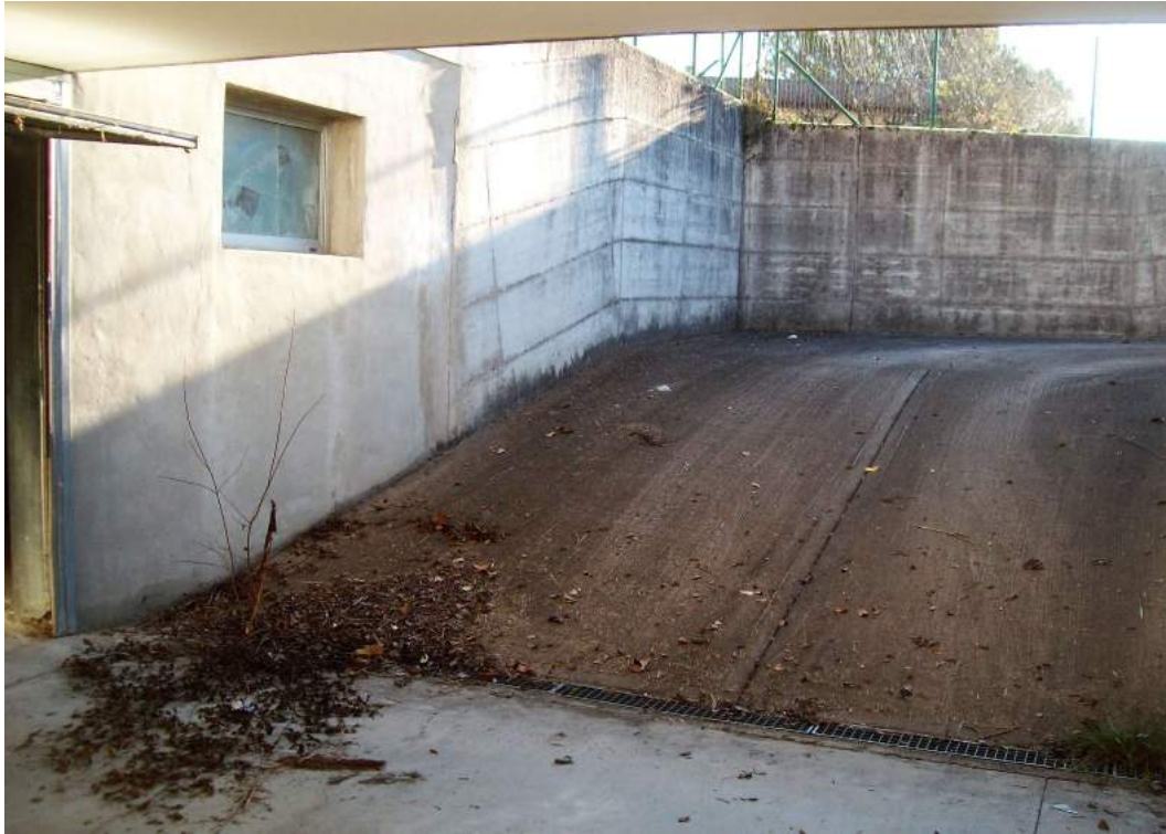
Foto 47.7: rampa di accesso carrabile al piano interrato
