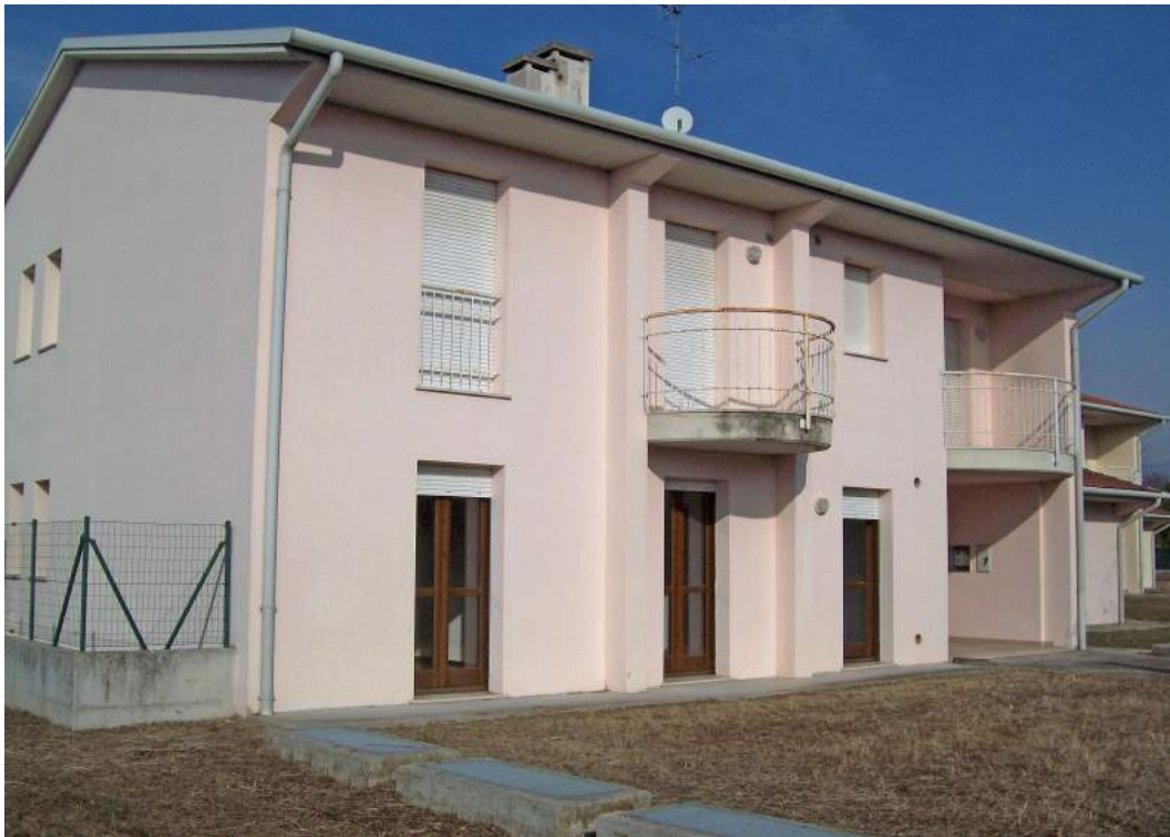
Foto 43.1: angolo Sud-Est edificio condominiale
