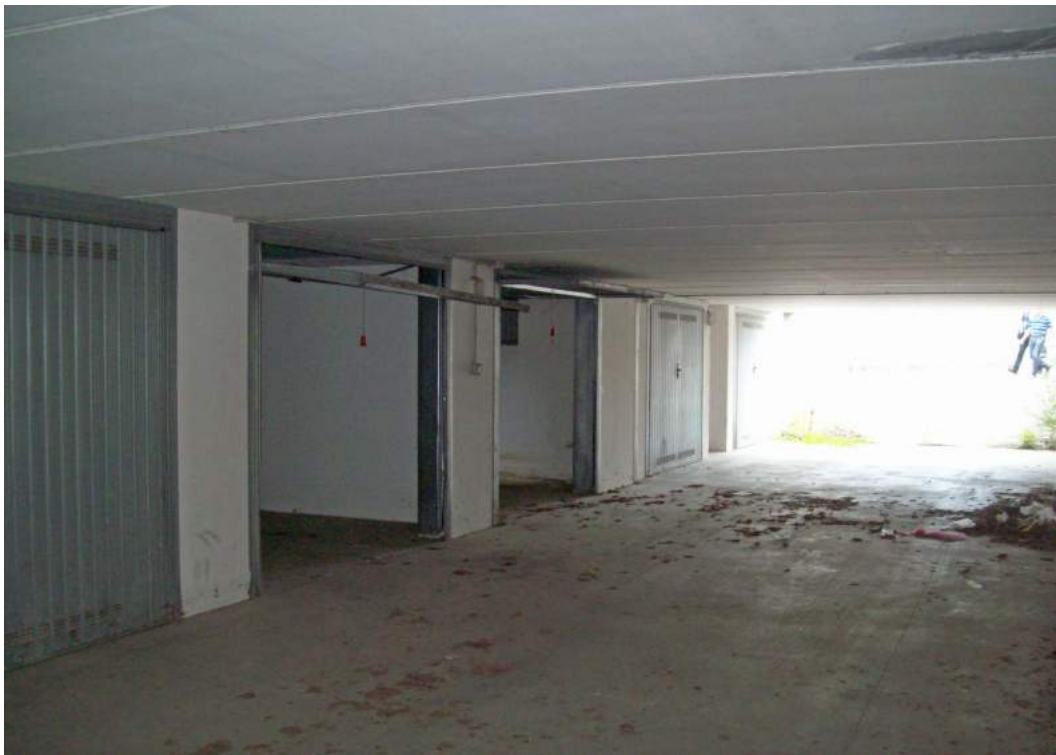
Foto 43.8: area di manovra piano interrato
