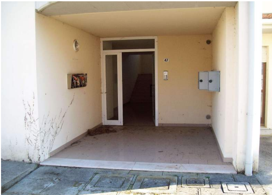
Foto 47.4: portoncino d'ingresso e contatori energia elettrica
