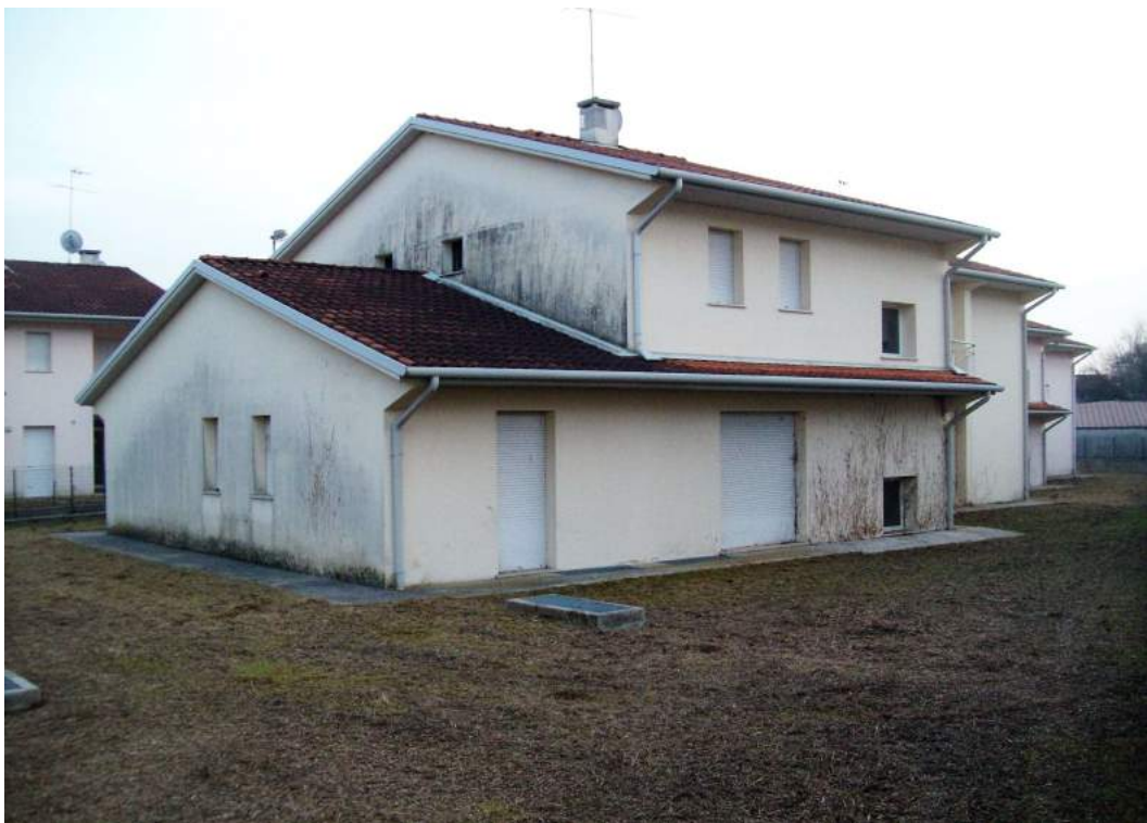
Foto 45.2: Vista prospetto Nord-Ovest
