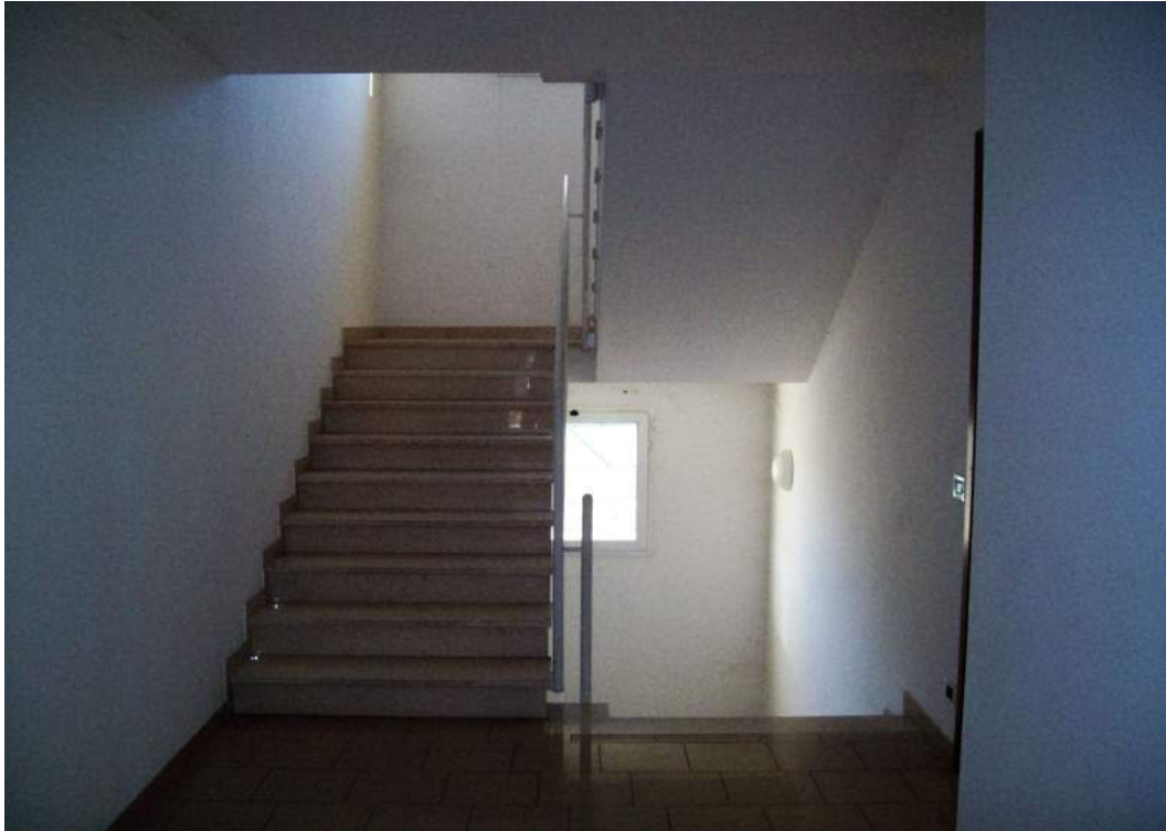
Foto 47.5: vano scale comune
