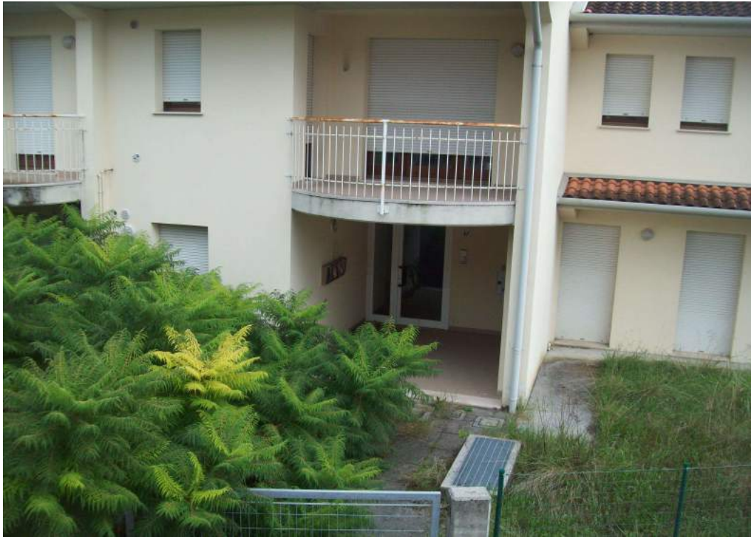
Foto 47.3: ingresso ad Ovest
