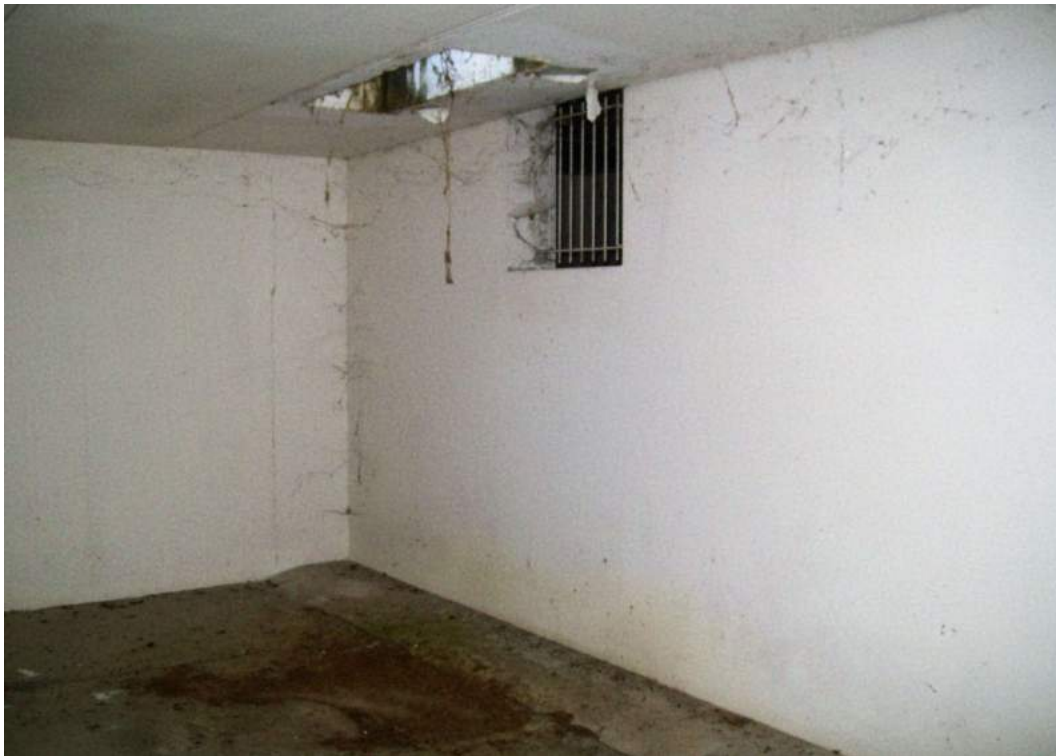
Foto 45d.8: apertura soffitto garage
