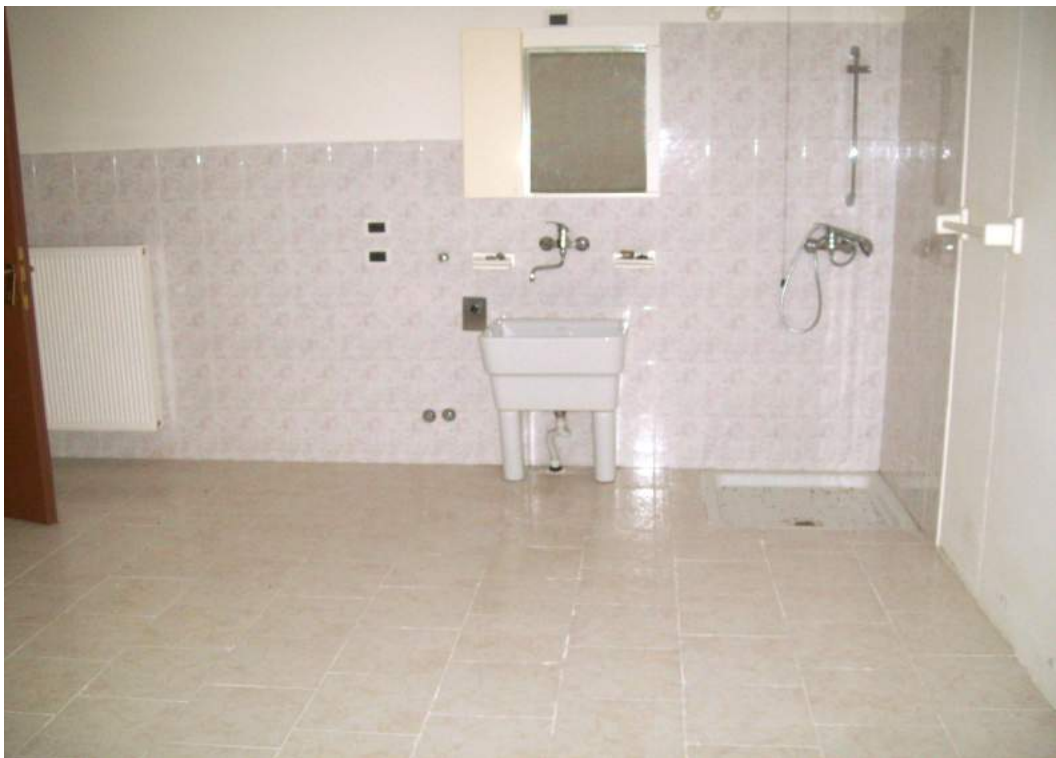
Foto 45d.6: interno lavanderia piano interrato
