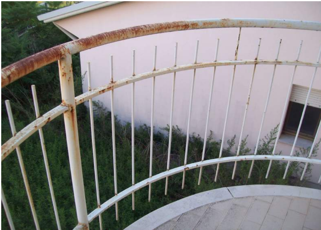
Foto 45c.6: particolare parapetto terrazzo
