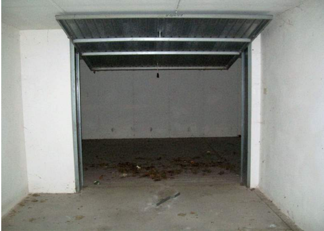
Foto 45c.9: basculante garage piano interrato
