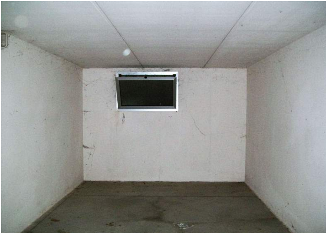
Foto 45c.8: interno garage piano interrato
