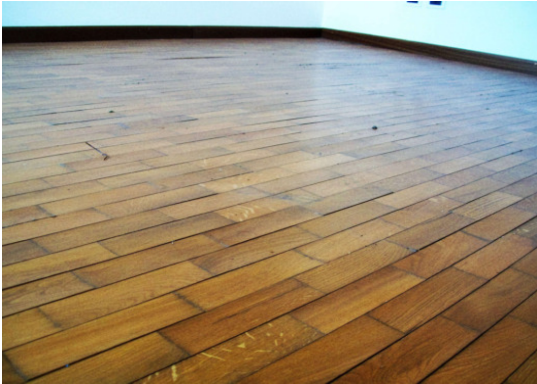
Foto 41d.9: particolare pavimento ligneo
