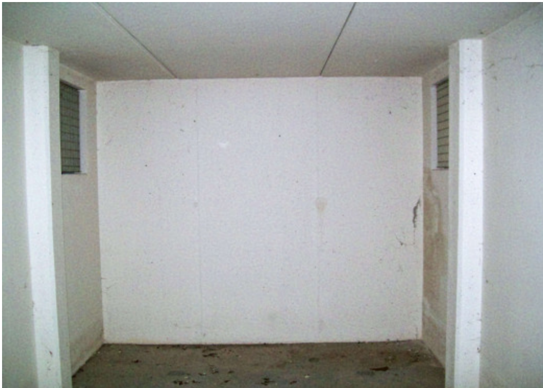
Foto 41d.12: interno garage piano interrato
