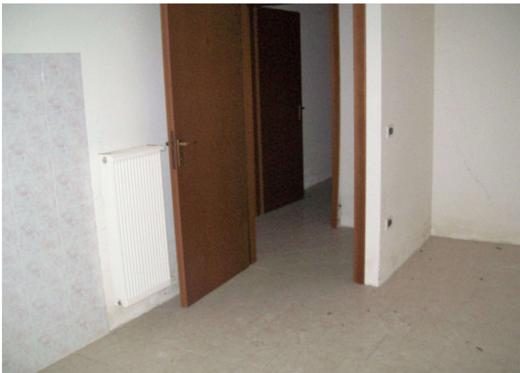
Foto 41d.10: ingresso lavanderia piano interrato
