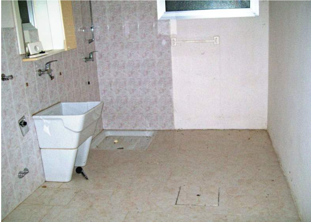
Foto 49c.5: interno lavanderia piano interrato
