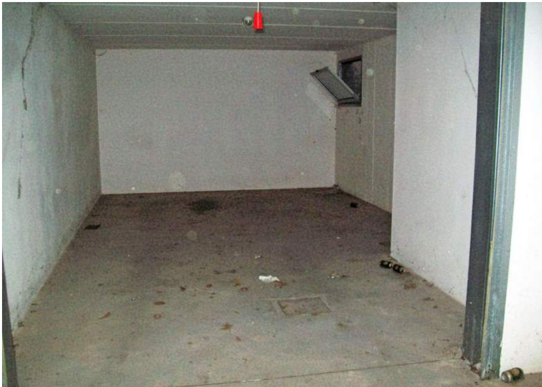
Foto 49c.6: interno garage piano interrato
