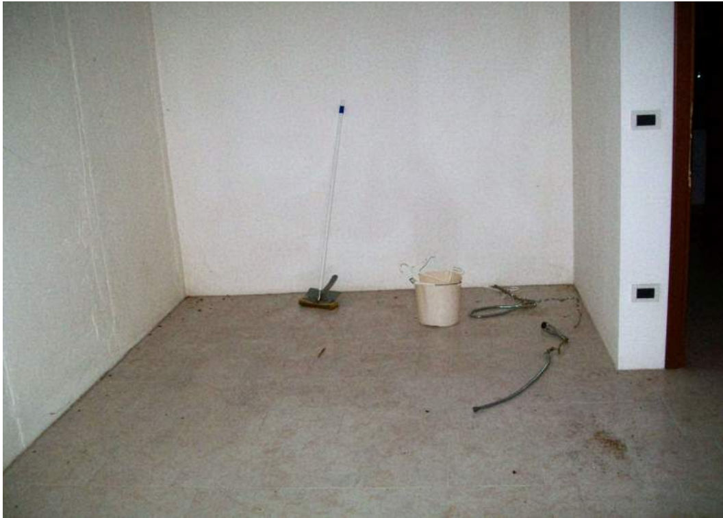
Foto 49b.7: interno lavanderia piano interrato
