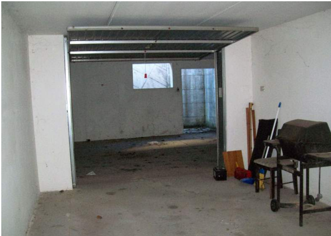
Foto 49a.8: interno garage piano interrato
