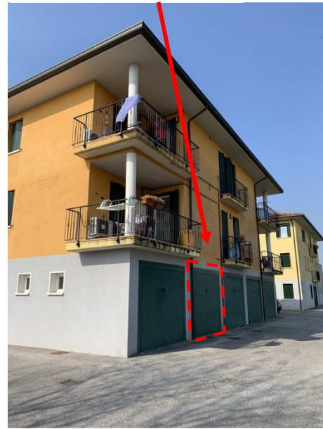
vista esterna fabbricato condominiale lato sud-est
