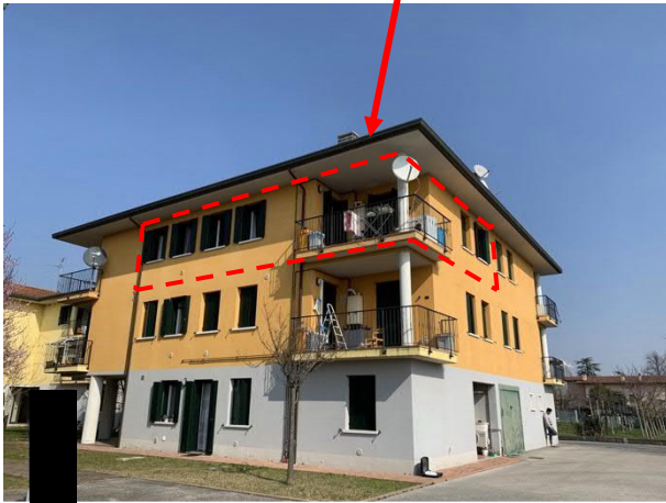
vista esterna fabbricato condominiale lato sud-ovest
