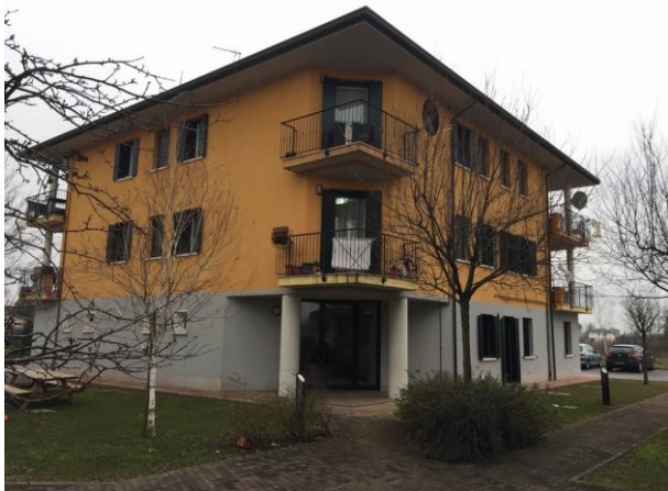
vista esterna fabbricato condominiale lato nord-ovest
