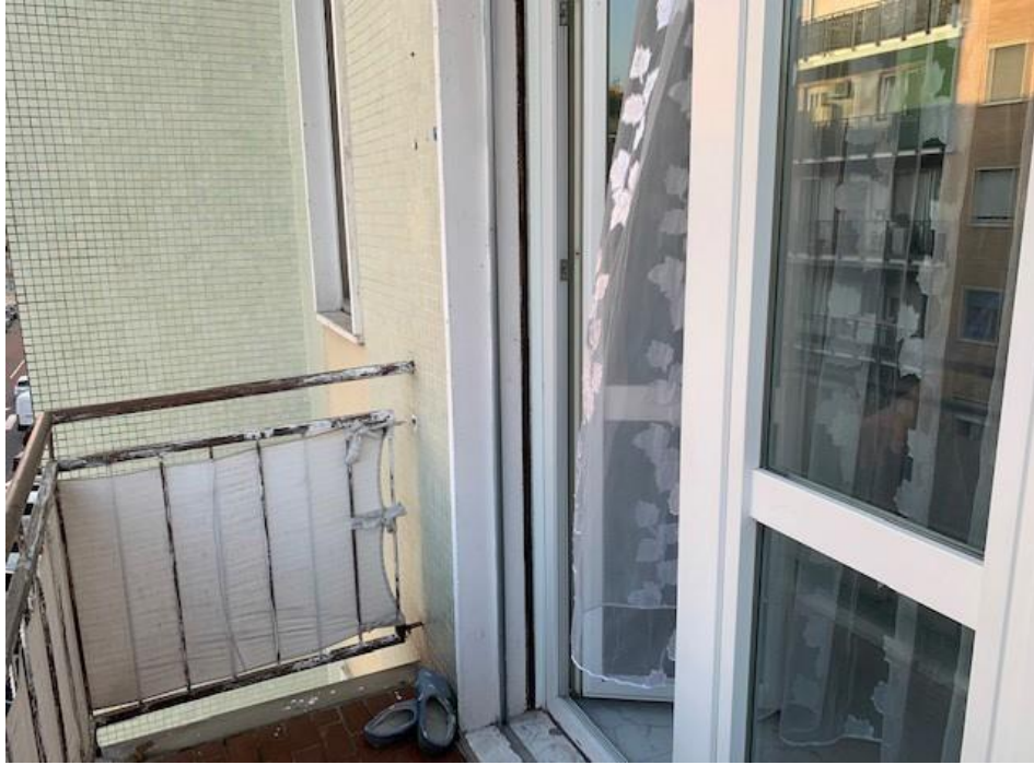
Vista esterna - balcone
