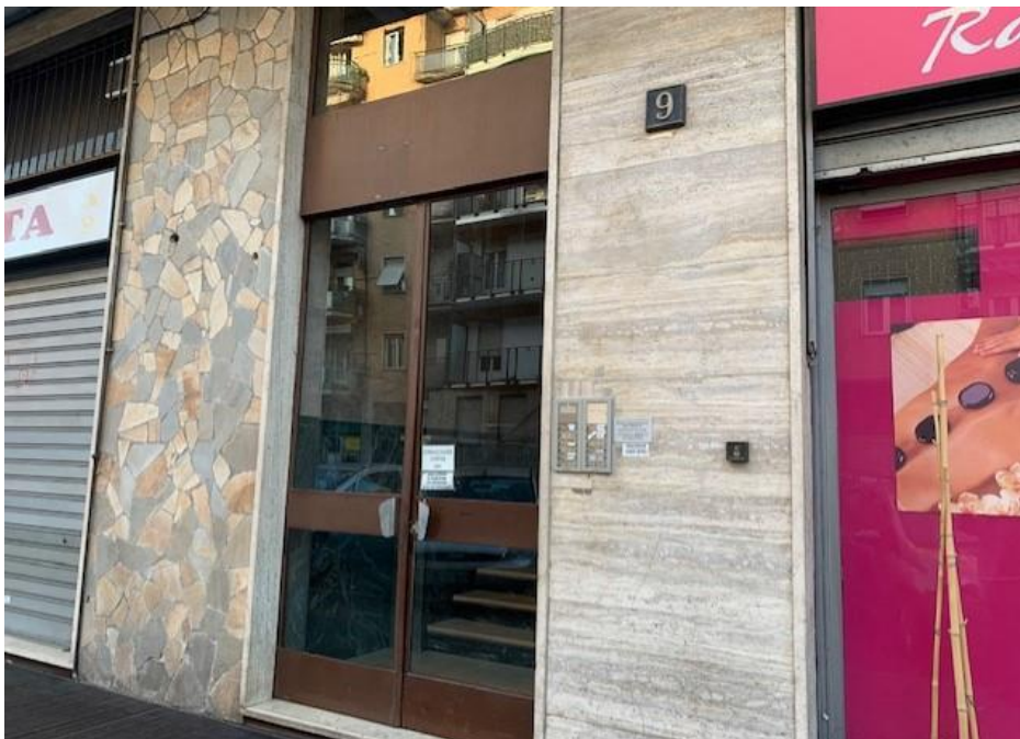
Vista esterna - ingresso condominio
