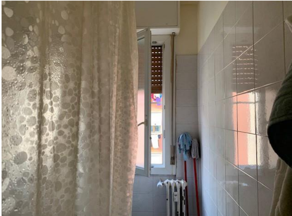
Vista interna - bagno
