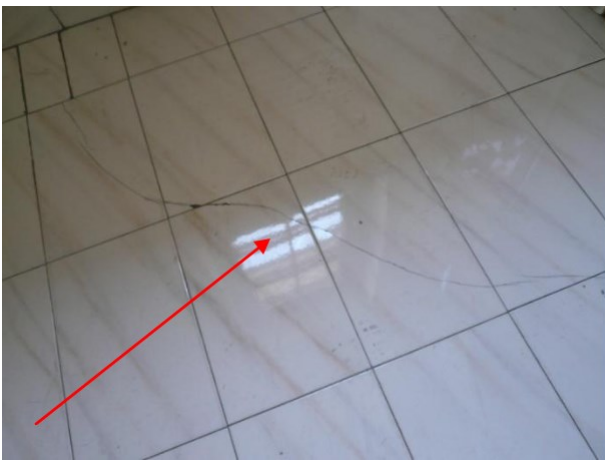
Bagno Piano Primo
