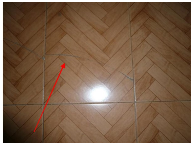
Sbarco scala Piano Sottotetto
