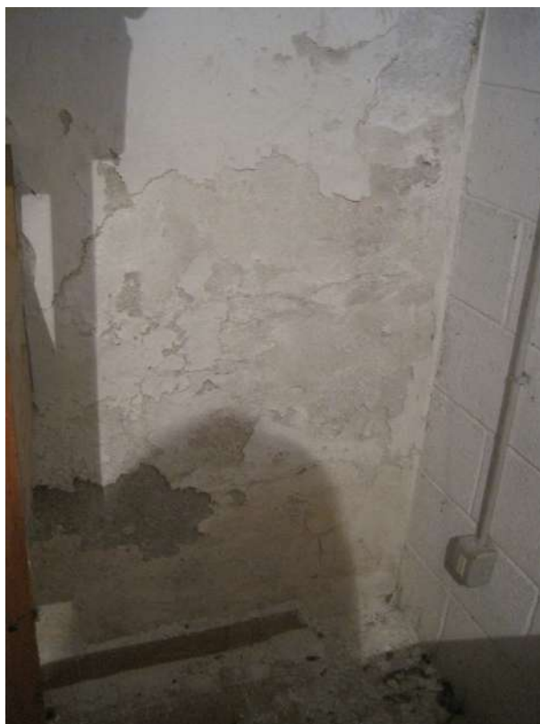
Dettaglio - Piede delle murature della cantina
