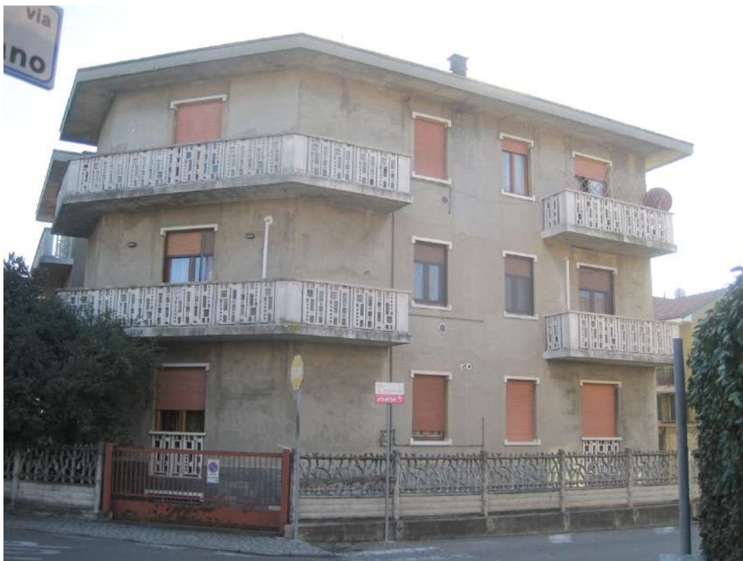
Fronte Ovest dell'edificio
