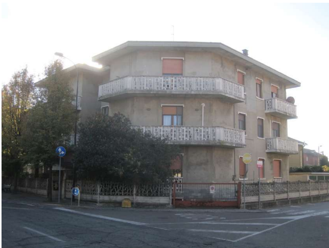
Fronti Nord e Ovest dell'edificio
