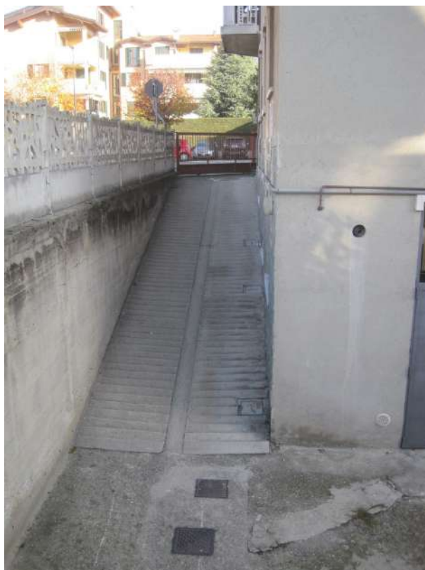
Rampa di accesso all'autorimessa condominiale
