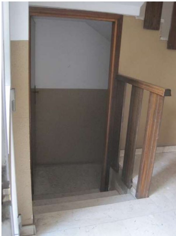
Ingresso delle cantine condominiali
