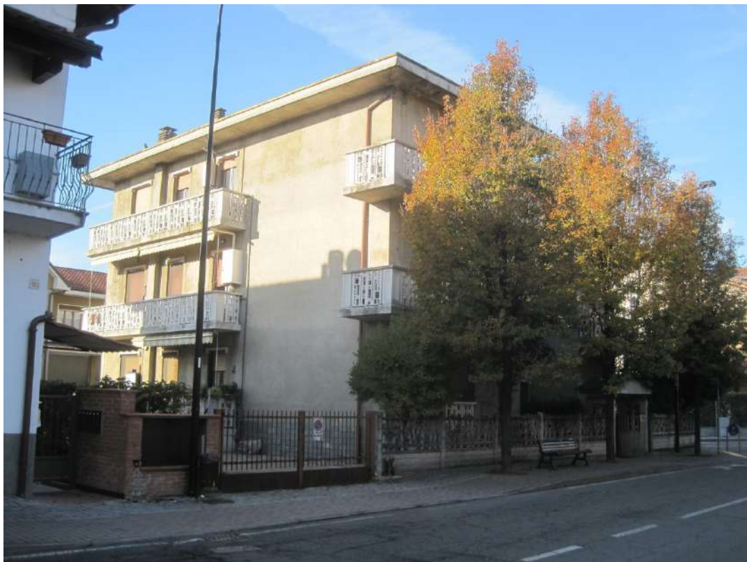
Fronti Est e Nord dell'edificio
