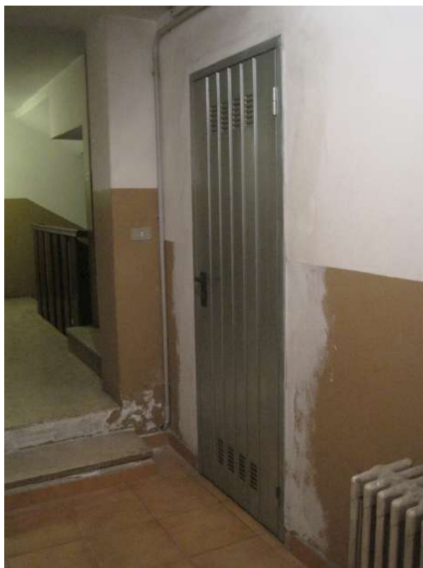
Cantina dell'unità immobiliare pignorata
