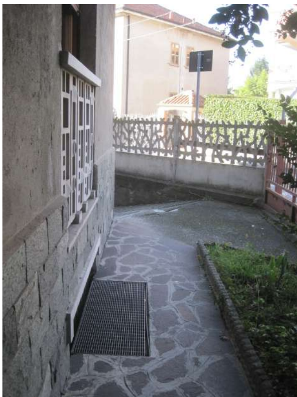
Cortile condominiale a Nord
