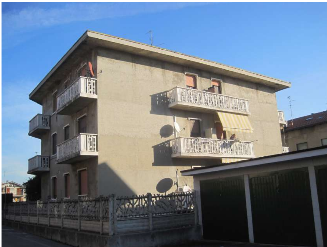
Fronte Sud dell'edificio
