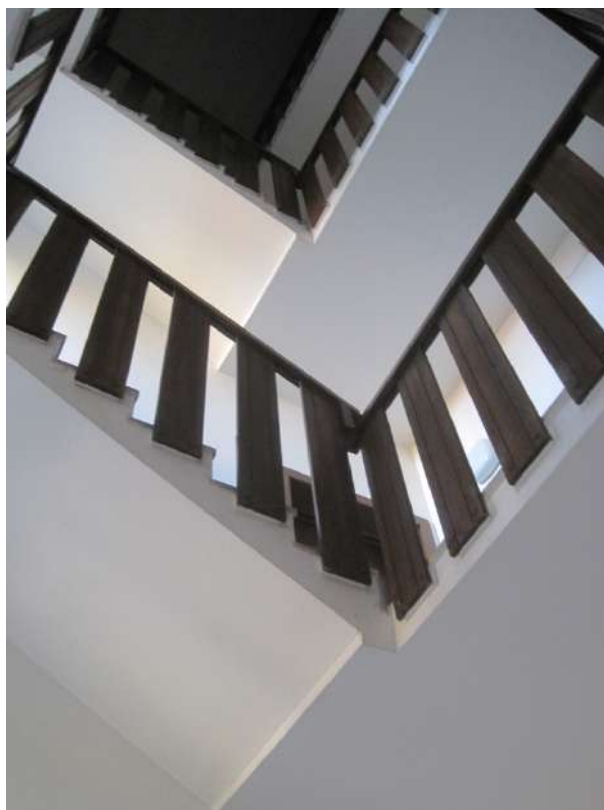
Vano scala condominiale
