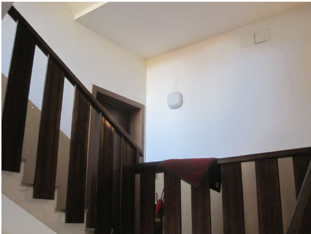
Vano scala condominiale e pianerottolo di ingresso dell'unità immobiliare pignorata
