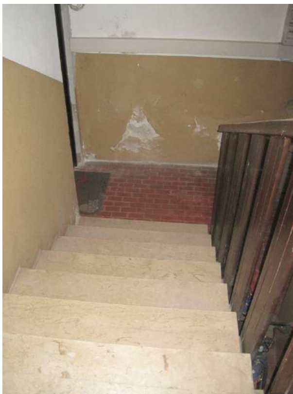
Scala di accesso alle cantine condominiali
