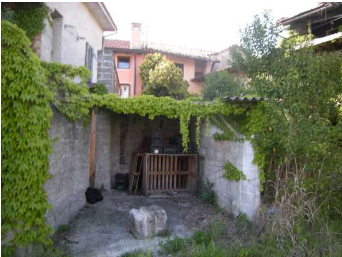
LOTTO 7 - Castions di Zoppola, via San Marco s.n. – La porzione d'immobile al NCEU del Comune di Zoppola, foglio 19, particelle n 307 e 1073.
