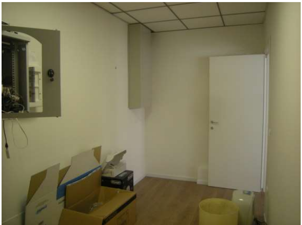
LOTTO 1- Castions di Zoppola, via Nicolò Fortuni, foglio 19, particella 1146, sub 36 – Il vano 2.
