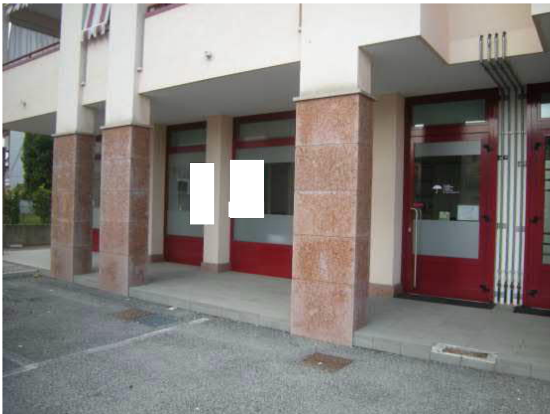
LOTTO 1- Castions di Zoppola ,via Nicolò Fortuni, foglio 19, particella 1146, sub 36– L'immobile 1, al piano terra dell'edificio A.
