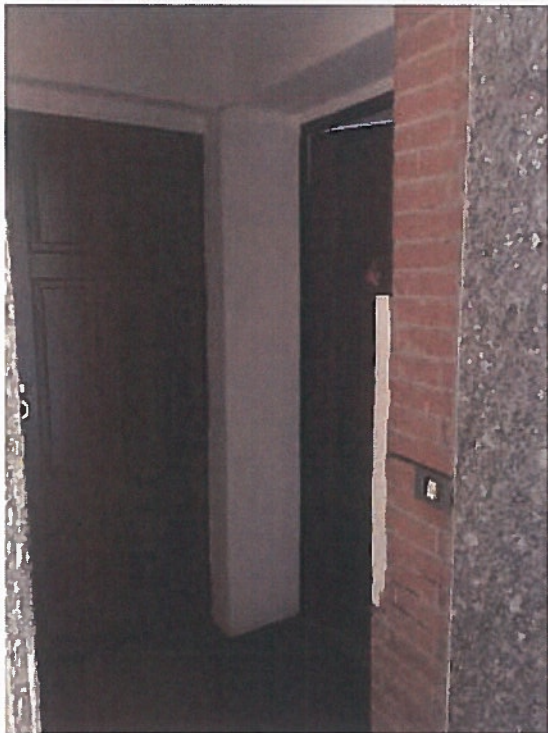
Vista della porta di accesso all'appartamento pignorato
