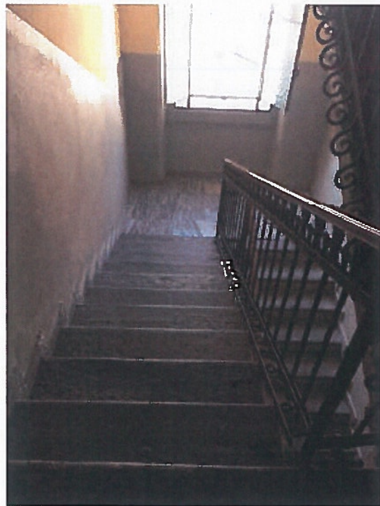
Vista della rampa di scale di accesso alle unità abitative
