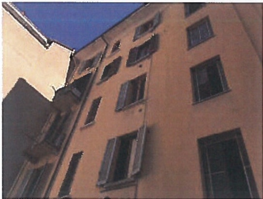
Vista del prospetto interno
