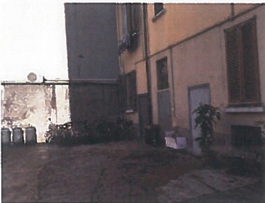
Vista del cortile interno
