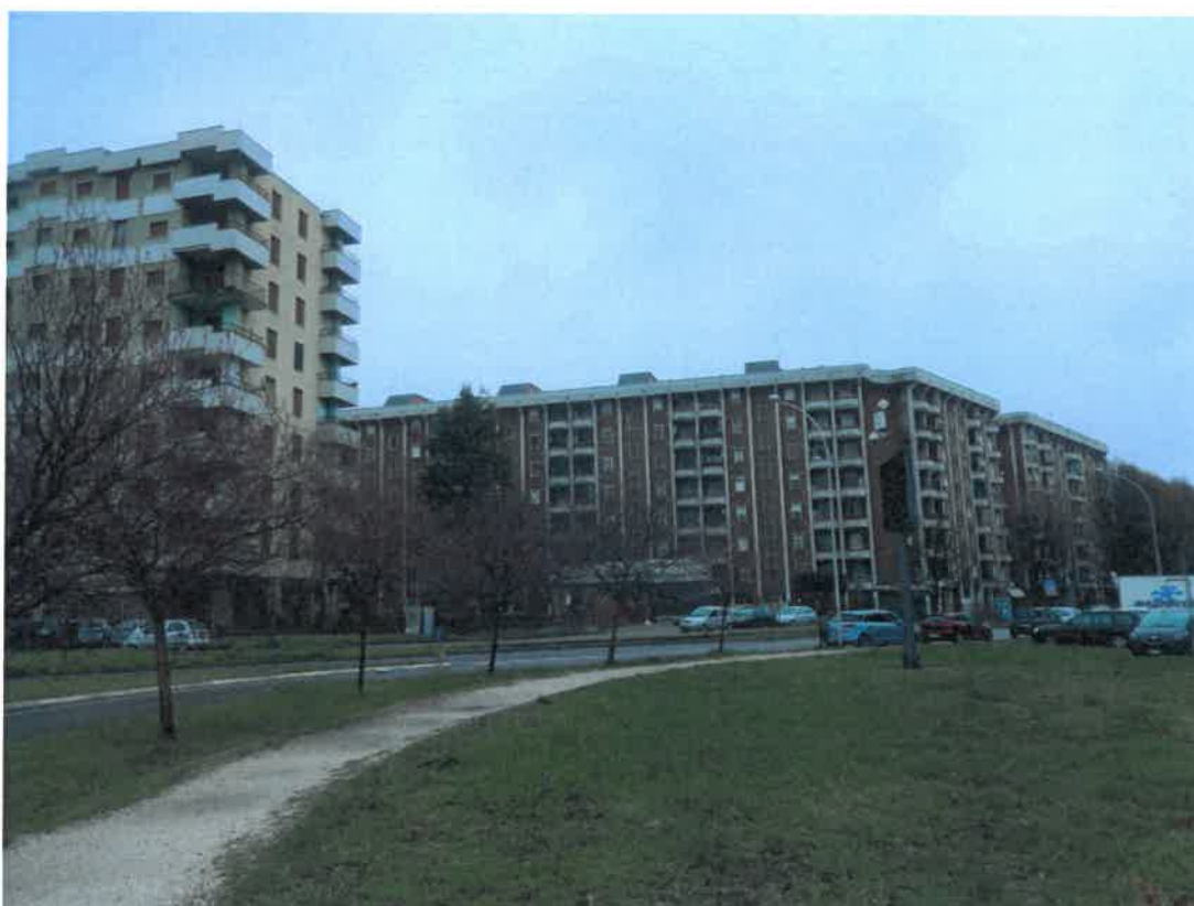
Foto 2 – Vista del complesso dall'esterno.
