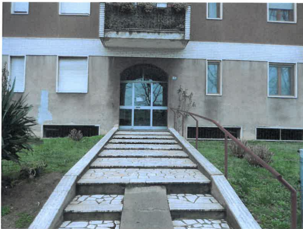
Foto 3 – Il portone di accesso all'Edificio "E" (scala 26).
