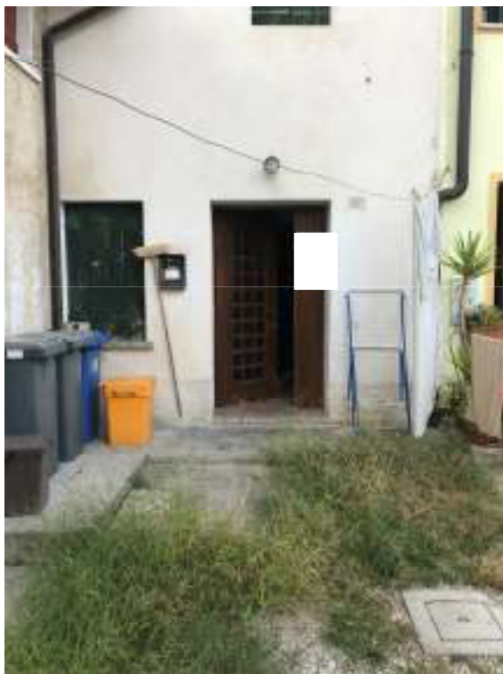
Fig.3: vista portoncino di ingresso
