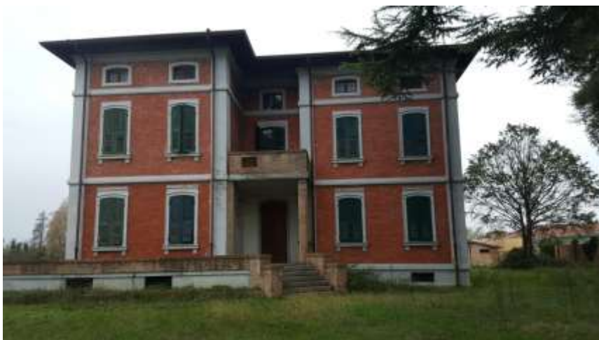
Fronte sud-est su via Roma
