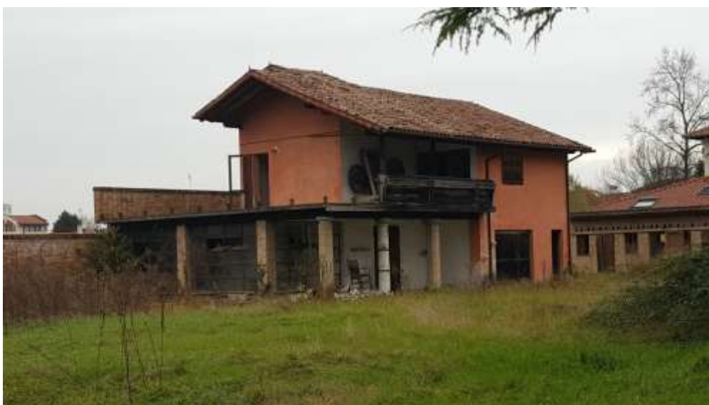
L'accessorio retro vista lati sud-est e sud-ovest
