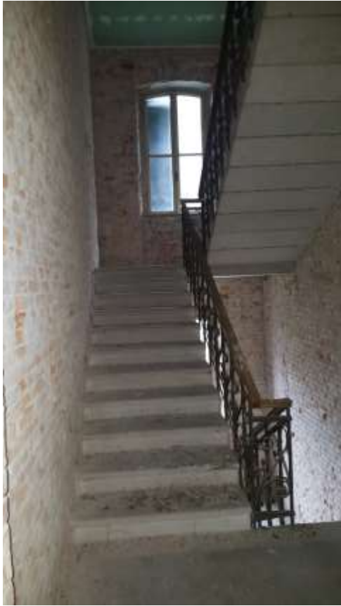
Scala da piano primo a piano secondo-soffitta
