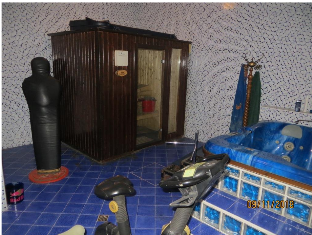
Foto 28 – Vista del locale s.p.p. con installazione di vasca idromassaggio e sauna
