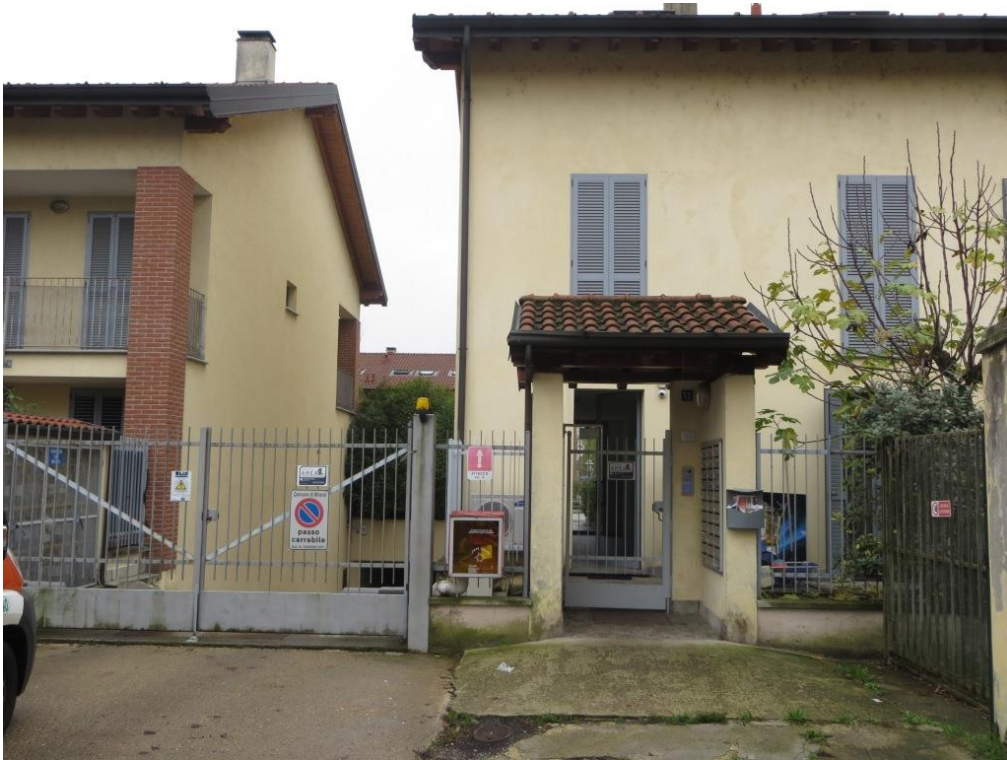
Foto 2 – Ingresso, da via Dè Finetti, alle parti comuni del complesso condominiale
