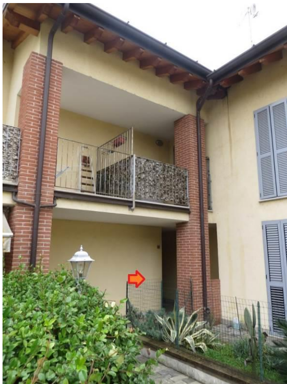
Foto 4 – Vialetto di accesso al corpo scala in cui è sita l'unità immobiliare sub 109
