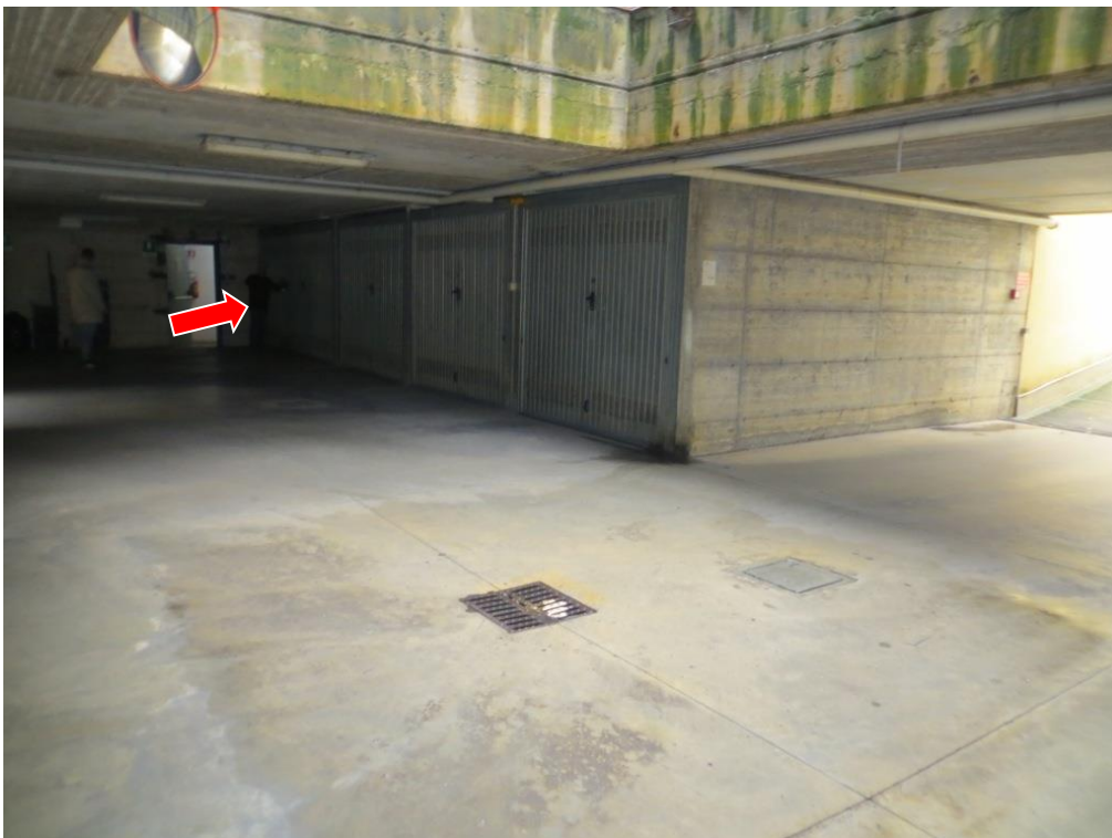
Foto 34 – Corsello comune di manovra verso la rampa con accesso da via Del Mare
