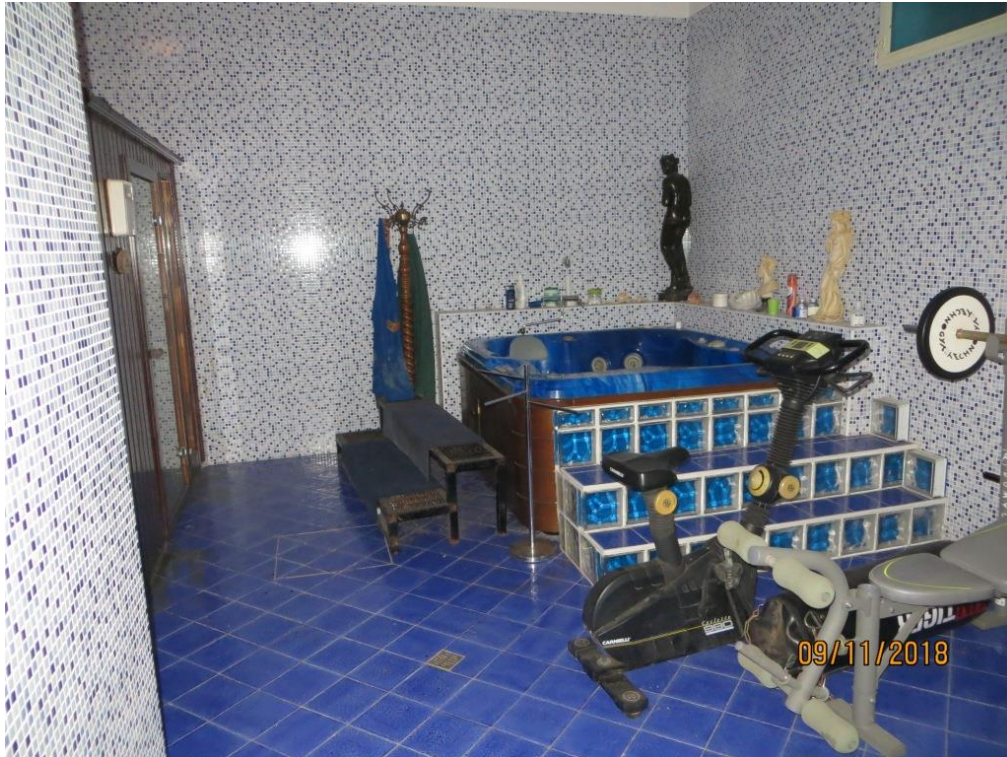
Foto 27 – Vista del locale s.p.p. con installazione di vasca idromassaggio e sauna
