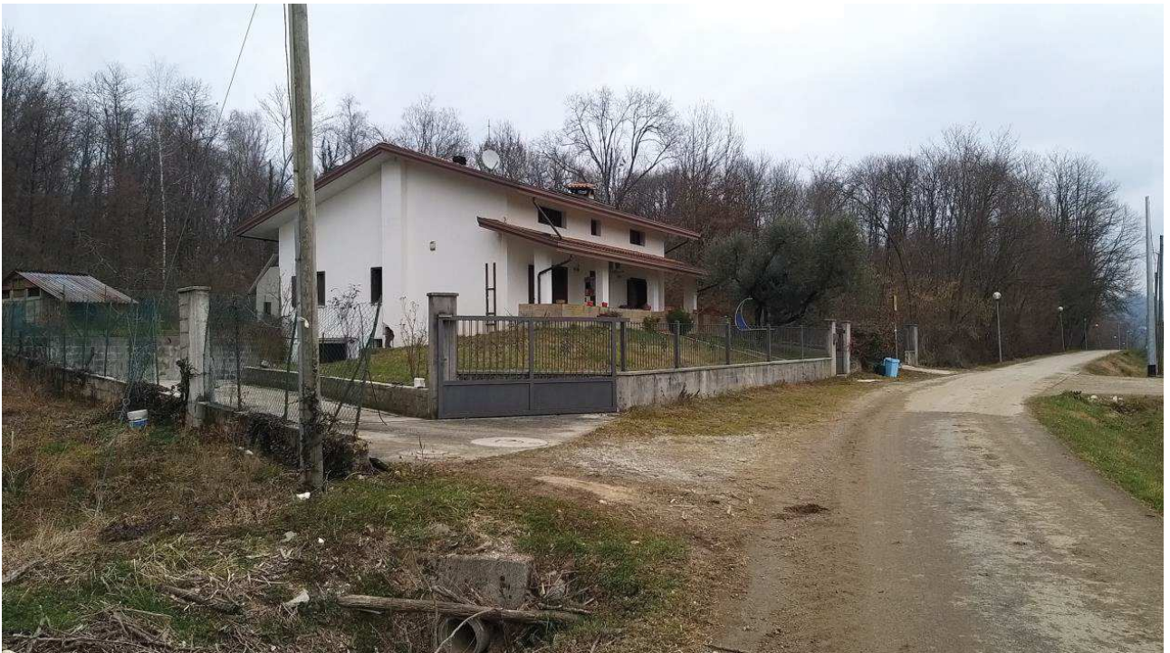
Lotto 1 - Comune di Travesio (PN) - Foglio 20, m.le 87 - Veduta generale dell'abitazione pignorata.
