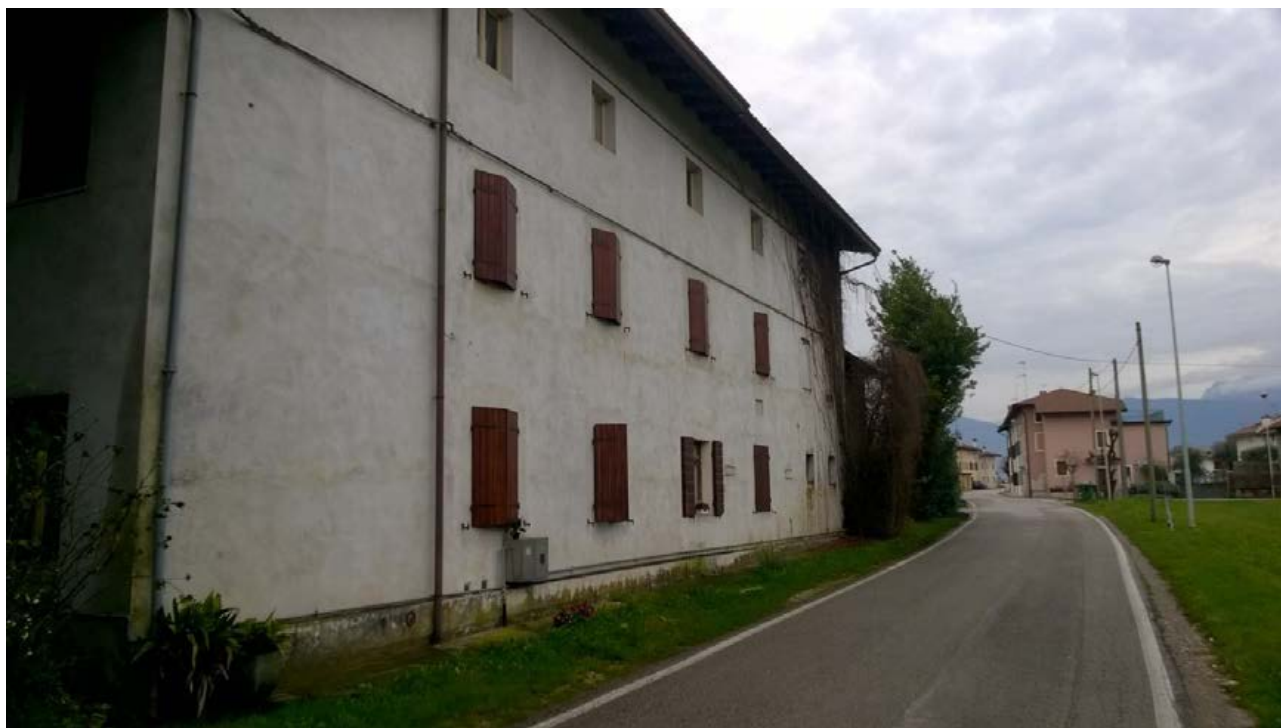
Foto n. 3 - Comune di Vivaro (PN) - frazione Tesis - Particella n. 730 del foglio 7 – veduta esterna dell'abitazione da via Lenardon (posizione nord-est).
