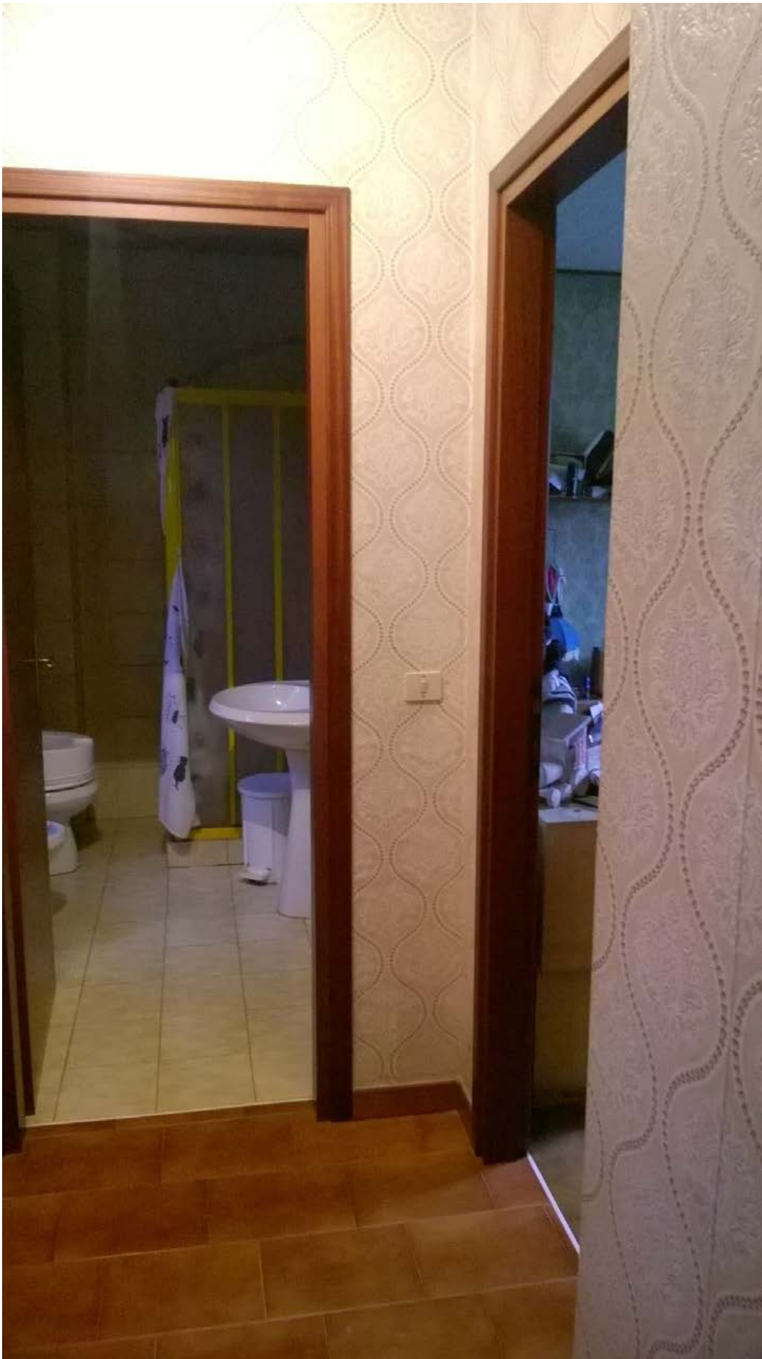
Foto n. 20 - Comune di Vivaro (PN) - frazione Tesis - Particella n. 730 del foglio 7 - Posizione terminale del disimpegno al 1° piano: a destra l'accesso all'ultima camera e a sinistra l'accesso al bagno.
