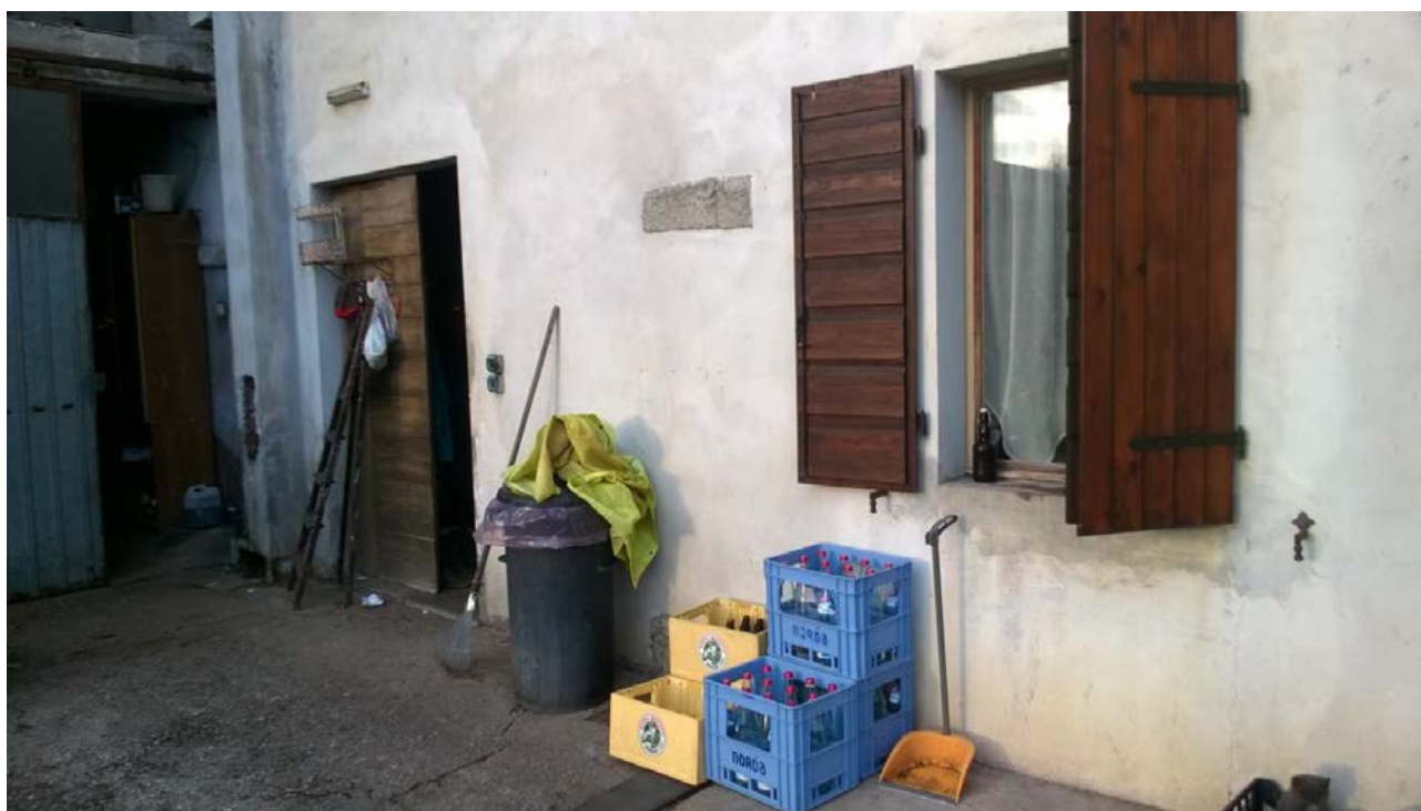
Foto n. 27 - Comune di Vivaro (PN) - frazione Tesis - Particella n. 730 del foglio 7 - Particolare del portoncino d'accesso al vano C.T. e ripostiglio.
