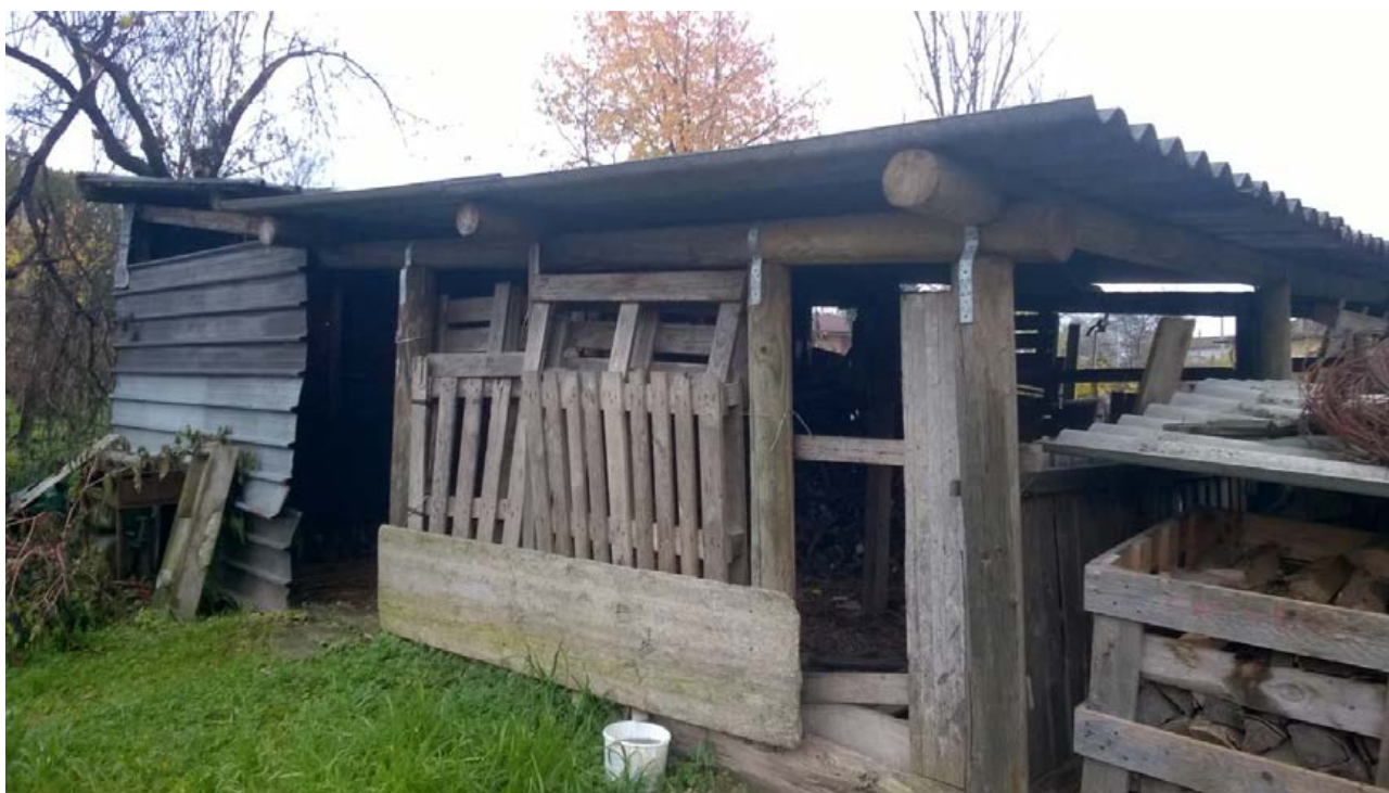
Foto n. 32 - Comune di Vivaro (PN) - frazione Tesis - Particella n. 729 del foglio 7 - Veduta esterna del fabbricato uso legnaia.
