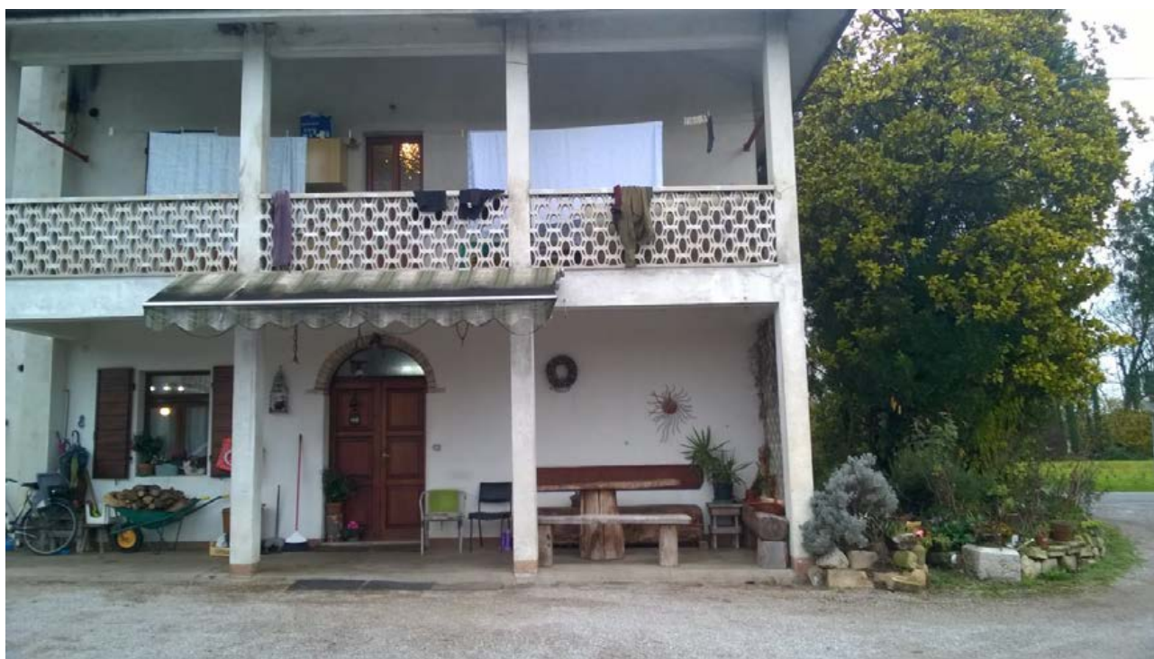
Foto n. 4 - Comune di Vivaro (PN) - frazione Tesis - Particella n. 730 del foglio 7 – veduta dell'abitazione dal lato di accesso agli interni.
