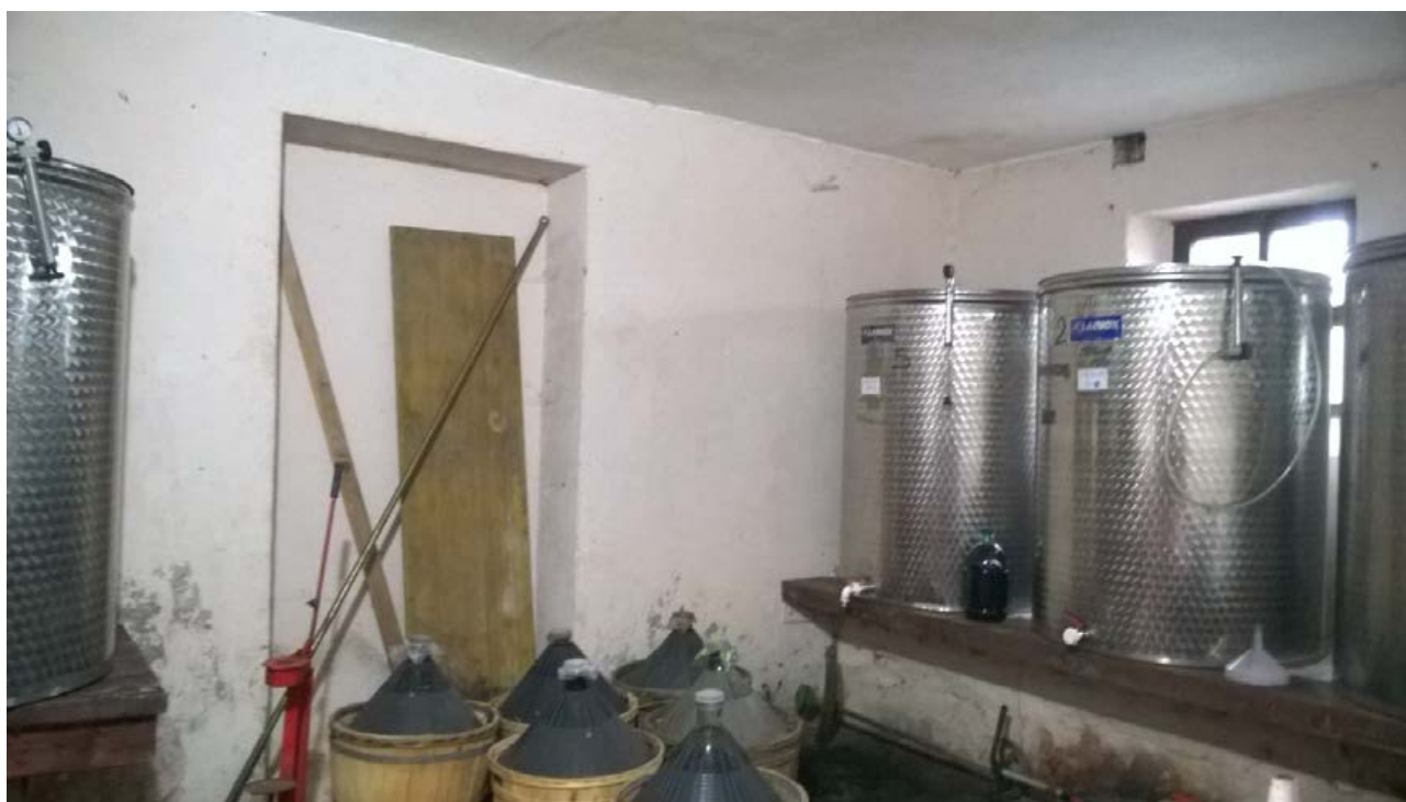
Foto n. 30 - Comune di Vivaro (PN) - frazione Tesis - Particella n. 730 del foglio 7 - Particolare del vano cantina posto a piano terra.
