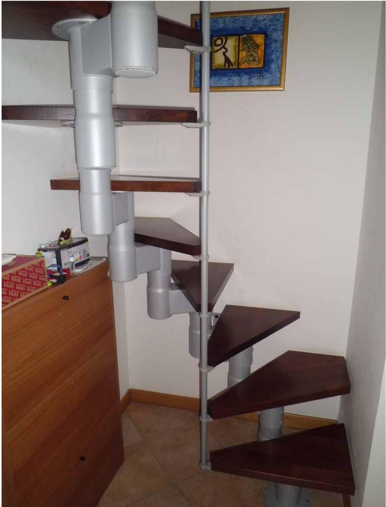
Foto n° 5 - 06/08/2018 - Comune di Spilimbergo, foglio 29, part. 1099, sub.1 – Piano terra - Ingresso. Scala a chiocciola che permette di accedere alla soffitta.
