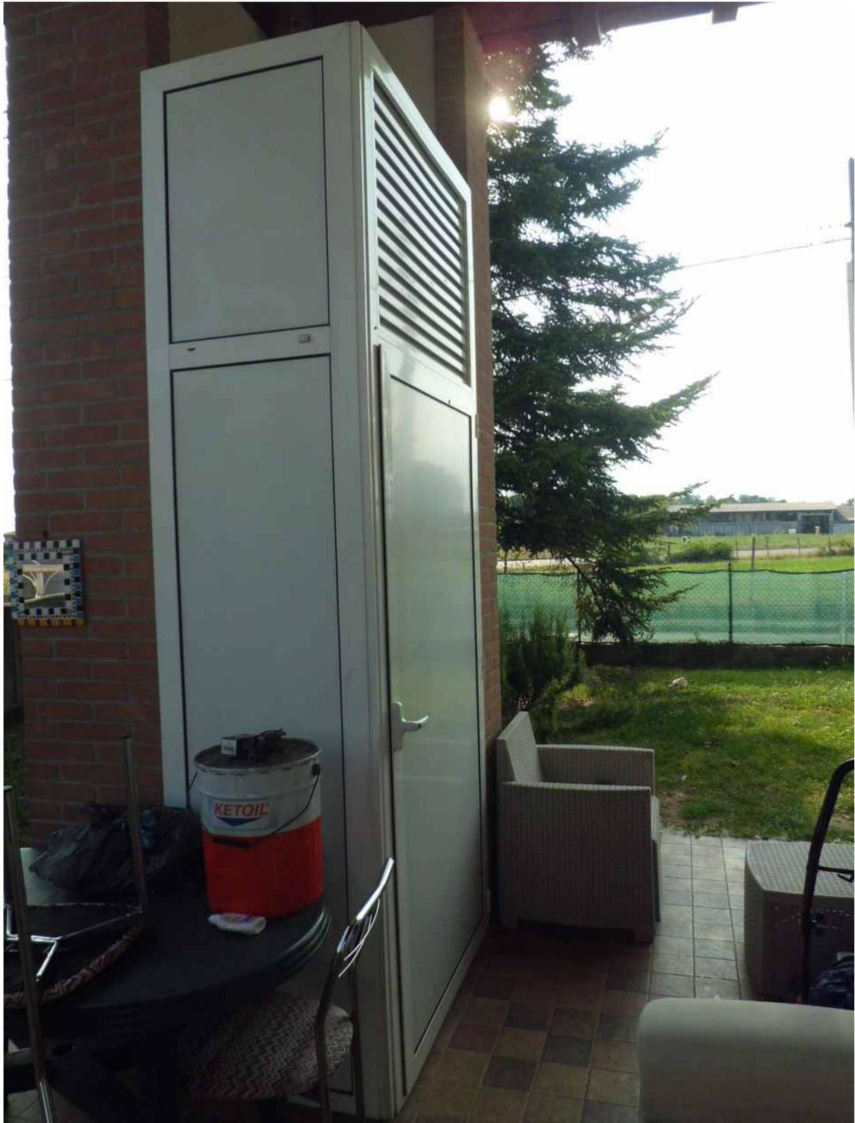
Foto n° 21 - 06/08/2018 - Comune di Spilimbergo, foglio 29, part. 1099 sub.1 - Piano terra - Struttura metallica utilizzata come CT, posta nella terrazza esterna.
