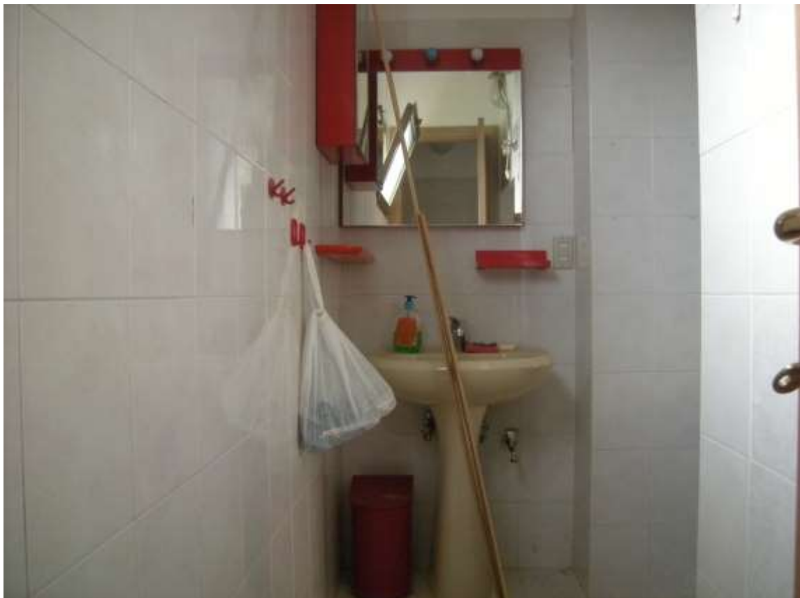
Budoia, via Cardazzo n°. 13 – Il locale spogliatoio – w.c..
