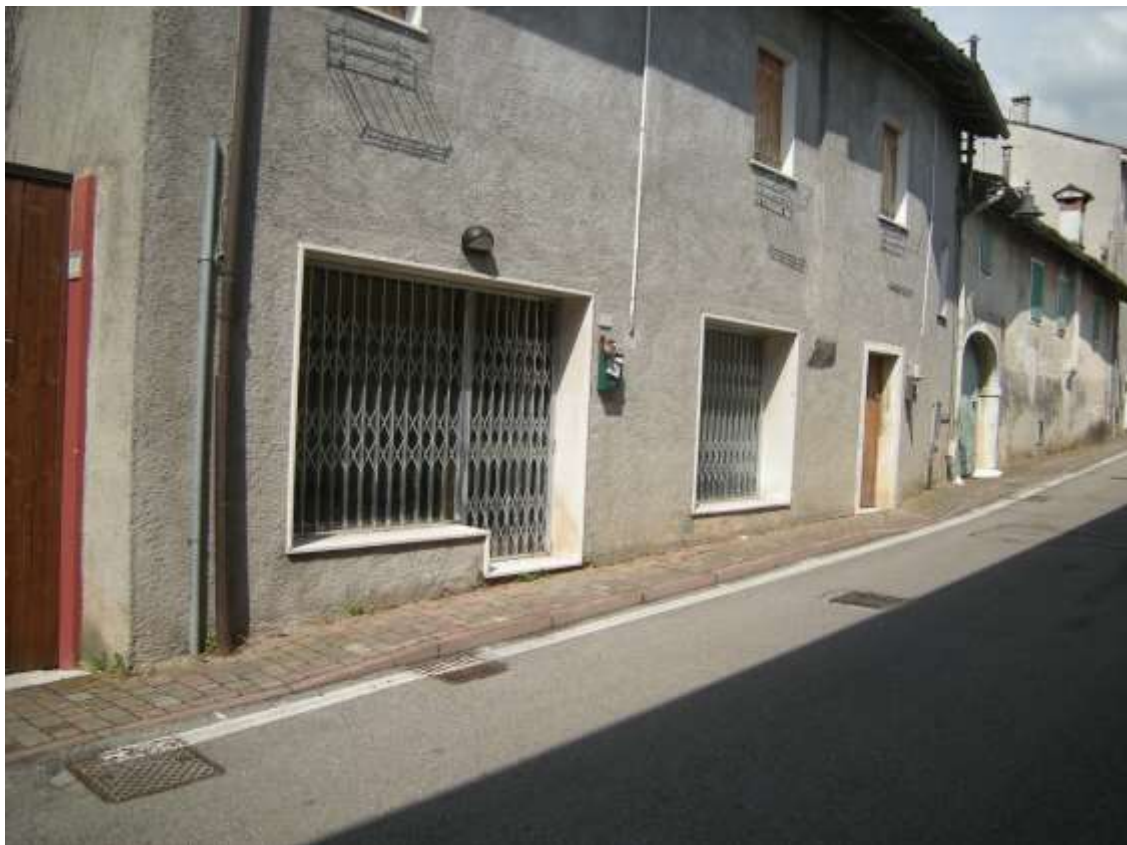
Budoia, via Cardazzo n°. 13 - Il prospetto a nord-est del negozio.
