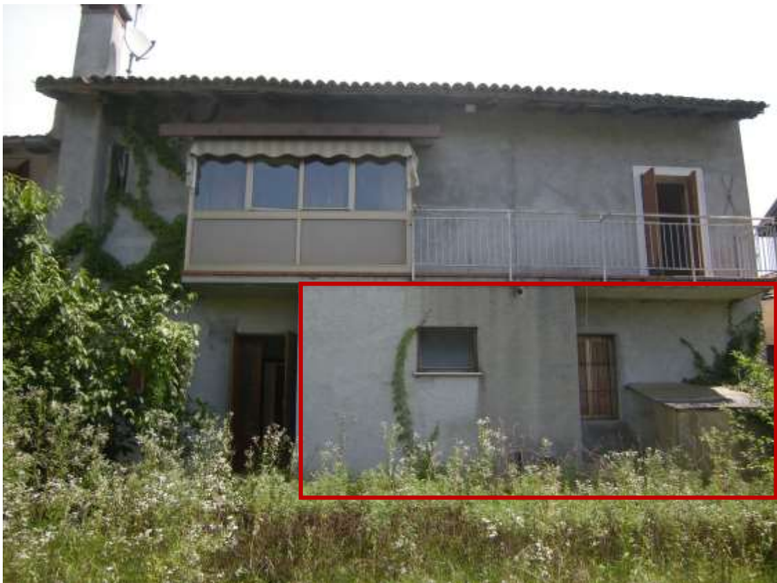
Budoia, via Cardazzo n°. 13 - Il prospetto a sud-ovest della negozio.
