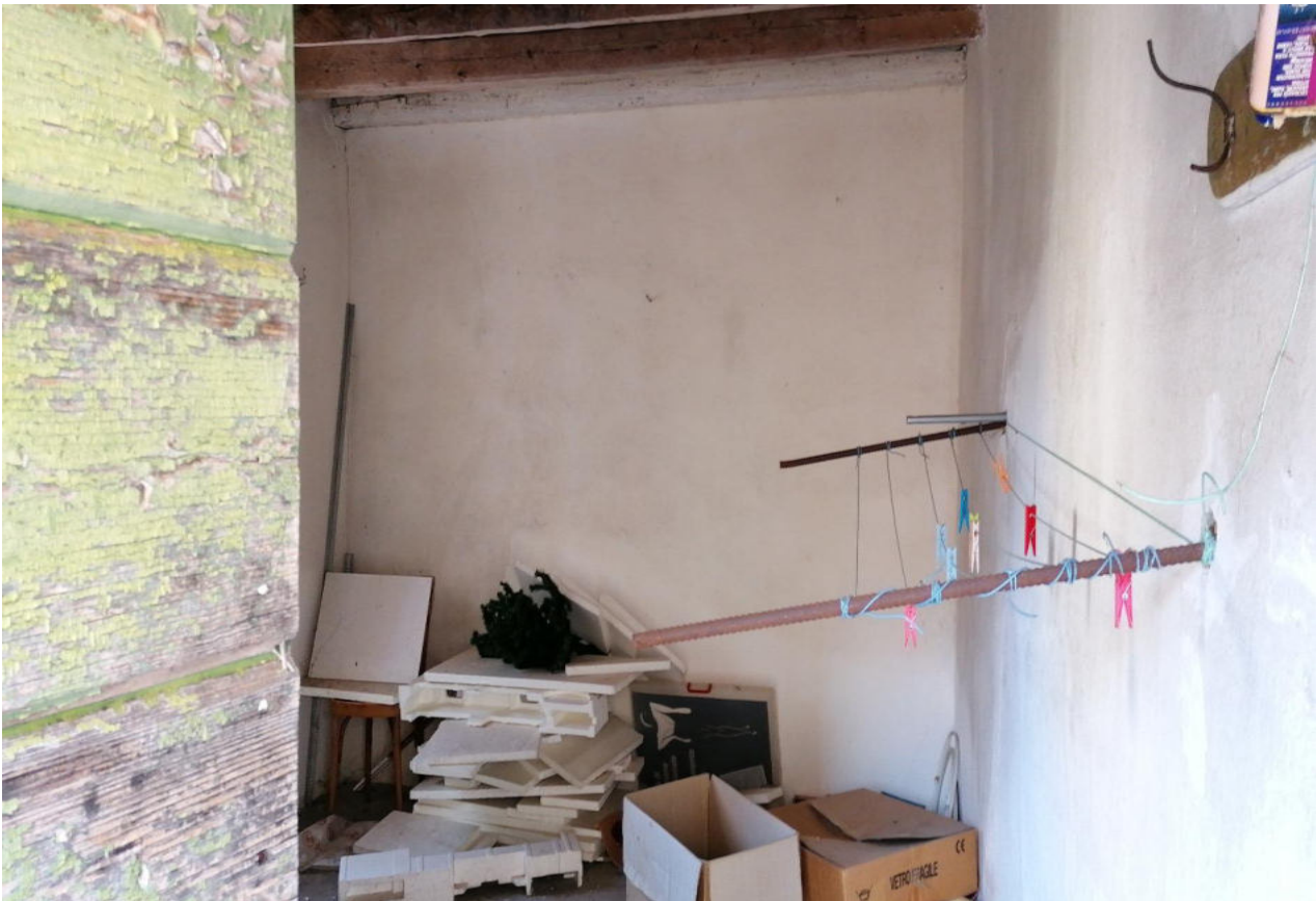
FOTO N.27 FOGGIO A/4 MAPPALE 309 COMUNE DI ARBA (PN)
