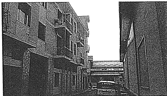
Facciata di ingresso principale- edificio su strada
