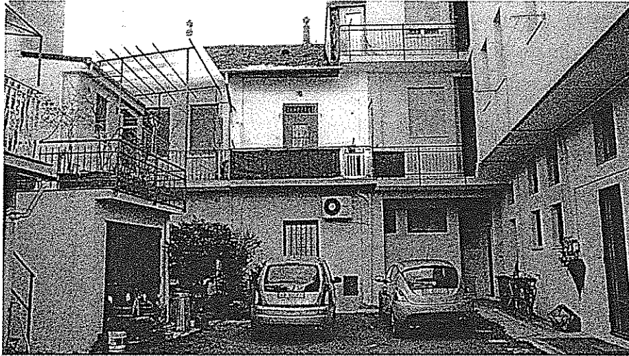
Facciata interna casa a corte – unità immobiliare periziata
