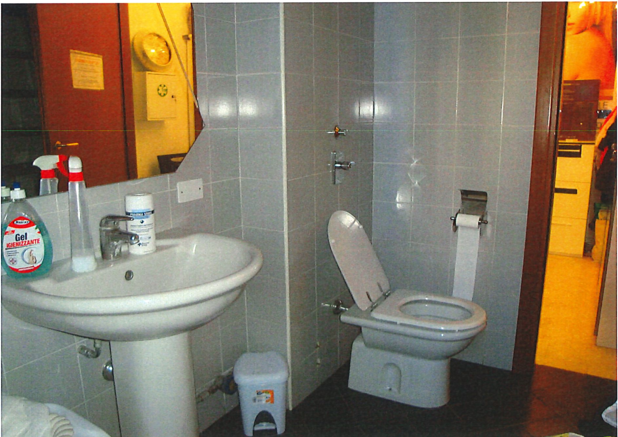
Milano , Via Eustachi n.°19 : negozio al Foglio 316, mapp. 376, sub 5 Prospetti interni: il bagno con finestra sul cortile interno
