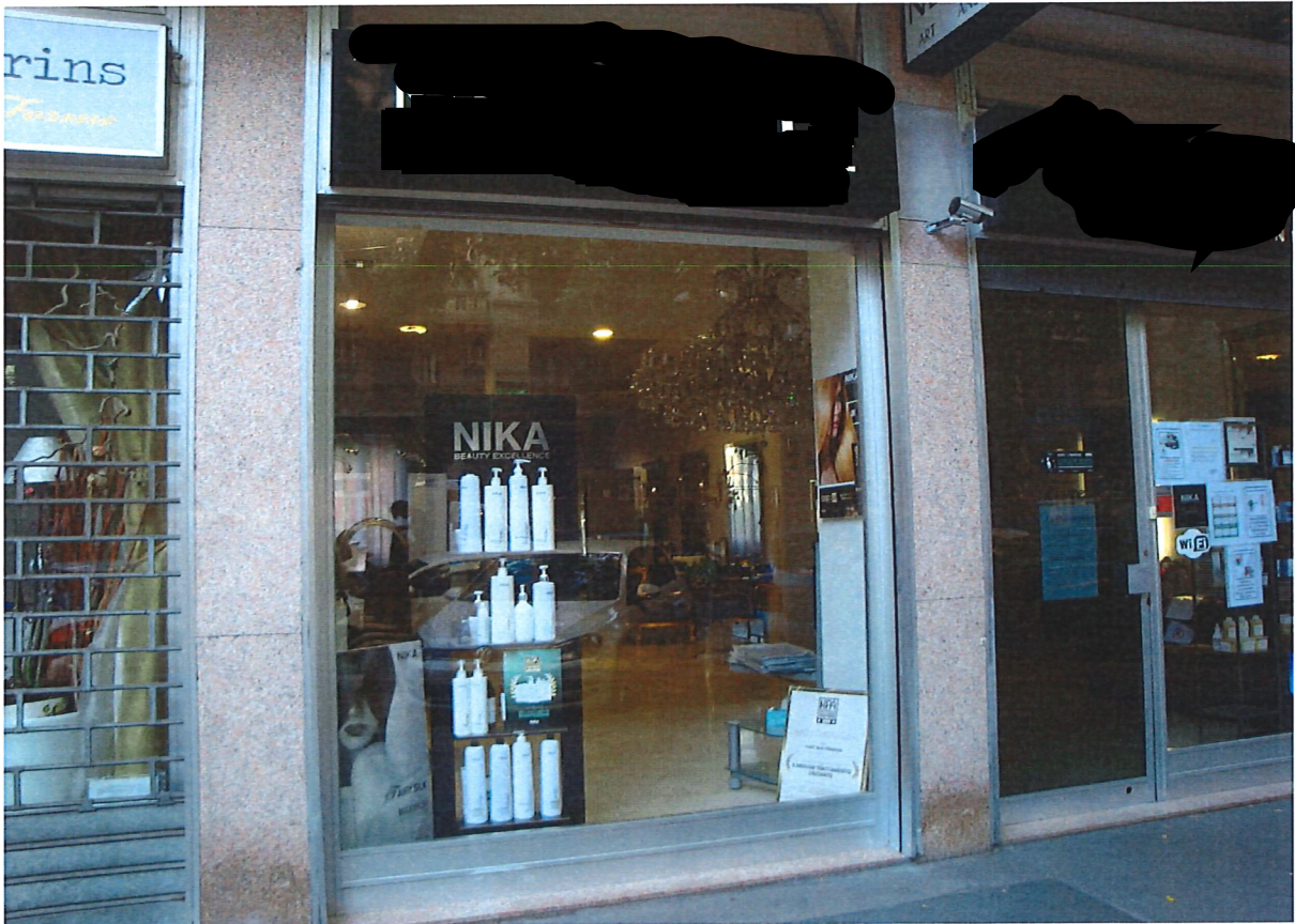
Milano , Via Eustachi n.°19 : negozio al Foglio 316, mapp. 376, sub 5 Prospetti esterni: le due vetrine con affaccio su Via Eustachi
