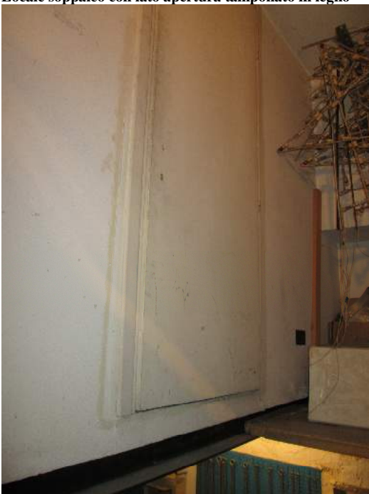
Locale soppalco con lato apertura tamponato in legno
