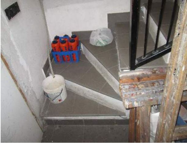
Scala di collegamento al soppalco
