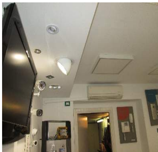
Solaio e controsoffitto
