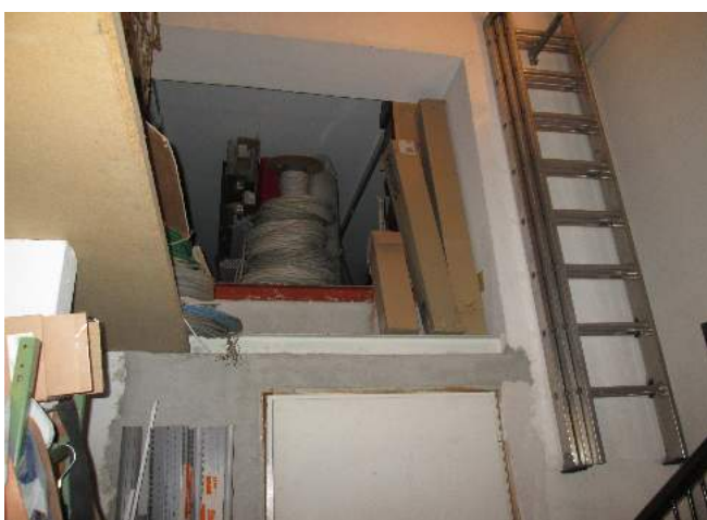
Solaio negozio non autorizzato-usufruito a ripostiglio in quota
