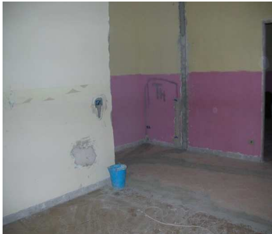
Foto 1 Il tramezzo demolito nell'ingresso
