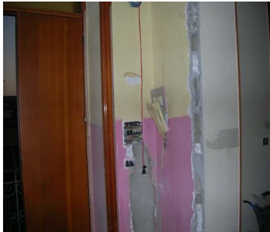
Foto 2 I lavori in corso agli impianti
