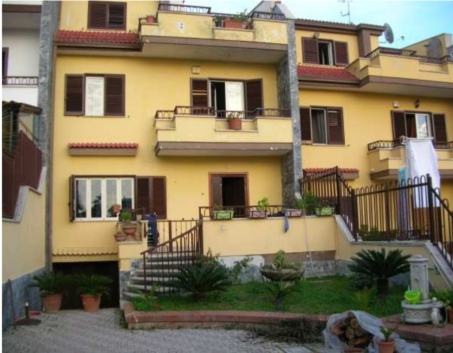
Foto 27 Il prospetto principale
