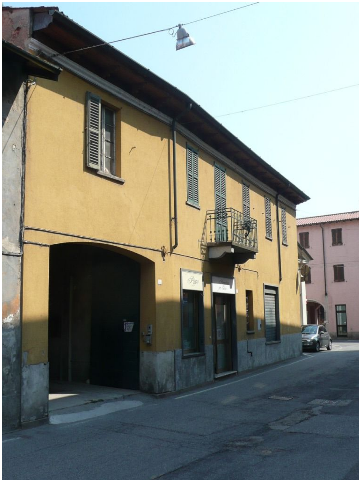
FACCIATA SU STRADA
