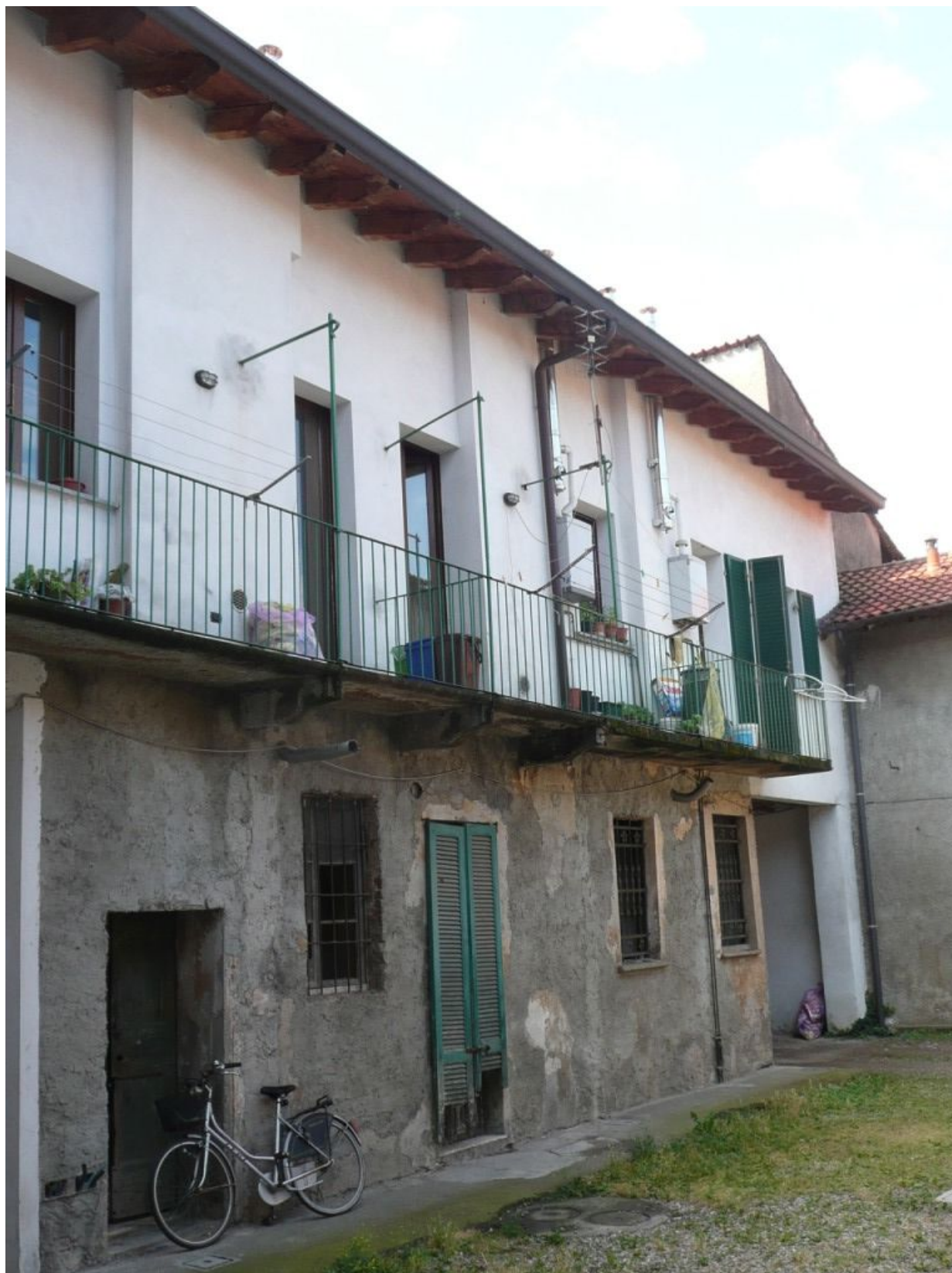
FACCIATA SU CORTILE POSTERIORE
