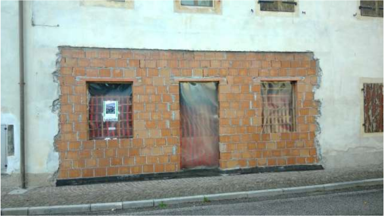
Foto n. 2 – Comune di Travesio (PN) – frazione Toppo - "Corte Dal Nodâr"- Lotto 2 – Foglio 8, Unità 5 – Piano terra – Veduta, da Via della Fornace, della facciata esterna dell'unità abitativa al grezzo.
