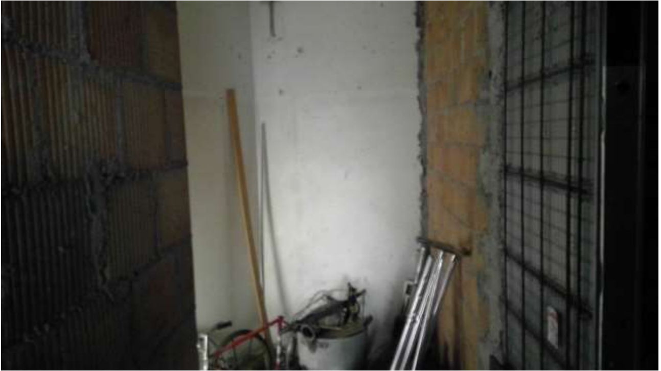
Foto n. 5 – Comune di Travesio (PN) – frazione Toppo - "Corte Dal Nodâr"- Lotto 2 – Foglio 8, Unità 5 – Piano terra– Veduta di porzione del vano al grezzo destinato a bagno.
