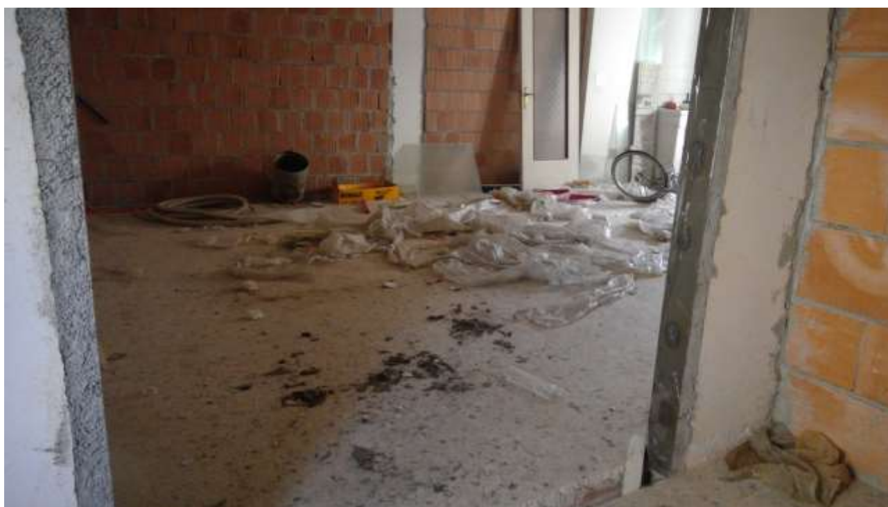
Foto n. 4 – Comune di Travesio (PN) – frazione Toppo - "Corte Dal Nodâr"- Lotto 2 – Foglio 8, Unità 6 – Piano terra – Accesso all'ampio vano destinato a cucina-sala da pranzo-soggiorno, posto a sinistra rispetto alla porta d'ingresso.
