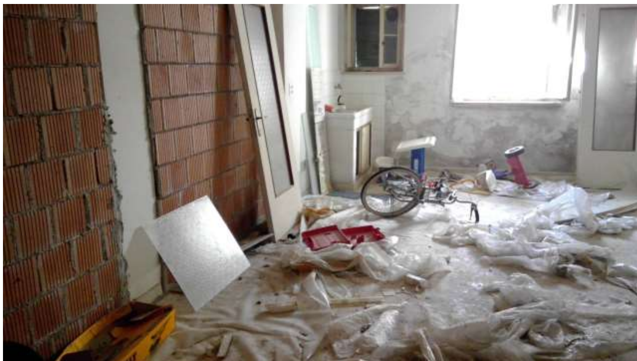
Foto n. 5 – Comune di Travesio (PN) – frazione Toppo - "Corte Dal Nodâr"- Lotto 2 – Foglio 8, Unità 6 – Piano terra – Veduta interna di parte del vano destinato a cucina-sala da pranzo-soggiorno.
