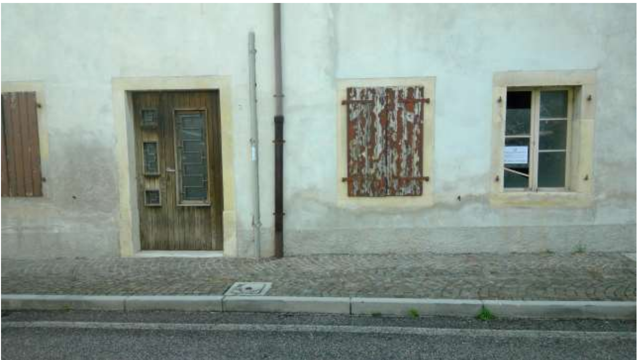
Foto n. 2 – Comune di Travesio (PN) – frazione Toppo - “Corte Dal Nodâr”- Lotto 2 – Foglio 8, Unità 6 – Esterni – Particolare dei vecchi serramenti e della porta d’accesso da Via della Fornace.
