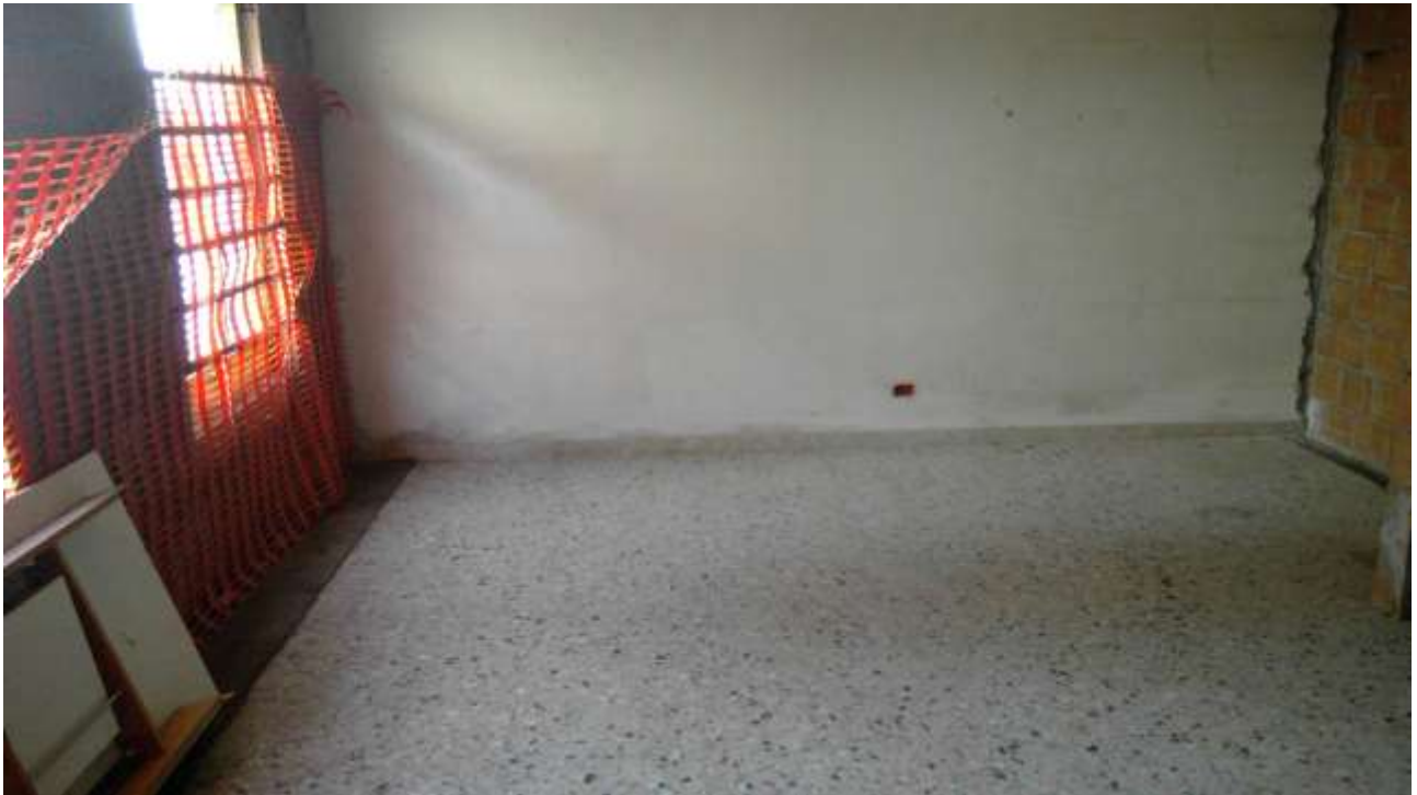
Foto n. 3 – Comune di Travesio (PN) – frazione Toppo - "Corte Dal Nodâr"- Lotto 2 – Foglio 8, Unità 5 – Piano terra – Veduta interna del vano destinato a cucina-soggiorno; a sinistra l'ingresso da Via della Fornace.
