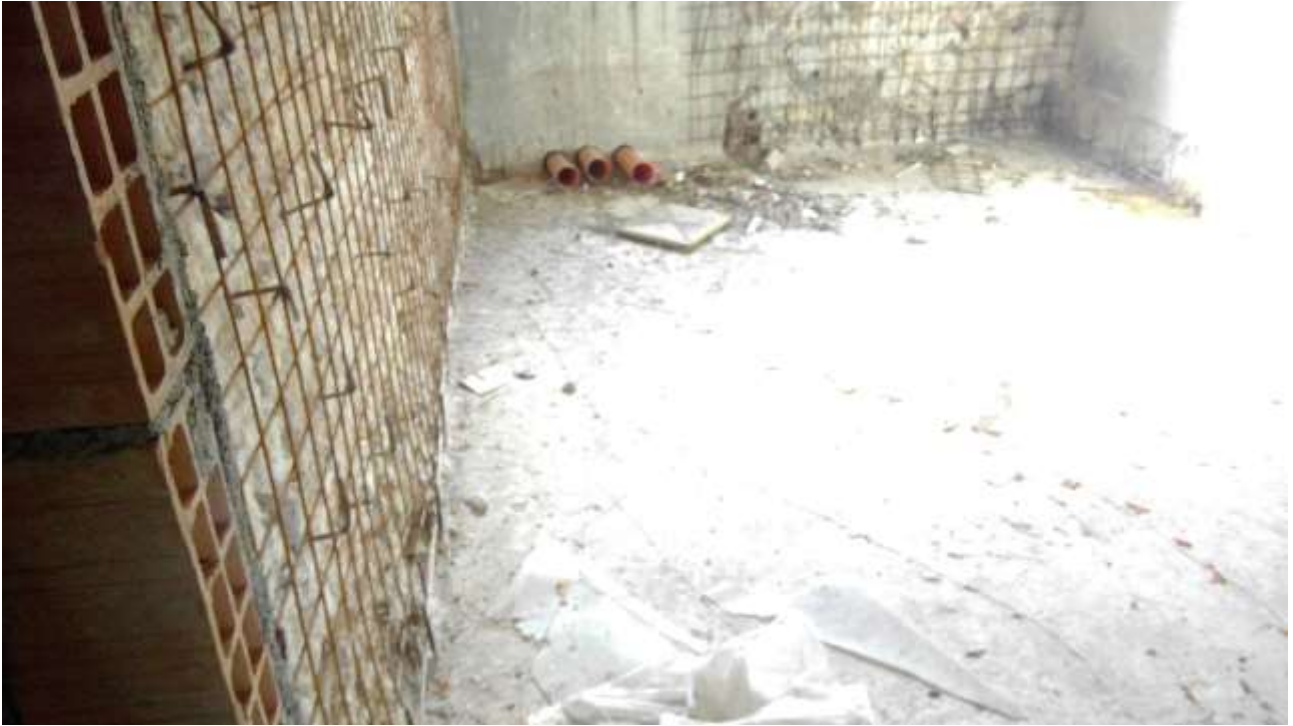
Foto n. 8 – Comune di Travesio (PN) – frazione Toppo - "Corte Dal Nodâr"- Lotto 2 – Foglio 8, Unità 6 – Piano terra – Veduta interna del vano destinato a bagno.
