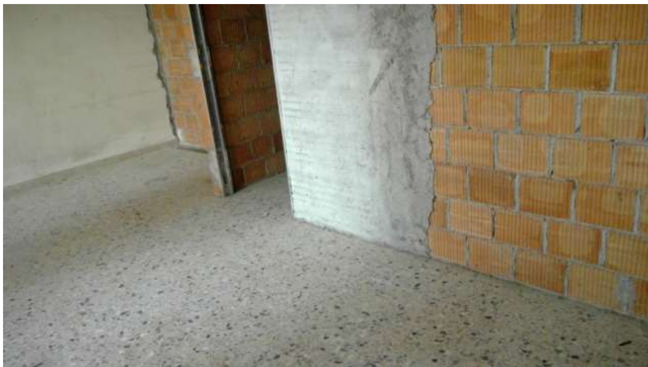
Foto n. 4 – Comune di Travesio (PN) – frazione Toppo - "Corte Dal Nodâr"- Lotto 2 – Foglio 8, Unità 5 – Piano terra – Vano destinato a cucina-soggiorno; visibile l' accesso al disimpegno che porta alla camera e al bagno.
