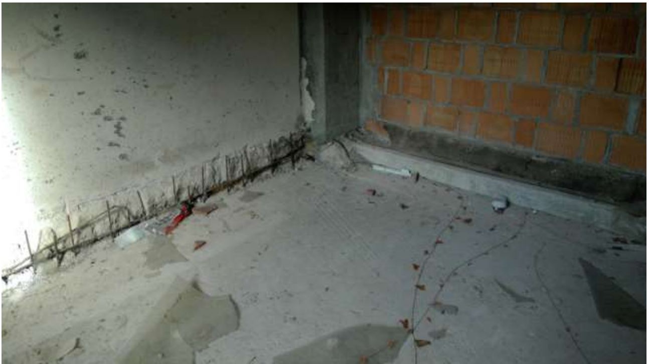
Foto n. 11 – Comune di Comune di Travesio (PN), Via dei Masi – frazione Toppo - “Corte Dal Nodâr”- Lotto 2 – Foglio 8, Unità 6 – Piano terra – Porzione del vano destinato a camera nord.
