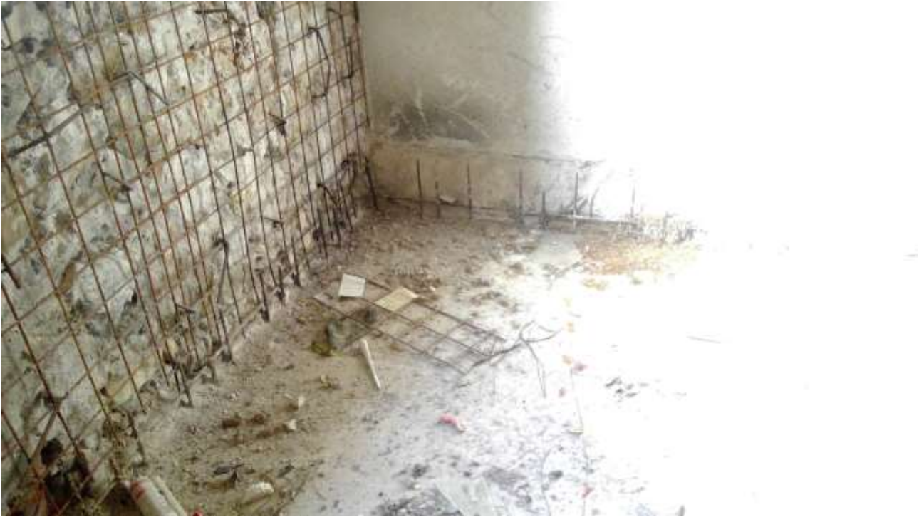
Foto n. 10 – Comune di Travesio (PN) – frazione Toppo - “Corte Dal Nodâr”- Lotto 2 – Foglio 8, Unità 6 – Piano terra – Porzione del vano destinato a camera sud.
