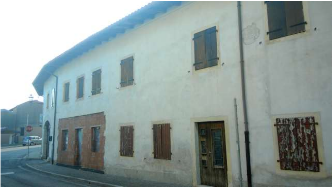
Foto n. 1 – Comune di Travesio (PN) – frazione Toppo - “Corte Dal Nodâr”- Lotto 2 – Foglio 8 – Piano terra – Veduta, da Via della Fornace, della facciata esterna dell’unità abitativa 6; in secondo piano la U5.
