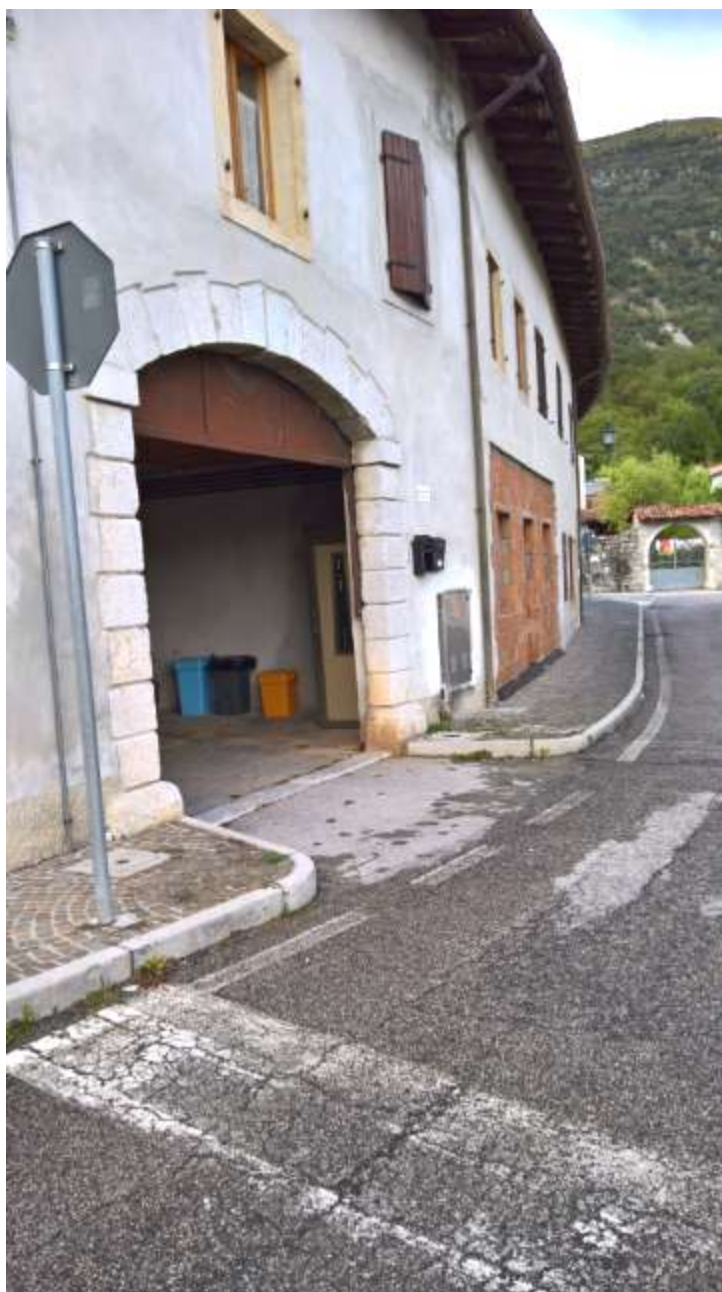
Foto n. 1 -Comune di Travesio (PN) - frazione Toppo - "Corte Dal Nodâr"- Lotto 2 - Foglio 8 - Esterni - Veduta, da Via della Fornace, del portico d'accesso alla corte comune.
