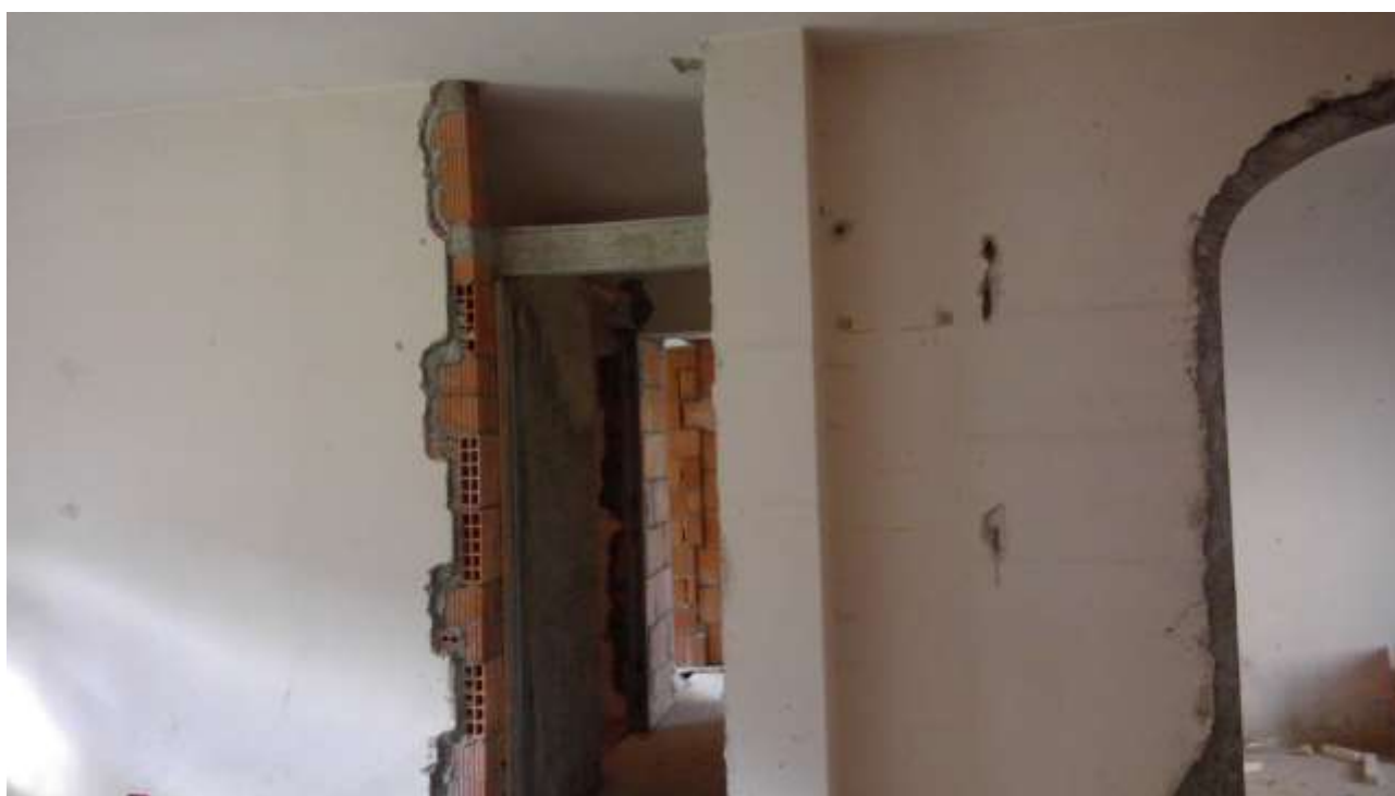
Foto n. 6 – Comune di Travesio (PN) – frazione Toppo - "Corte Dal Nodâr"- Lotto 2 – Foglio 8, Unità 6 – Piano terra – Veduta del corridoio di accesso al bagno e alle camere.
