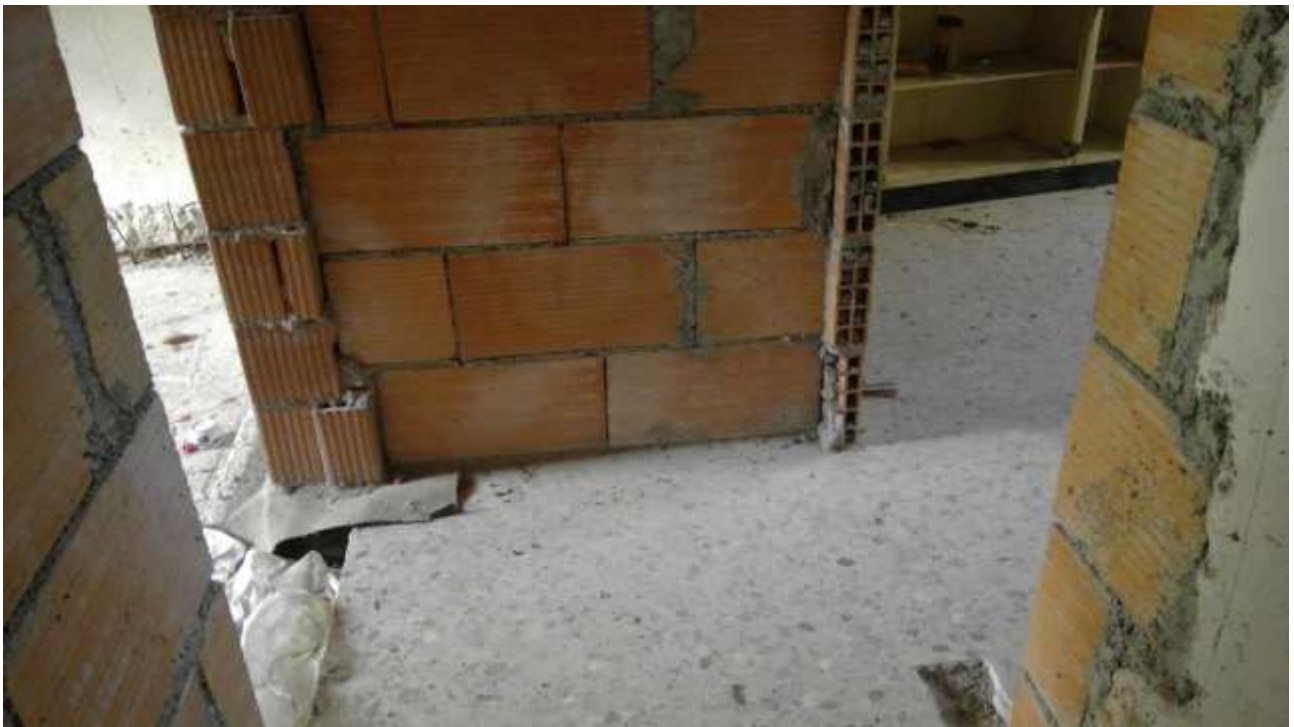
Foto n. 9 – Comune di Travesio (PN) – frazione Toppo - "Corte Dal Nodâr"- Lotto 2 – Foglio 8, Unità 6 – Piano terra – Particolare del corridoio d' accesso alle due camere da letto.
