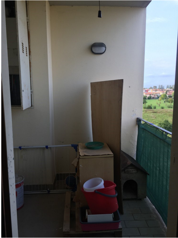
vista esterna poggiolo lato nord
