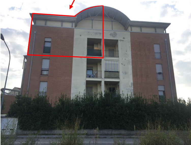
prospetto nord del condominio "Residenza le Orchidee" Edificio A
