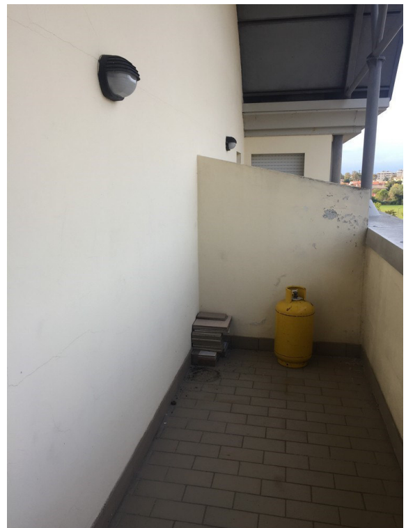
vista esterna poggiolo al quarto piano lato nord
