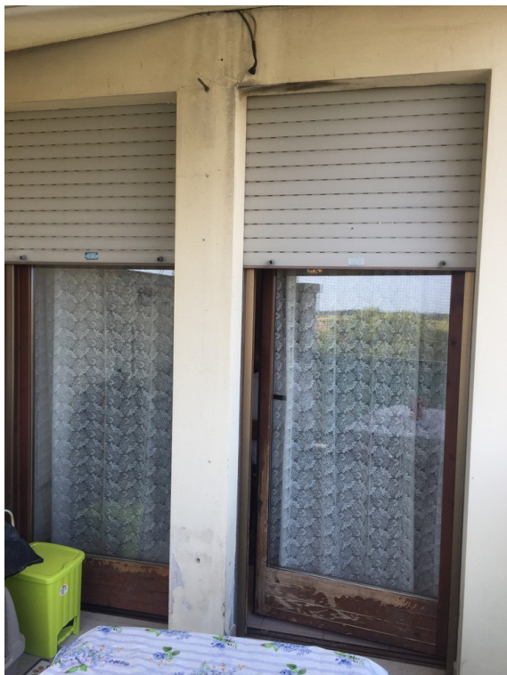
ulteriore vista esterna poggiolo lato est
