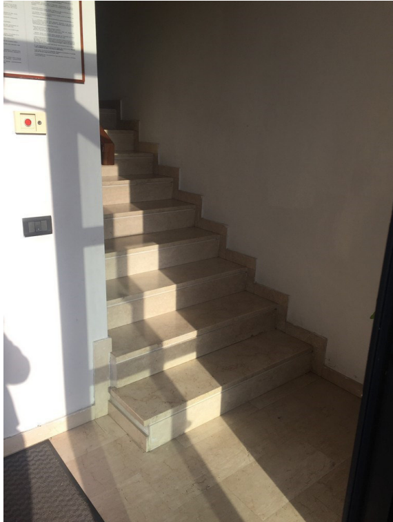
vista vano scala comune al piano terra
