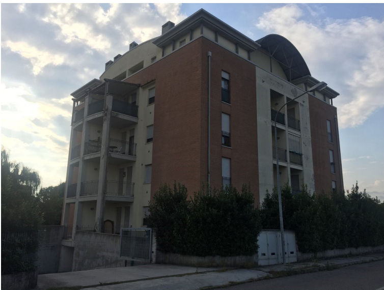
particolare accesso carraio
