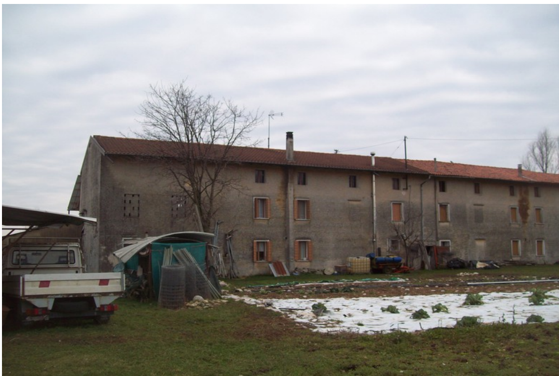
Foto 2: Prospetto Nord abitazione
