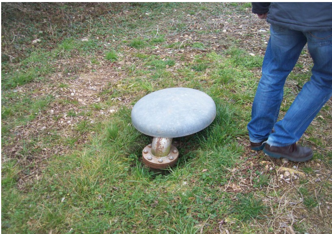
Foto 2: Attacco per irrigazione
