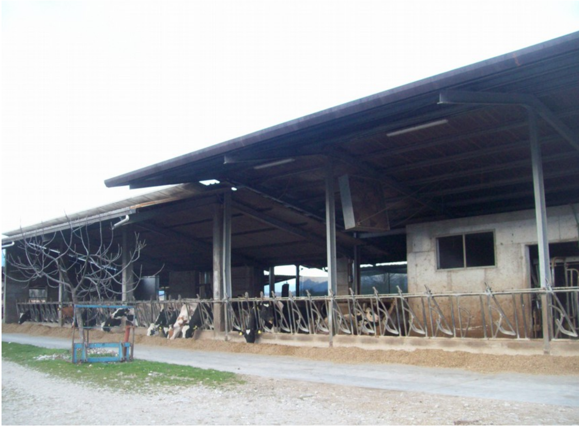
Foto 30: Prospetto Nord-Ovest stalla
