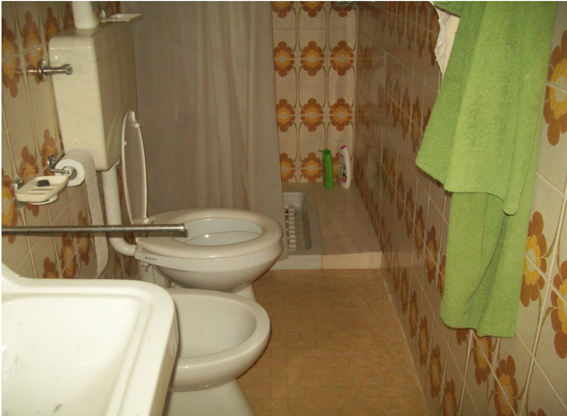
Foto 17: Doccia con accesso dal ripostiglio
