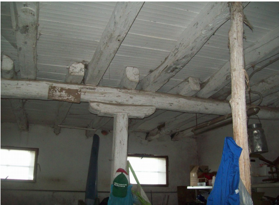
Foto 18: Deposito piano terra
