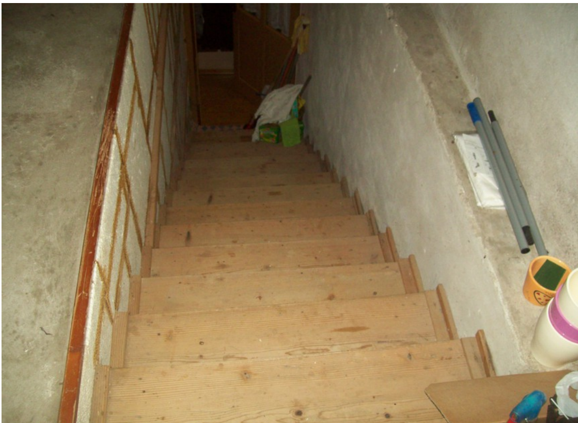
Foto 14: Scala nella soffitta
