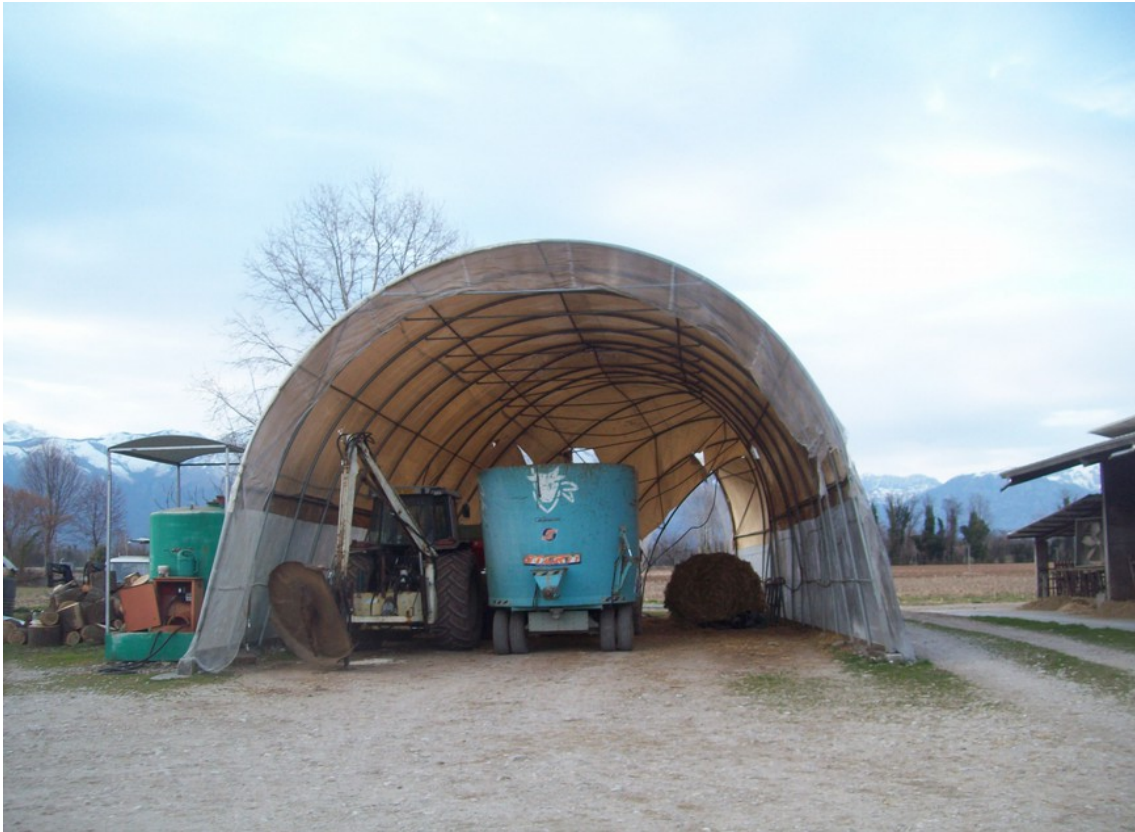
Foto 26: Tunnel ricovero scorte agricole
