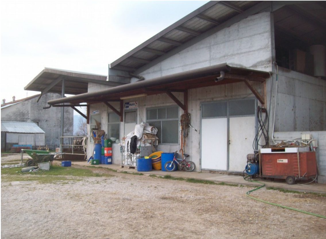
Foto 28: Prospetto principale stalla
