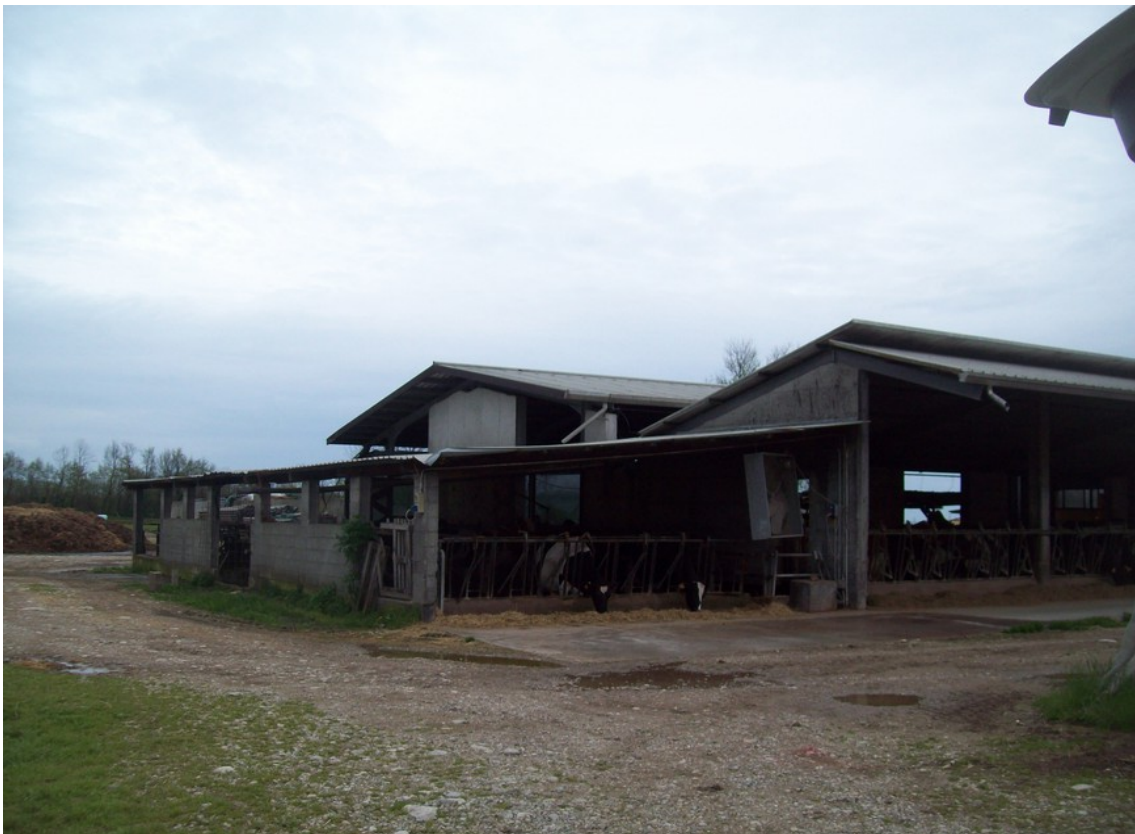
Foto 31: Vista stalla da Ovest
