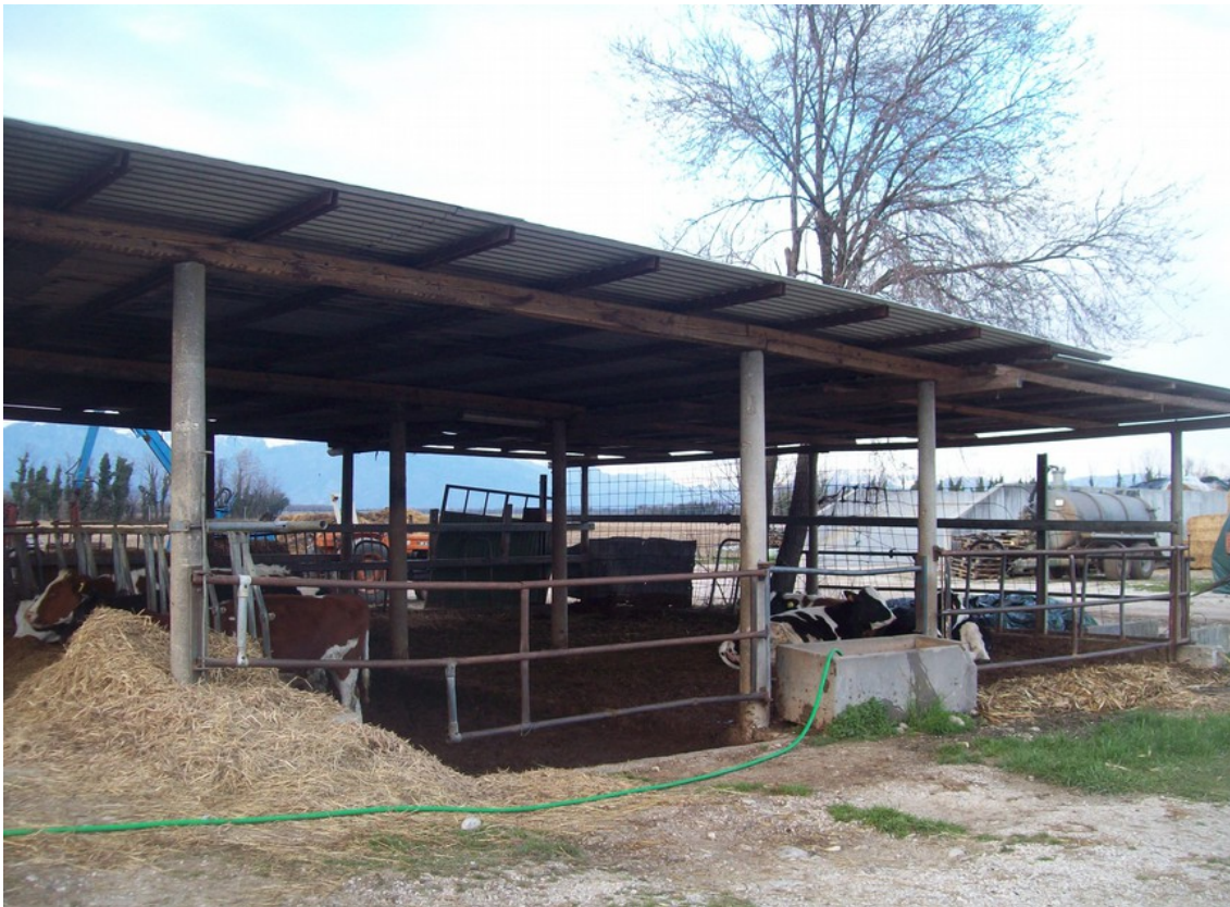
Foto 36: Prospetto angolo Sud-Ovest ricovero
