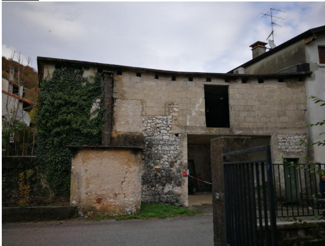
FOTO N.04 FOGLIO12, MAPPALE 155, COMUNE DI MONTEREALE VALCELLINA (PN)
