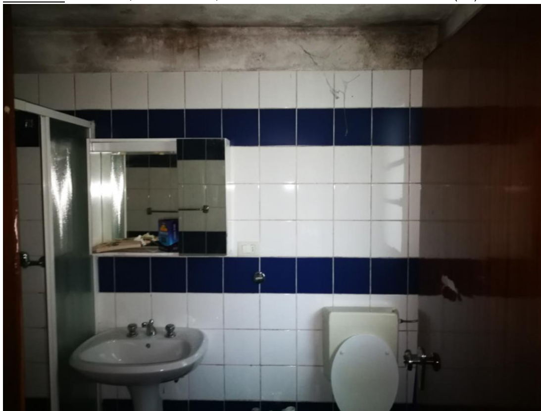
FOTO N.12 FOGLIO12, MAPPALE 155, COMUNE DI MONTEREALE VALCELLINA (PN)
