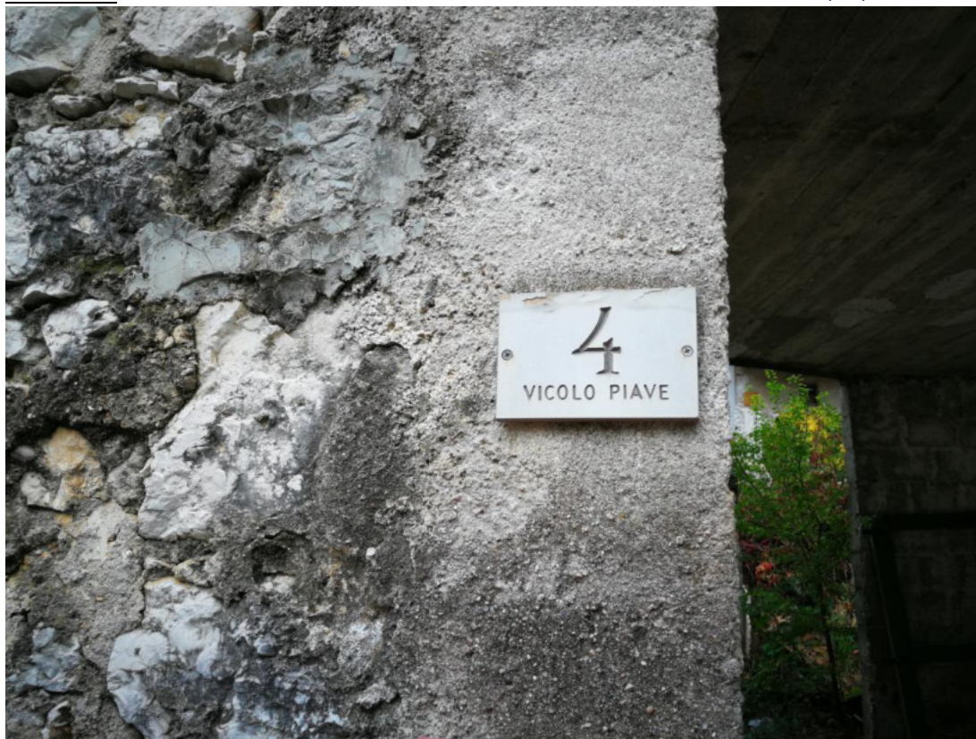
FOTO N.05 FOGLIO12, MAPPALE 155, COMUNE DI MONTEREALE VALCELLINA (PN)
