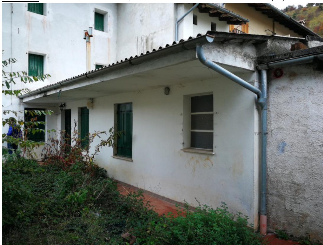
FOTO N.07 FOGLIO12, MAPPALE 155, COMUNE DI MONTEREALE VALCELLINA (PN)
