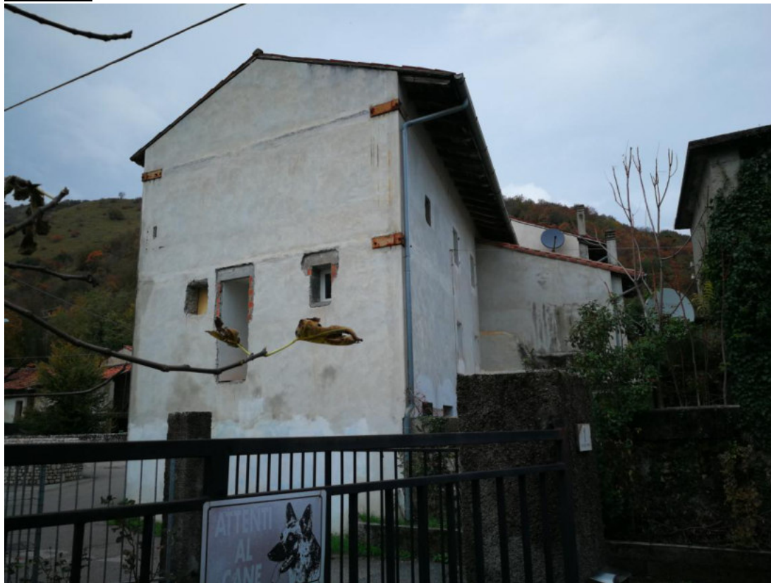
FOTO N.03 FOGLIO12, MAPPALE 155, COMUNE DI MONTEREALE VALCELLINA (PN)
