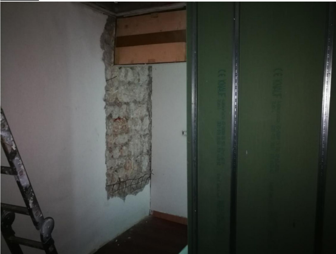
FOTO N.22 FOGLIO12, MAPPALE 155, COMUNE DI MONTEREALE VALCELLINA (PN)
