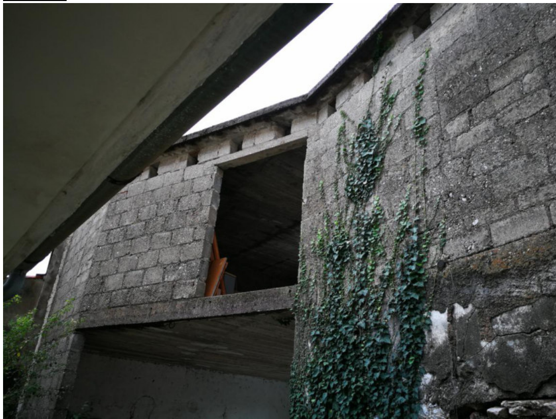
FOTO N.28 FOGLIO12, MAPPALE 155, COMUNE DI MONTEREALE VALCELLINA (PN)
