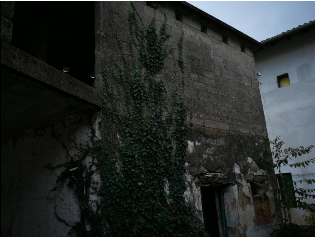
FOTO N.26 FOGLIO12, MAPPALE 155, COMUNE DI MONTEREALE VALCELLINA (PN)
