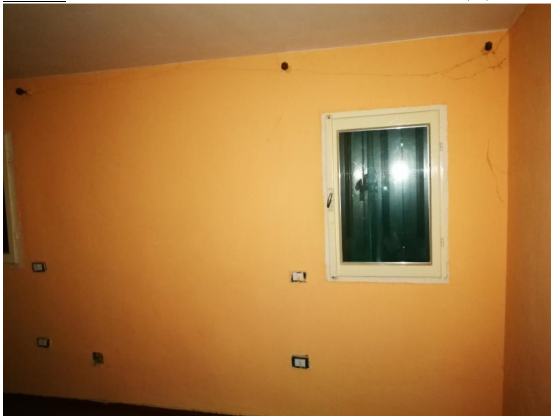
FOTO N.17 FOGLIO12, MAPPALE 155, COMUNE DI MONTEREALE VALCELLINA (PN)
