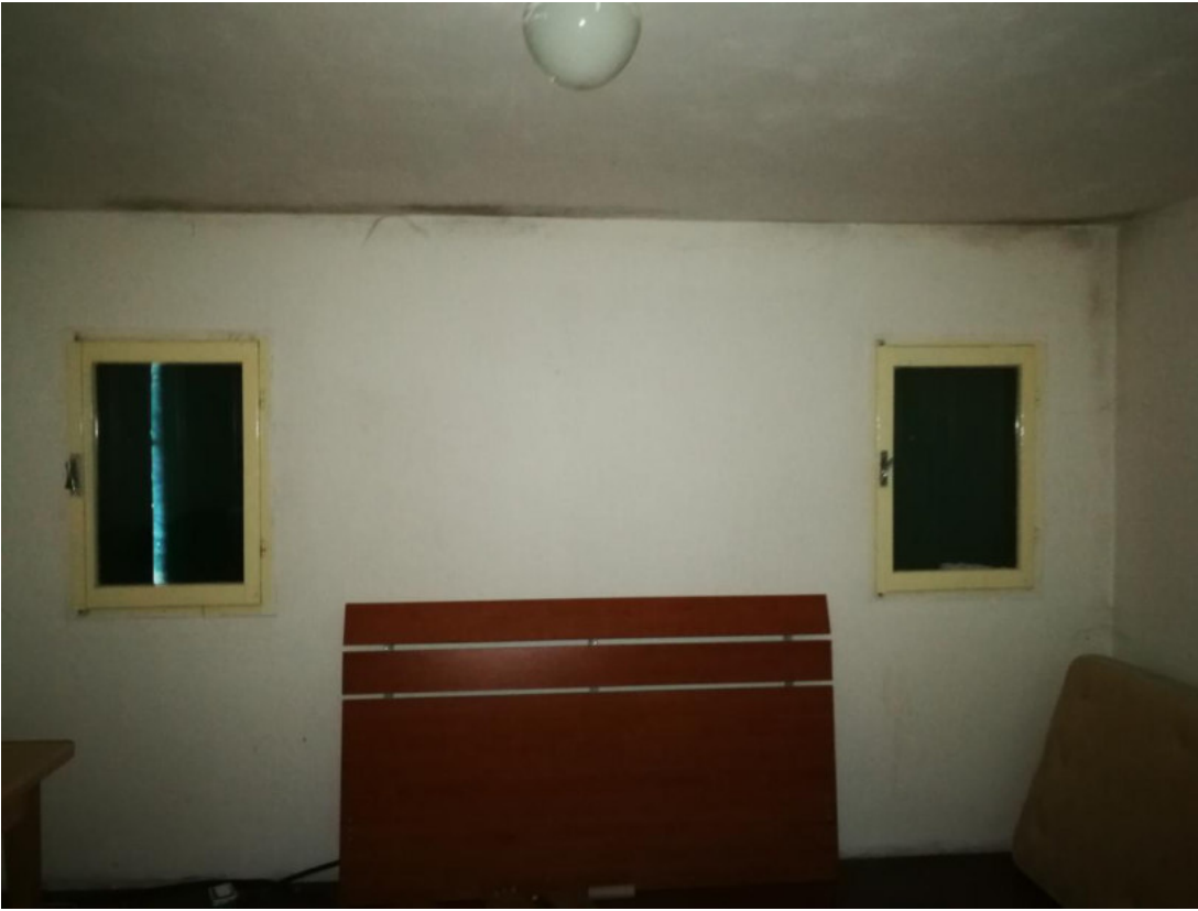
FOTO N.21 FOGLIO12, MAPPALE 155, COMUNE DI MONTEREALE VALCELLINA (PN)
