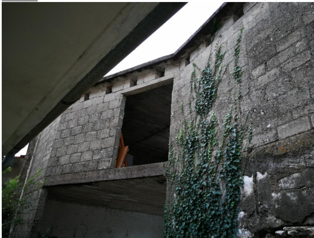
FOTO N.06 FOGLIO12, MAPPALE 155, COMUNE DI MONTEREALE VALCELLINA (PN)
