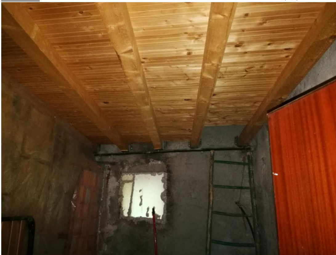
FOTO N.19 FOGLIO12, MAPPALE 155, COMUNE DI MONTEREALE VALCELLINA (PN)
