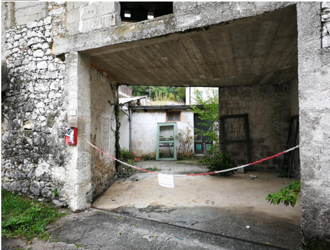
FOTO N.24 FOGLIO12, MAPPALE 155, COMUNE DI MONTEREALE VALCELLINA (PN)
