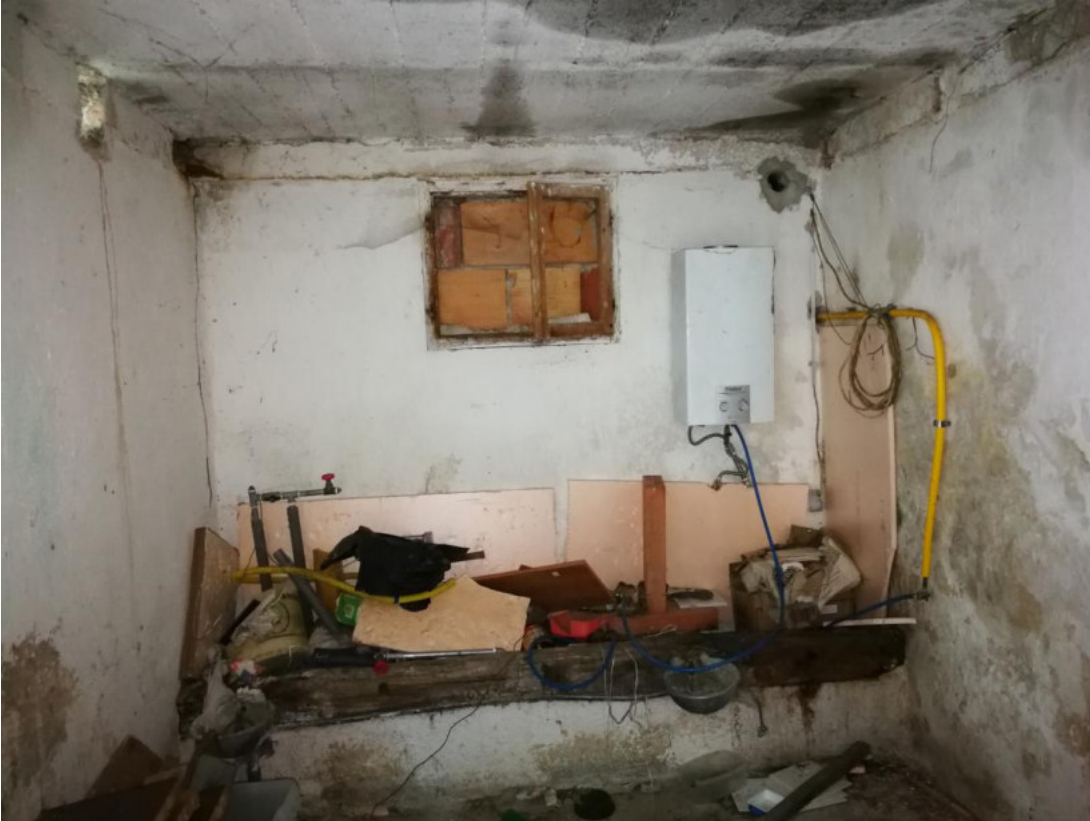
FOTO N.25 FOGLIO12, MAPPALE 155, COMUNE DI MONTEREALE VALCELLINA (PN)
