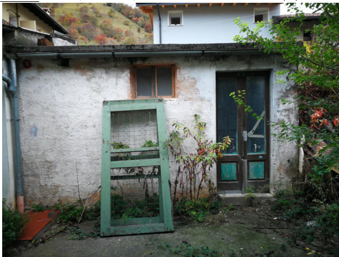
FOTO N.08 FOGLIO12, MAPPALE 155, COMUNE DI MONTEREALE VALCELLINA (PN)
