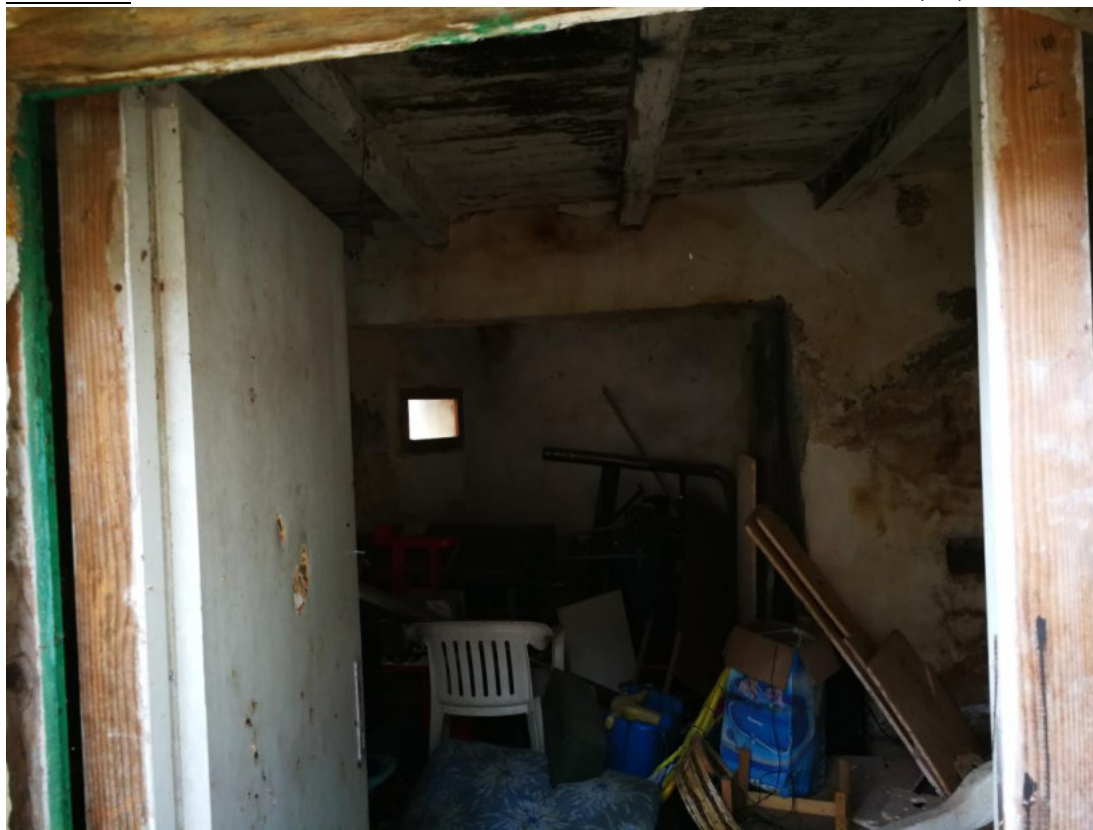
FOTO N.27 FOGLIO12, MAPPALE 155, COMUNE DI MONTEREALE VALCELLINA (PN)
