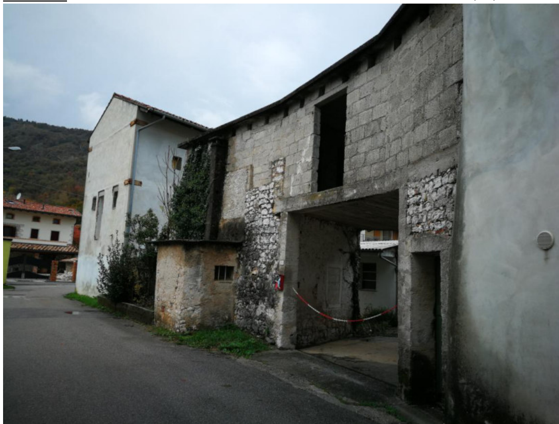
FOTO N.02 FOGLIO12, MAPPALE 155, COMUNE DI MONTEREALE VALCELLINA (PN)
