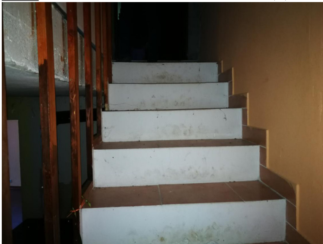
FOTO N.14 FOGLIO12, MAPPALE 155, COMUNE DI MONTEREALE VALCELLINA (PN)
