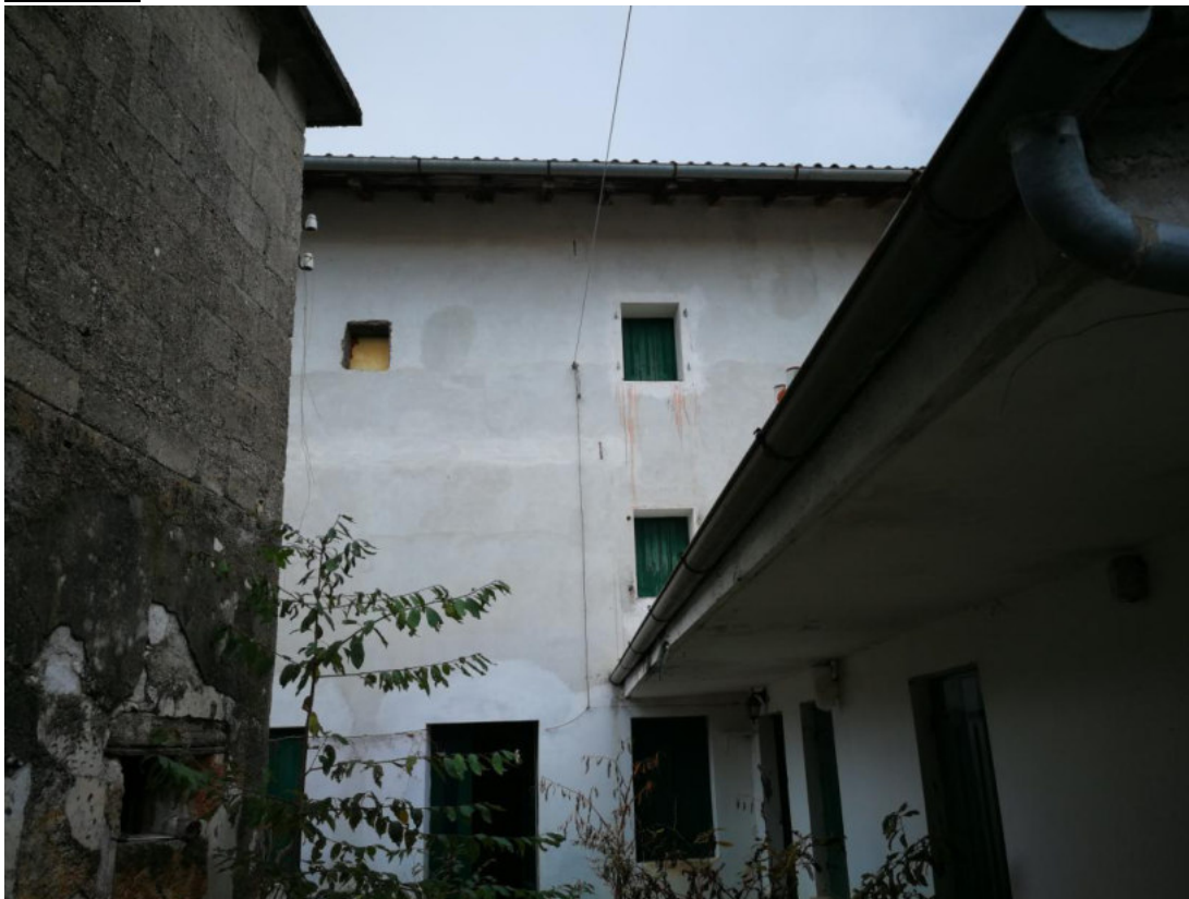
FOTO N.23 FOGLIO12, MAPPALE 155, COMUNE DI MONTEREALE VALCELLINA (PN)
