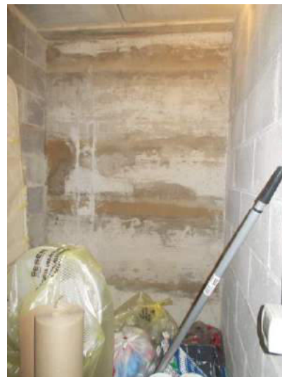
208. Interno della cantina
