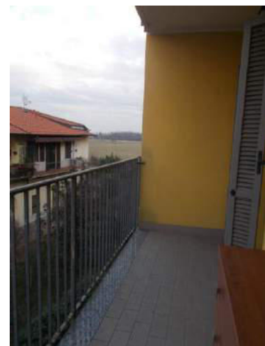
202. Balcone lato est
