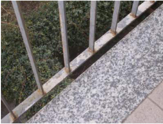
203. Dettaglio ringhiera balcone
