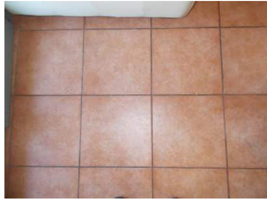
174. Pavimento del soggiorno/cucina
