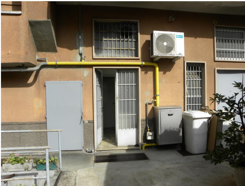
Cortile – Area comune condominiale
